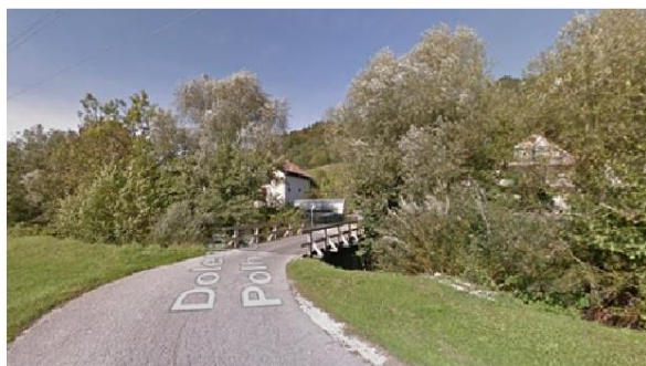
Slika 11: Lokacija merilne postaje Dvor - Gradaščica ( www.geopedia.si , www.google.si/maps , 2016)
