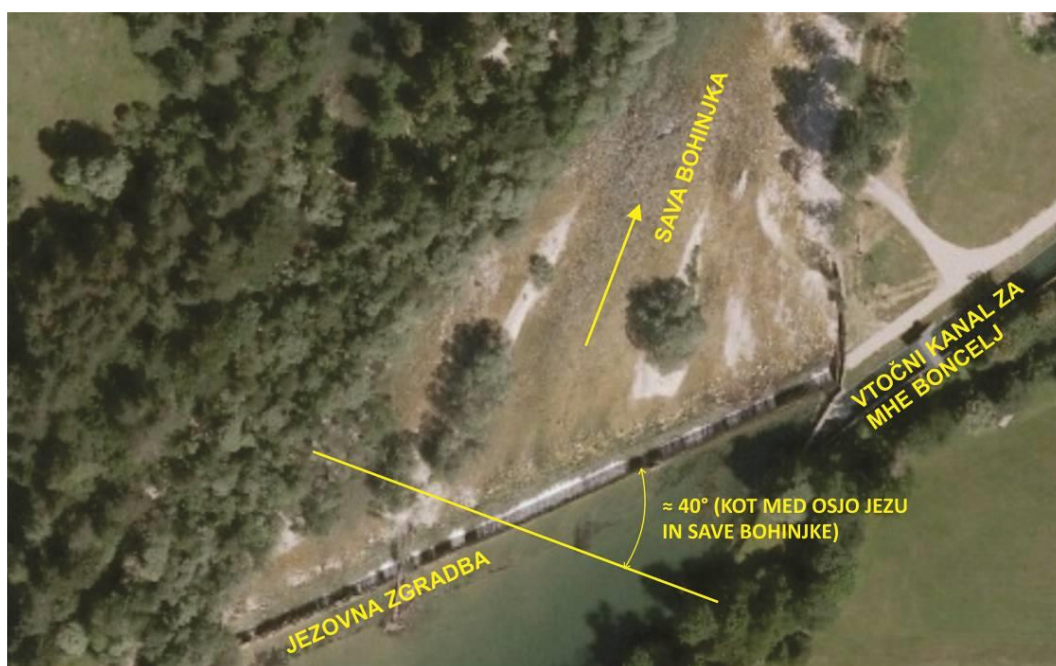
Slika 7: Ortofoto ožjega območja Cajhnovega zidu (Geopedia, zajem slike 23. 08. 2016.).
