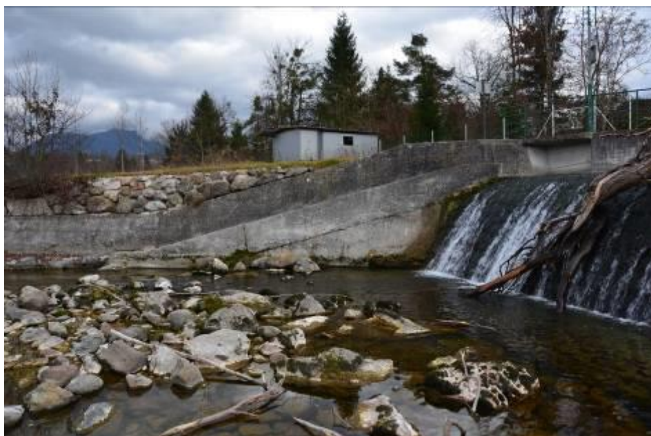
Slika 30: Stranski pogled na ribjo stezo; prikaz generalnega naklona ribje steze.
