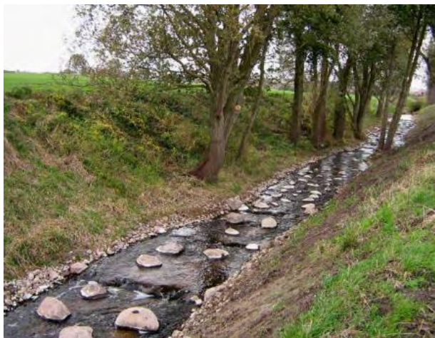
Slika 26: Prikaz hrapavega kanala z balvani.
