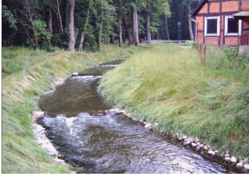
Slika 27: Primer obtočnega kanala.
