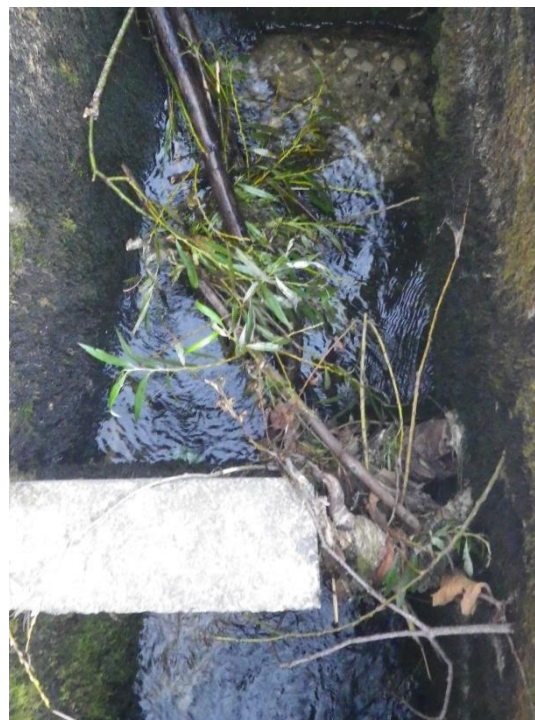
Slika 18: Naplavine v enem od bazenov ribje steze.
