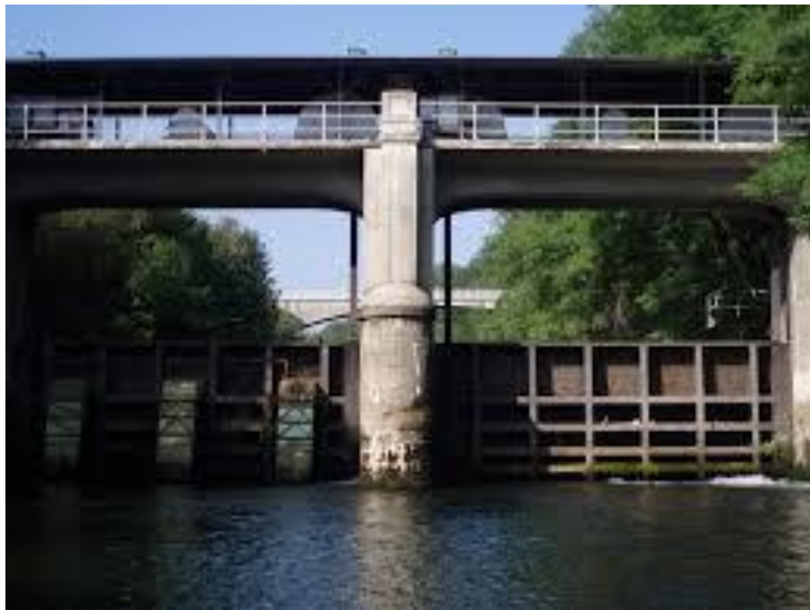
Slika 26: Zapornice na Gruberjevem kanalu ( http://mapio.net/o/5785324/ )
