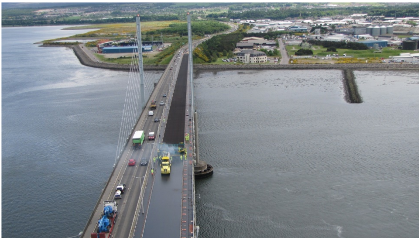
Slika 1: Strojno polaganje litega asfalta na mostu (world highways, 2016).
