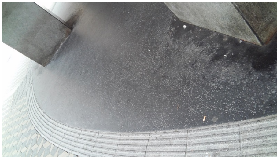
Slika 52: Izgled litega asfalta julij 2016
