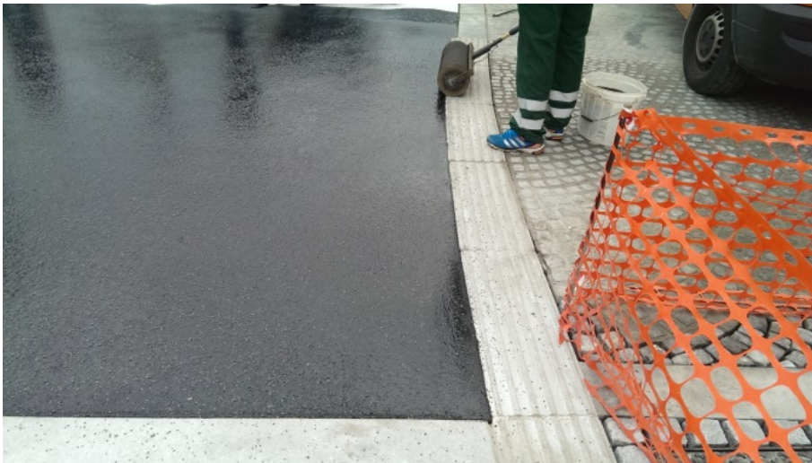
Slika 49: Tlakovanje pločnika
