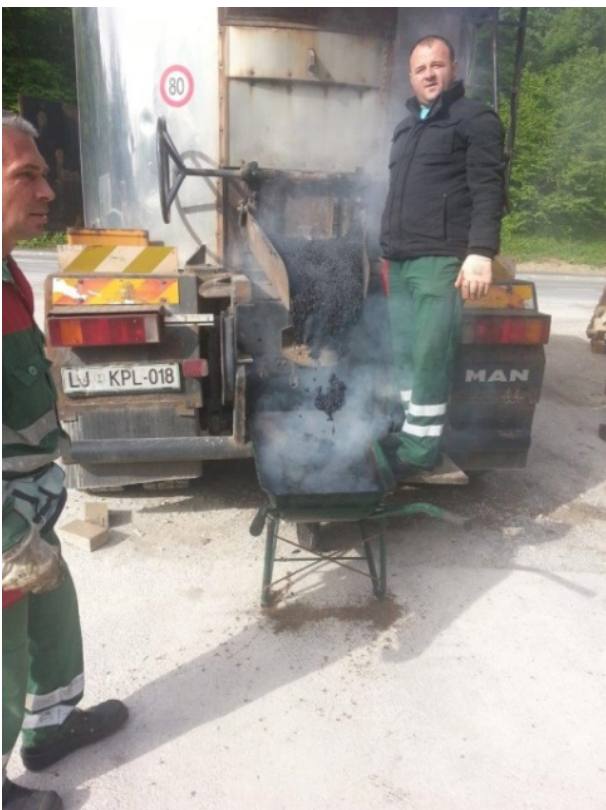
Slika 20: Točenje asfaltne zmesi v samokolnico
