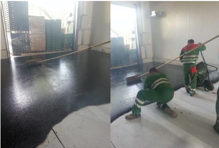
Slika 32: Valjanje z lesnim valjem
