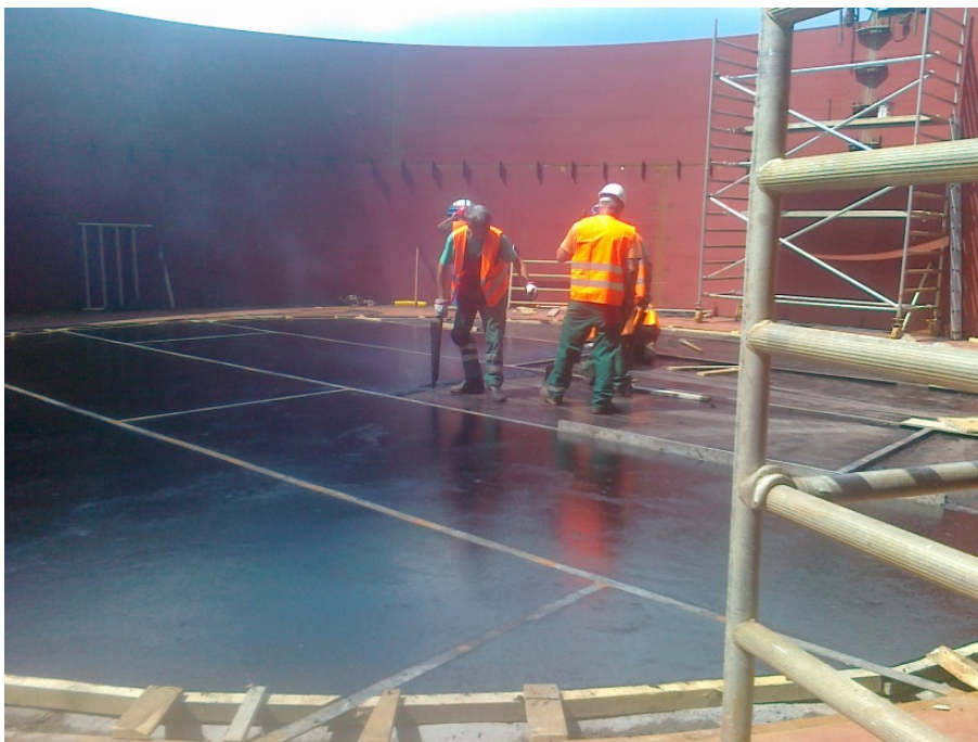
Slika 45: Primer uporabe litega asfalta kot premaz v rezervoarju
