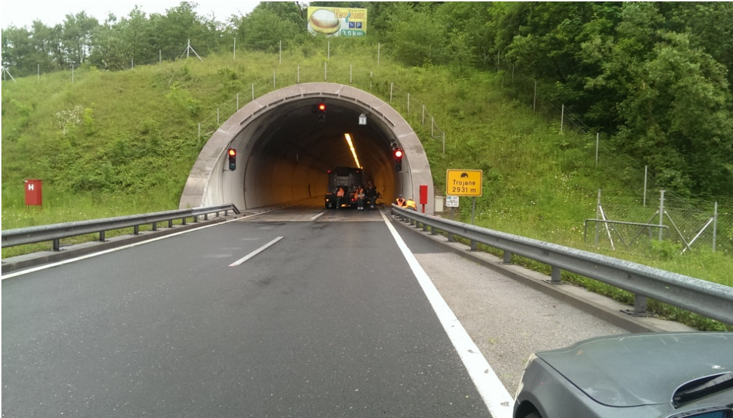
Slika 39: Hodnik za vzdrževalce v Trojanskem predoru
