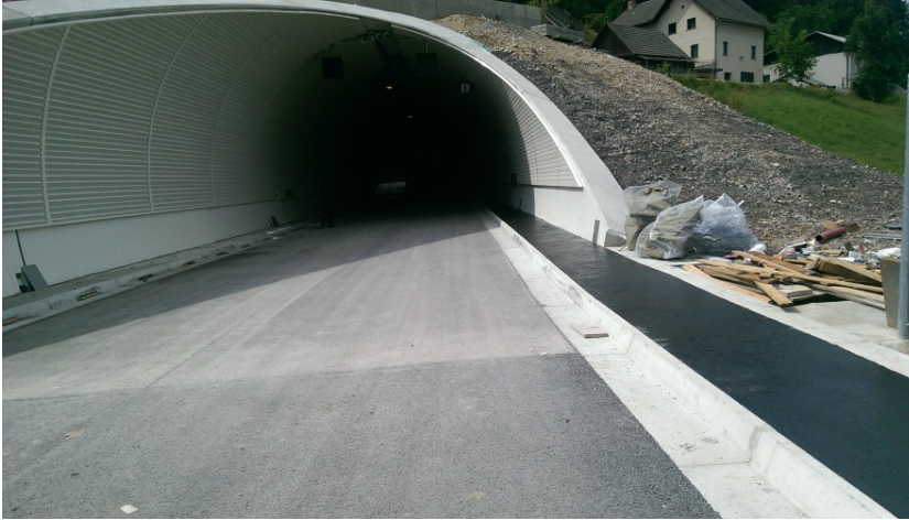
Slika 42: Tunel Markovec pločnik znotraj
