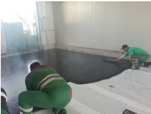
Slika 38: Primer litega asfalta v delavnici
