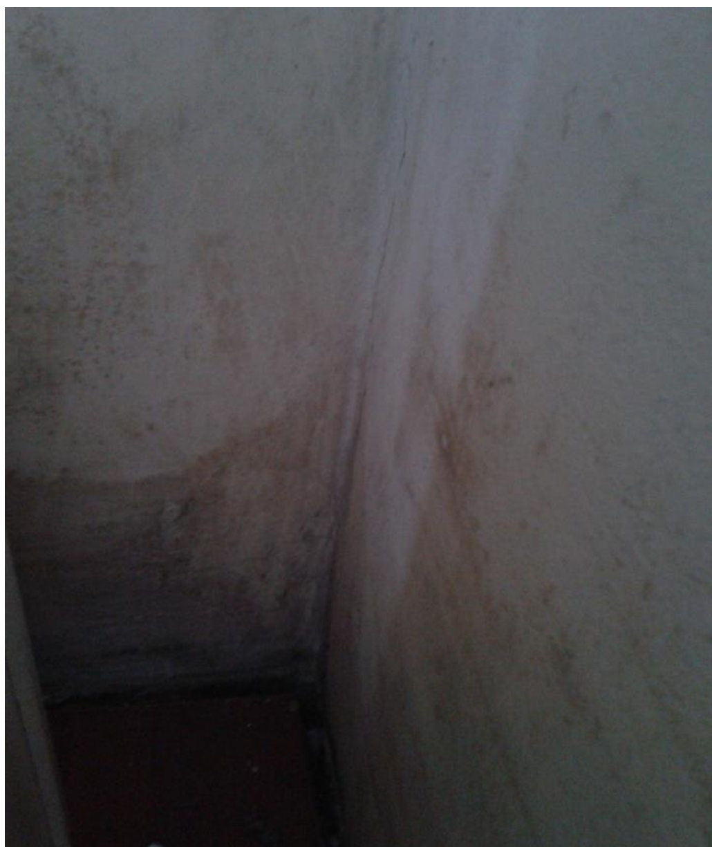
Slika 11: Stena spalnice, kjer se plesen pojavlja za omaro
