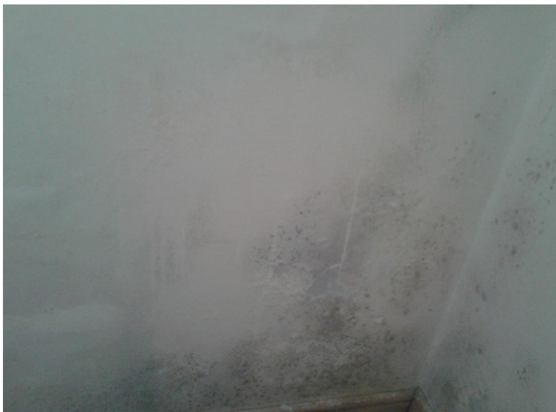
Slika 13: Kabinet, plesen po celotni površini stene
