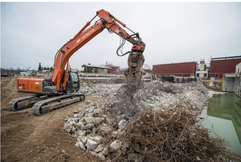
Slika 26: Ločevanje betonskih ruševin in armature (vir:CČN Domžale-Kamnik)
