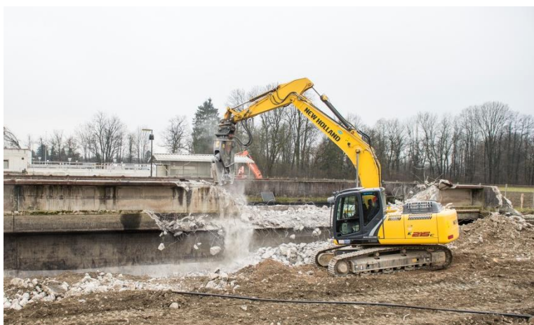
Slika 23: Rušenje bazenov CČN Domžale – Kamnik (vir:CČN Domžale-Kamnik)
