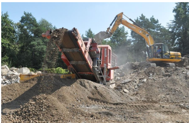
Slika 28:Drobljenje betonskih ruševin z drobilcem
