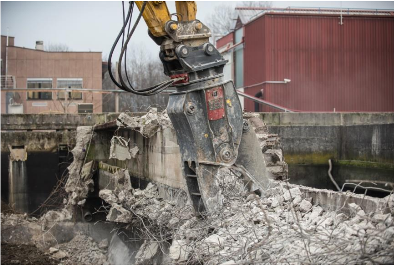
Slika 24: Hidravlične klešče za rušenje betona (vir:CČN Domžale-Kamnik)
