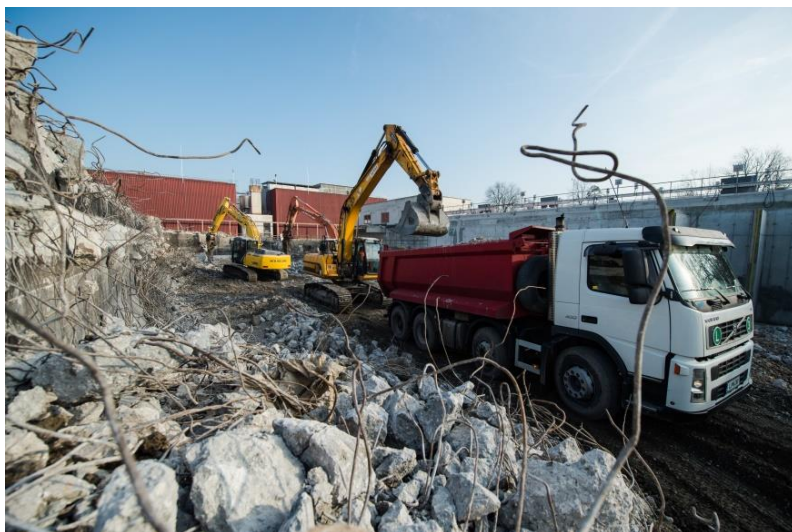
Slika 27: Nakladanje ruševin na kamione in odvoz v drobljenje (vir:CČN Domžale-Kamnik)
