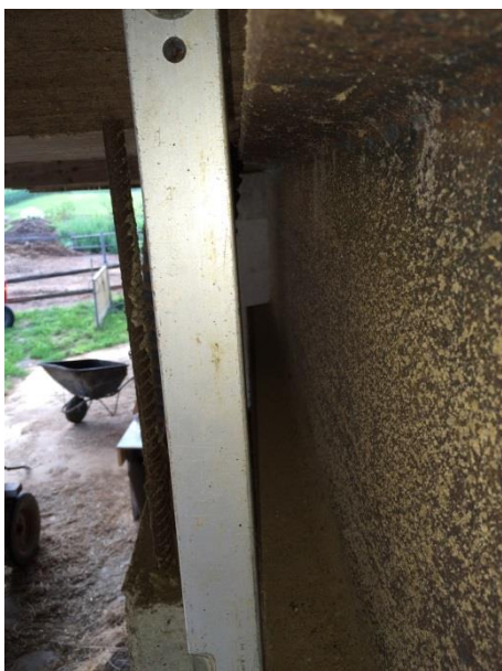
Slika 6: Zvrnitev jeklenega I profila
