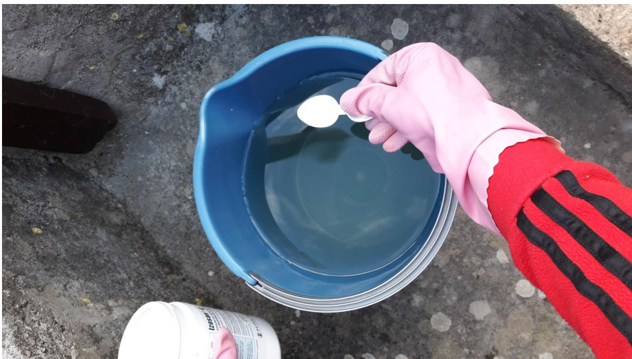
Slika 16: Priprava na kloriranje
