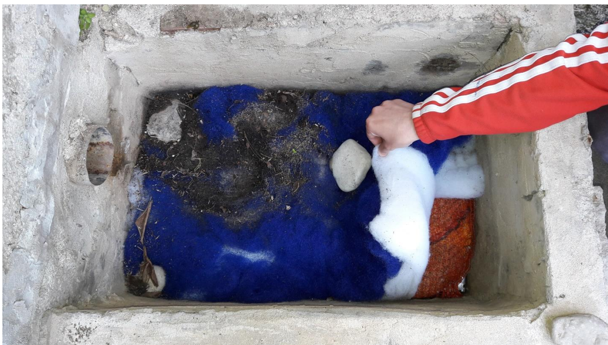
Slika 14: Prvi filter pred dotokom deževnice v cisterno
