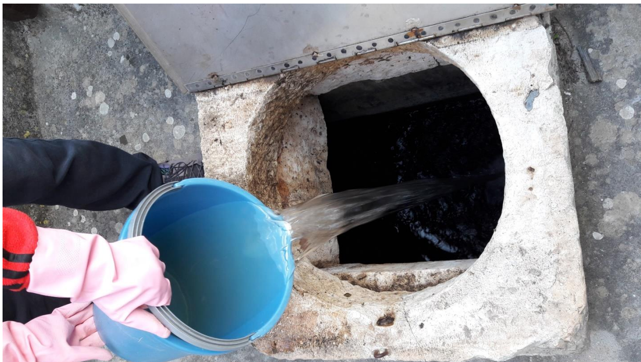
Slika 17: Kloriranje vode v cisterni
