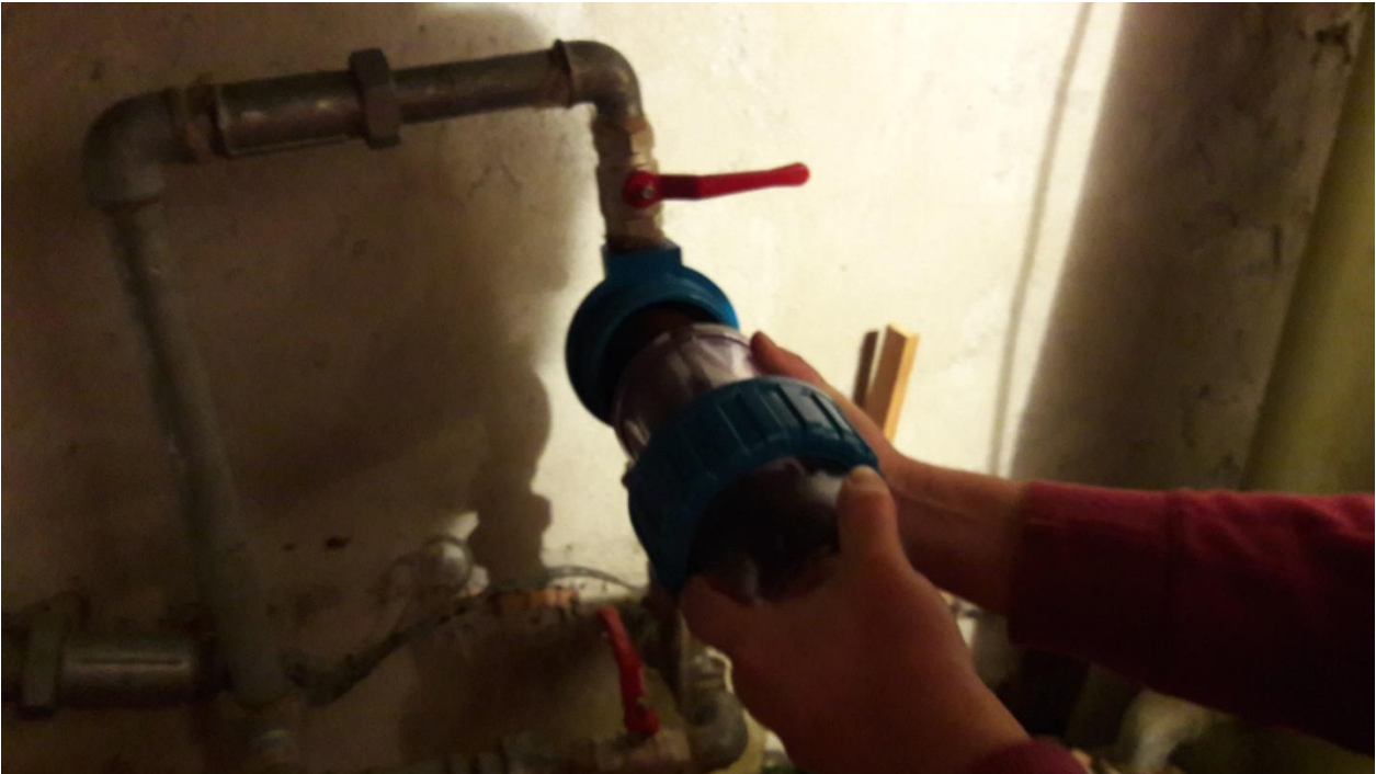
Slika 19: Menjava filtra z aktivnim ogljem
