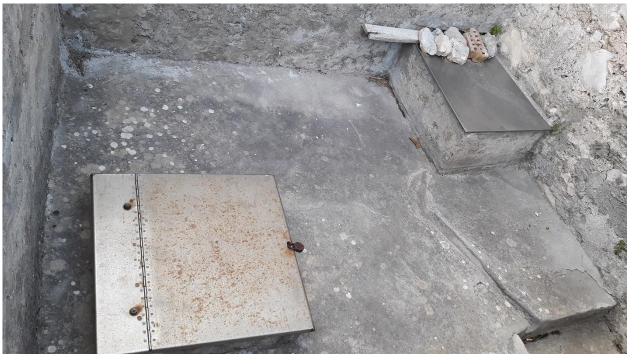
Slika 13: Cisterna in dotok v cisterno, kjer se nahaja filter
