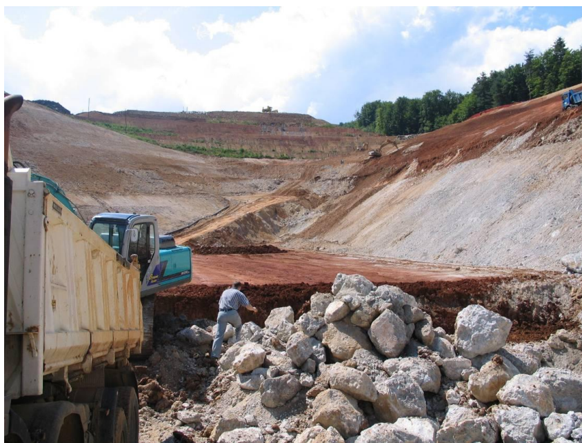
Slika 2.11: Gradnja mineralnega tesnilnega sloja v dnu novega dela odlagališča
