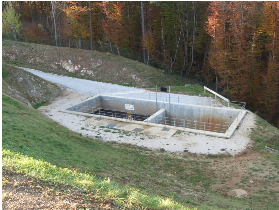
Slika 2.13: Bazen za izcedno in meteorno vodo
