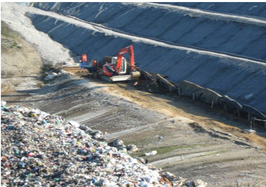
Slika 5.4: Zamenjava neprimerne materiala
