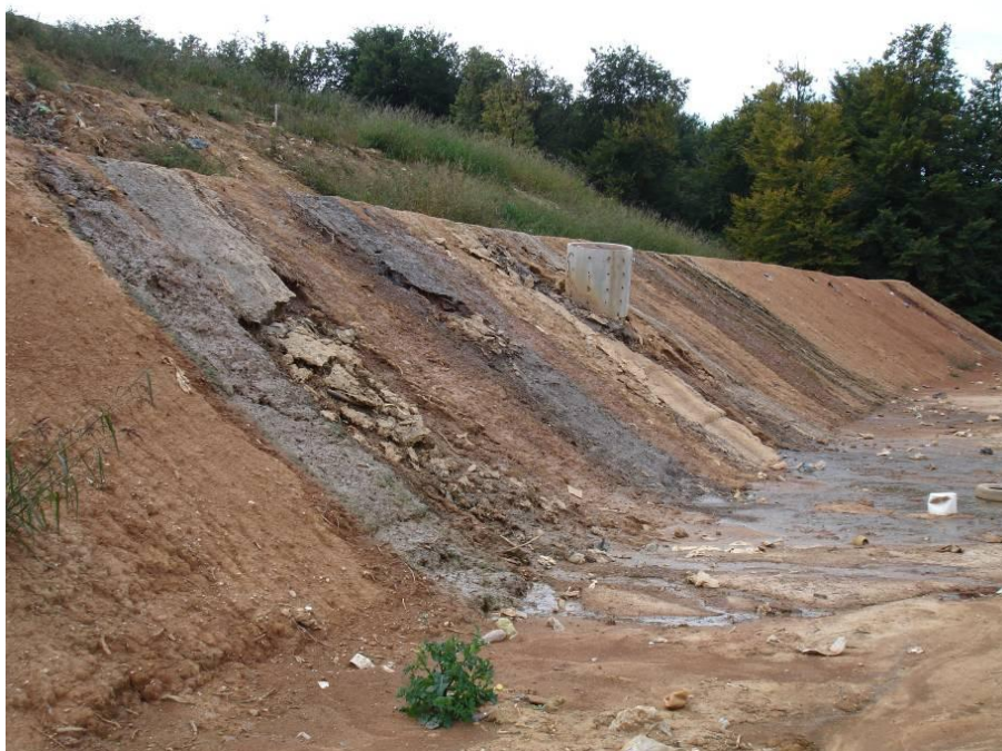
Slika 2.5: Pronicanje in preboji izcedne vode na vzhodnem boku deponije
