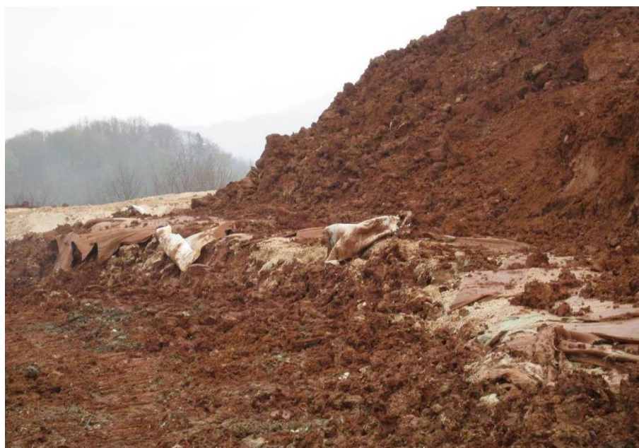
Slika 5.2: Popolnoma nepravilno polaganje geosintetikov
