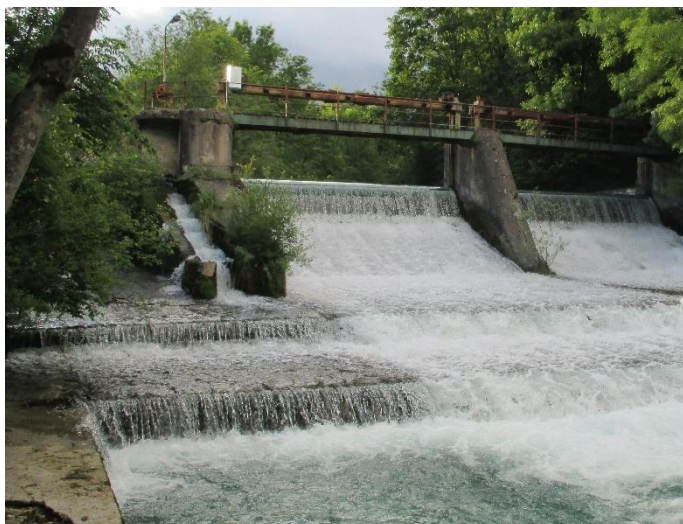
Slika 22: Ribja steza na Jezu pri smodnišnici ni funkcionalna (Blažič, 2016)
