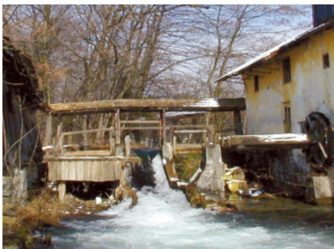
Slika 14: Jašovčev mlin ob Radomeljski Mlinščici (ICRO, 2015)
