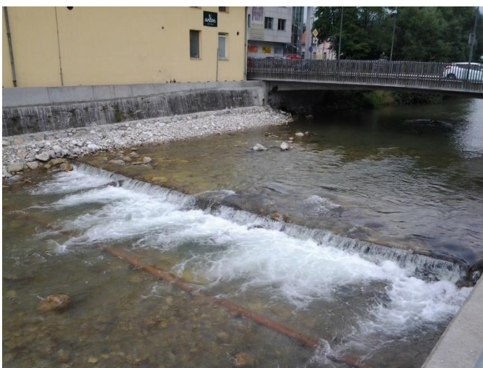
Slika 29: Talni prag za utrditev podslapja (Blažič, 2016)
