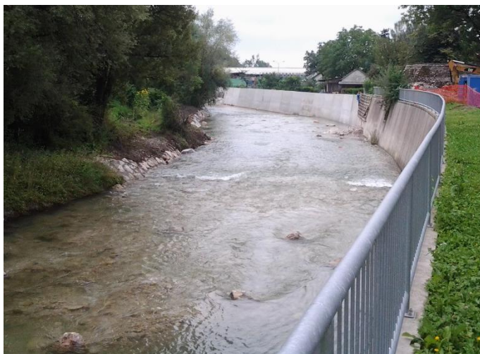
Slika 19: Obzidane zunanje in utrjene notranje brežine v Kamniku (Blažič, 2016)
