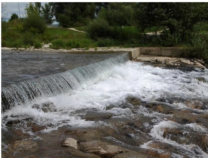
Slika 21: Čeprav je prag nizek, zaradi betoniranega podslapja za ribe ni prehoden (Blažič, 2016)
