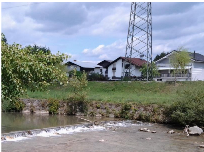
Slika 12: Prag, pozidana brežina in visokovodni nasip na urbanem območju (Blažič, 2016)
