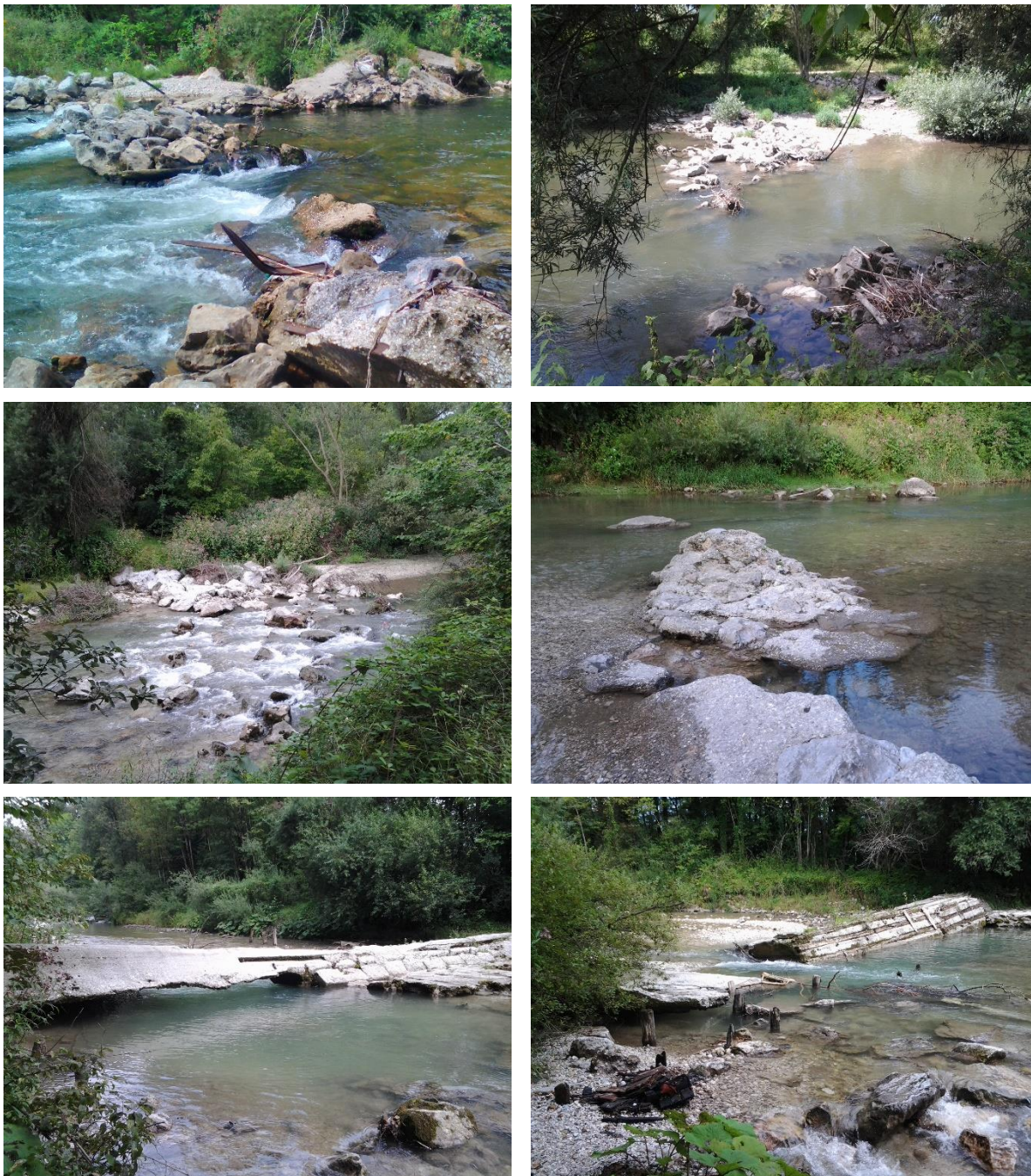
Slika 27: Primeri porušeni prečnih vodnih zgradb na Kamniški Bistrici (Blažič, 2016)
