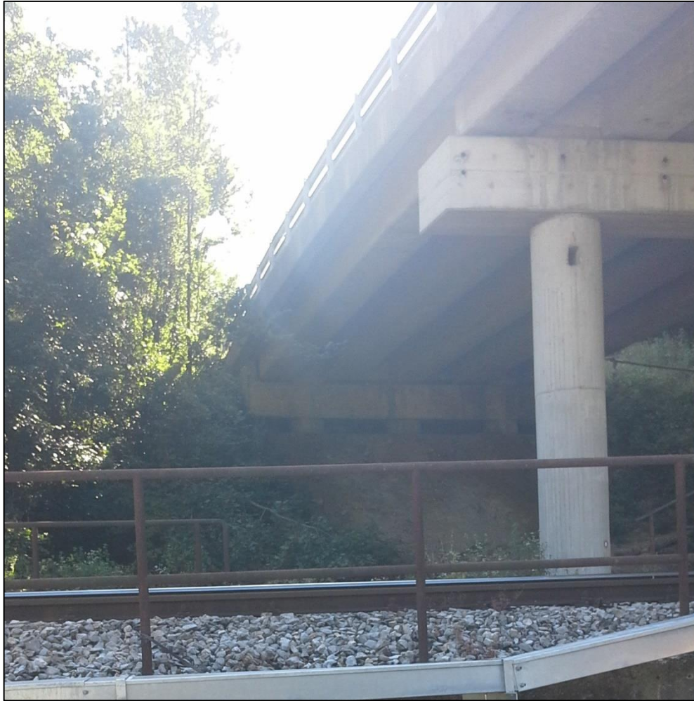
Slika 15: Del trase povezovalnega cevovoda Šmartno ob Paki (obešanje na mostno konstrukcijo)
