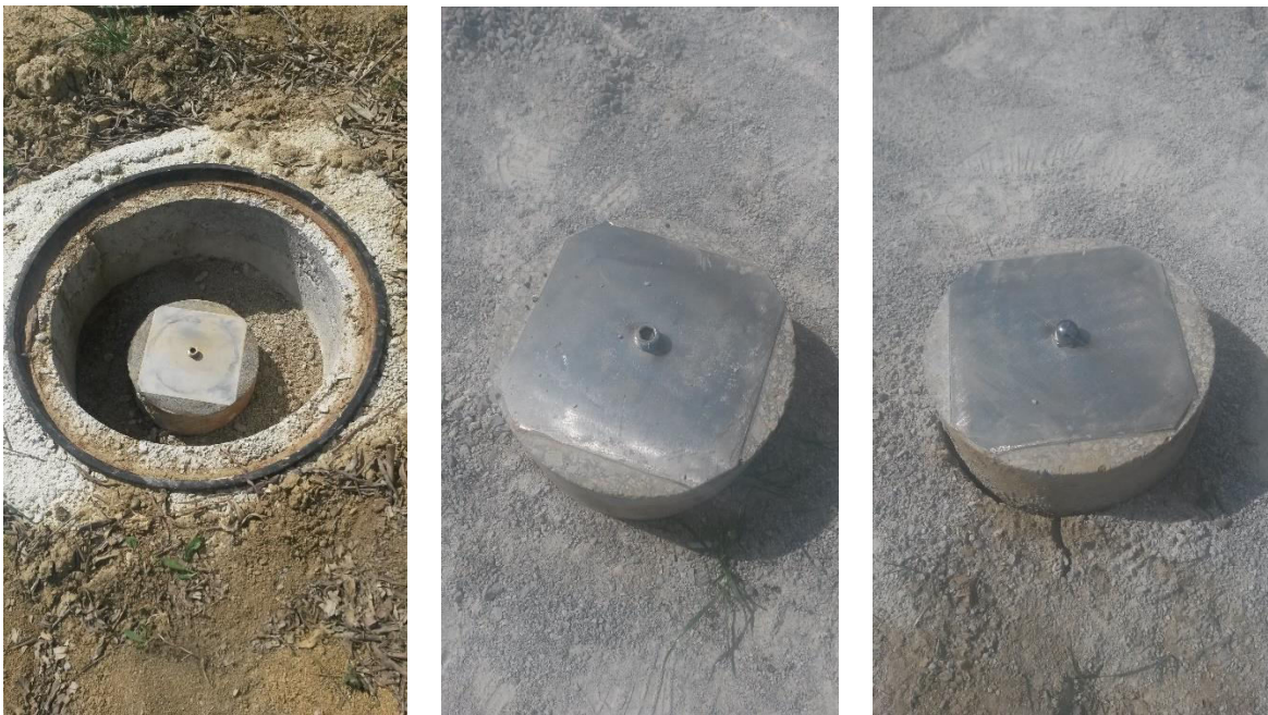
Slika 7: Kovinski vijak z navojem na zavarovalni točki KOG1 (levo) in reperju KOG4 (sredina) ter polkrožni čep na reperju KGR2 (desno)
