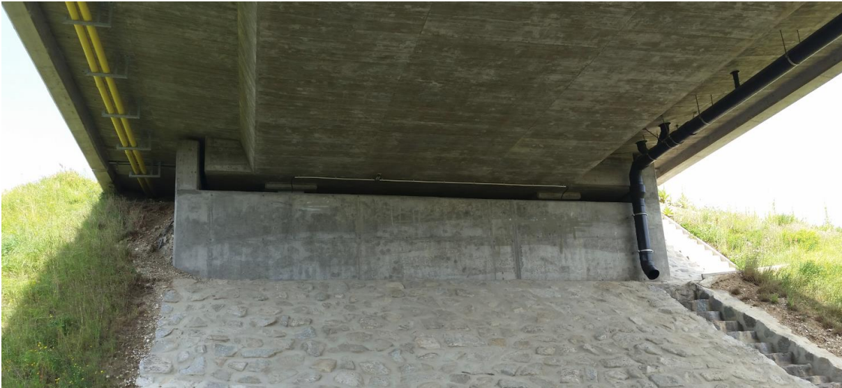
Slika 21: Pogled na zgrajeno prekladno konstrukcijo
