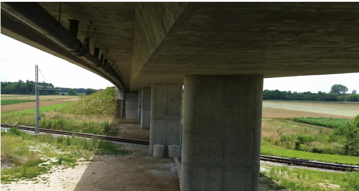
Slika 22: Pogled na spodnji del nadvoza
