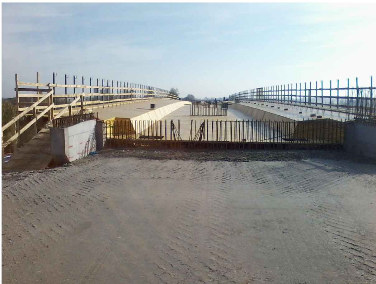
Slika 20: Stanje opaža pred polaganjem armature
