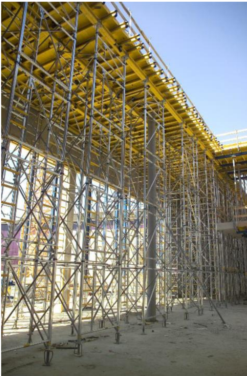
Slika 18: Doka opažni sistem (vir Doka)
