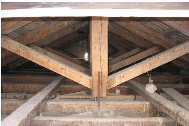
Slika 7: Primer strešne konstrukcije
