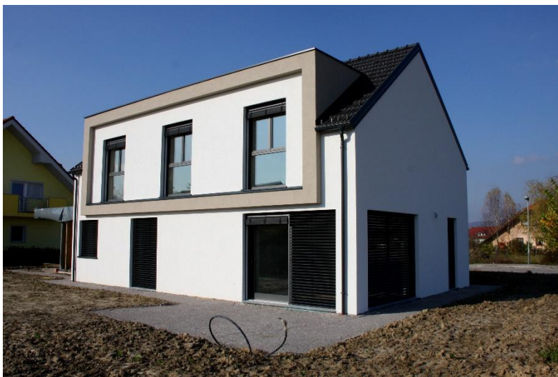
Slika 24: Skoraj nič energijska zidana stavba v Brežicah Vir: Arhiv podjetja As Invest d.o.o
