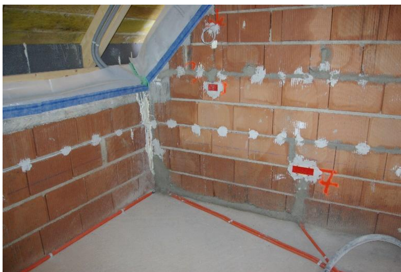
Slika 10: Vgradnja parne zapore za suhomontažni strop pred izdelavo ometov
