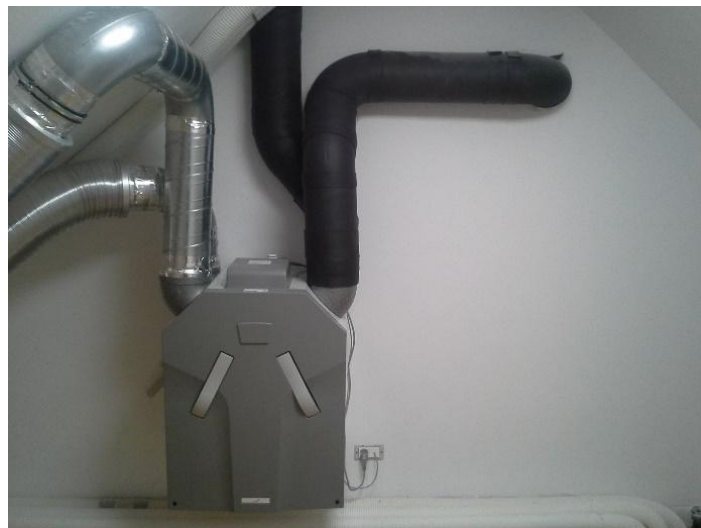
Slika 14: Prezračevalna naprava z izolirano cevjo za dovod in odvod zraka Vir: Arhiv podjetja As Invest d.o.o
