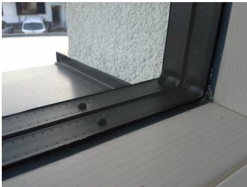
Slika 16: TGI distančnik iz umetne snovi Vir: Arhiv podjetja As Invest d.o.o
