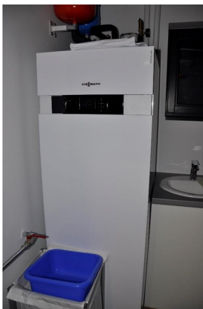
Slika 2: Primer kompaktno toplotne črpalke (notranja enota)
