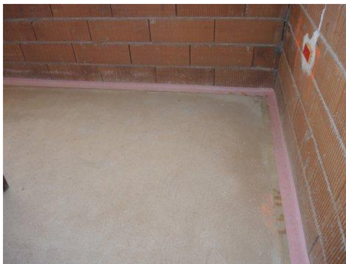
Slika 6: Vgradnja zrakotesnega traku na stiku med AB temeljno ploščo in zunanjim opečnim zidom
