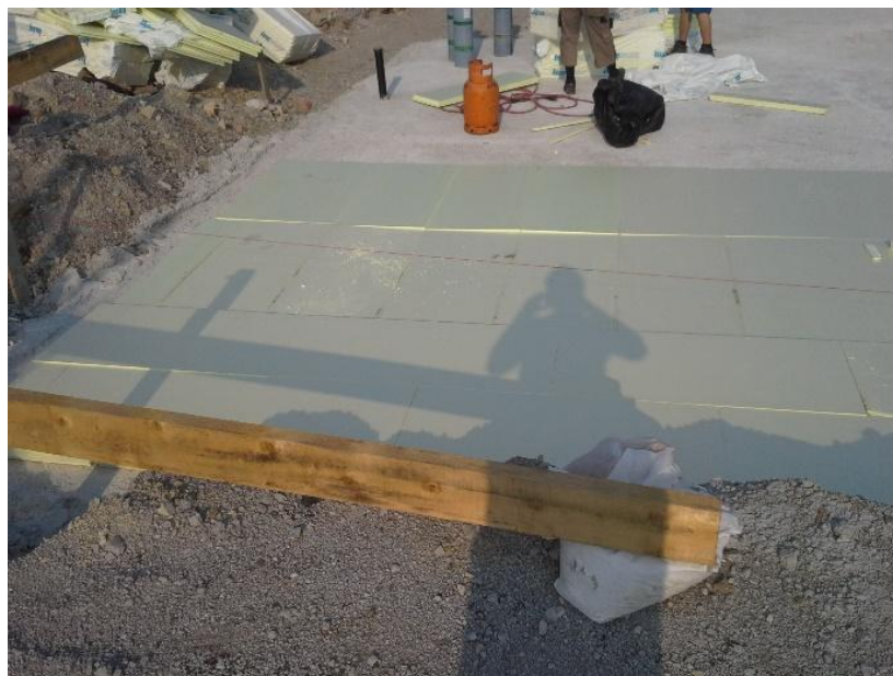
Slika 18: Polaganje 1 sloja toplotne izolacije v deb. 5 cm (vgradnja pod hidroizolacijo) Vir: Arhiv podjetja As Invest d.o.o
