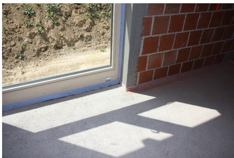
Slika 8: Toplotna izolacija notranjih špalet z XPS izolacijo, ki je armirana s fasadnim lepilom, ter montaža okna po Ral smernicah (notranji trak paronepropusten in zrakotesen) Vir: Arhiv podjetja As Invest d.o.o
