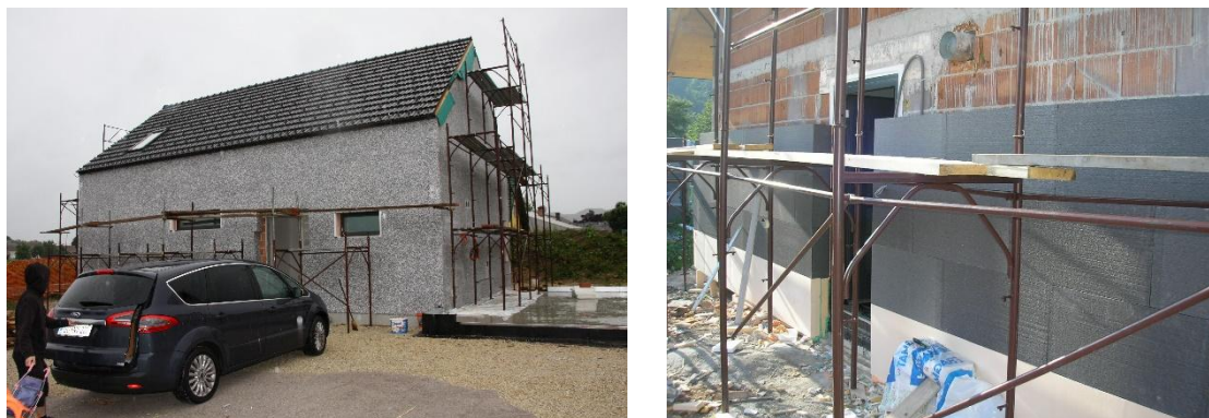
Slika 22: Toplotna izolacija na zunanjem zidu (dalmatiner-leva slika, neopor- desna slika) Vir: Arhiv podjetja As Invest d.o.o
