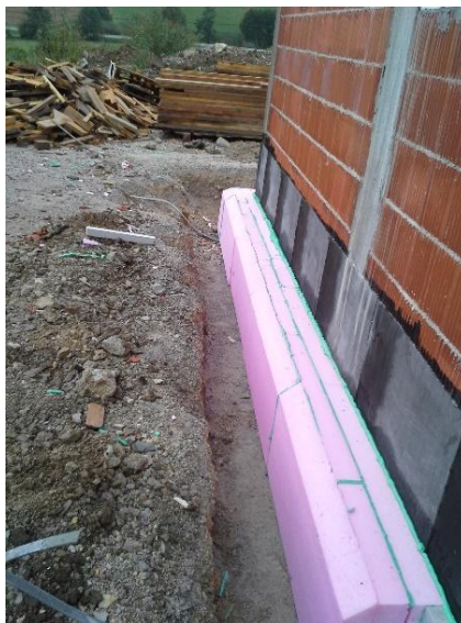
Slika 21: Vgradnja ekstrudiranega polistirena (XPS) na zunanji zid v terenu Vir: Arhiv podjetja As Invest d.o.o
