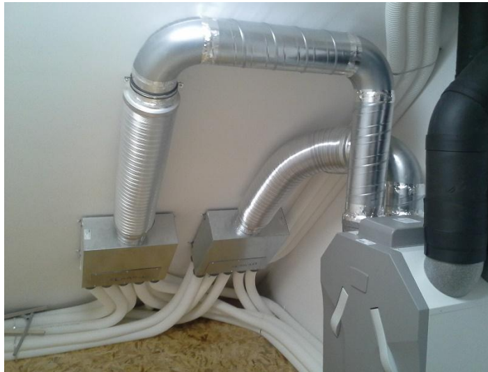
Slika 15: Razdelilna komora z vgrajenim dušilcem zvoka Vir: Arhiv podjetja As Invest d.o.o
