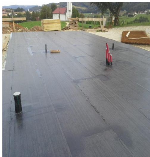
Slika 27: Razvod temeljne kanalizacije v tamponski blazini pod temeljno blazino in priklop hidroizolacije na preboje Vir: Arhiv podjetja As Invest d.o.o
