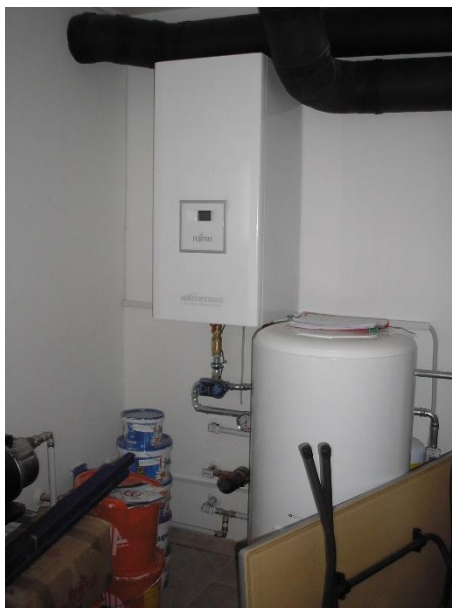
Slika 3: Ločena ali split toplotna črpalka (notranja enota) Vir: Arhiv podjetja As Invest d.o.o.
