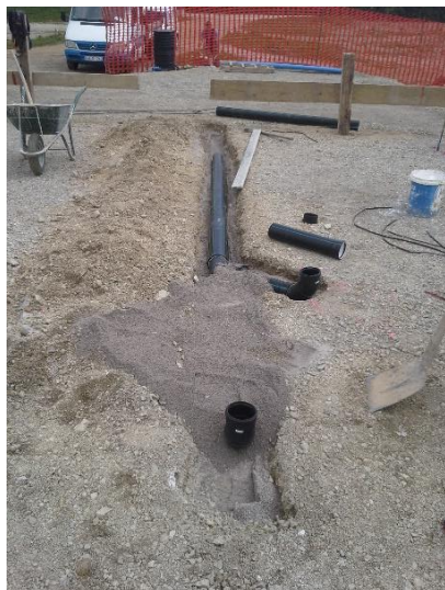
Slika 27: Razvod temeljne kanalizacije v tamponski blazini pod temeljno blazino in priklop hidroizolacije na preboje Vir: Arhiv podjetja As Invest d.o.o
