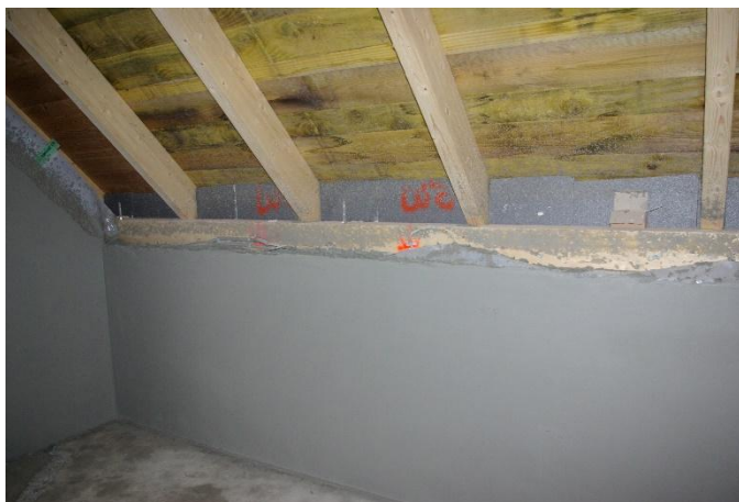
Slika 11: Izdelava gladkih ometov, ki so zaključeni čisto do tal, ter priključeni na parno zaporo za suhomontažni strop Vir: Arhiv podjetja As Invest d.o.o
