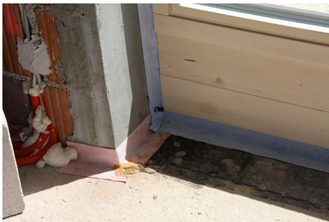
Slika 7: Tesnjenje stika med cevjo, ki poteka v estrihu in električnih kablom z zrakotesno peno Vir: Arhiv podjetja As Invest d.o.o
