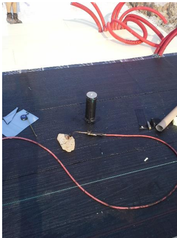
Slika 19: Izdelava horizontalne hidroizolacije, ter priključek hidroizolacije na preboje Vir: Arhiv podjetja As Invest d.o.o
