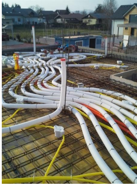
Slika 13: Razvod fleksibilnih cevi prezračevanja v AB plošči Vir: Arhiv podjetja As Invest d.o.o
