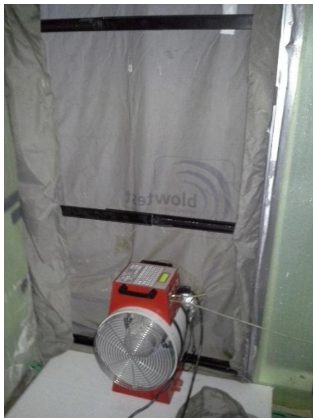
Slika 12: Naprava pri izvajanju Blower Door testa Vir: Arhiv podjetja As Invest d.o.o
