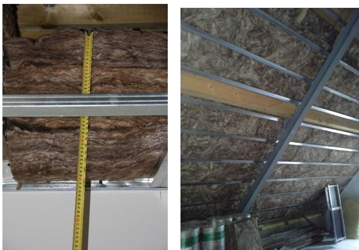
Slika 23: Debelina toplotne izolacije (steklena volna) vgrajene v skoraj nič energijsko stavbo Vir: Arhiv podjetja As Invest d.o.o
