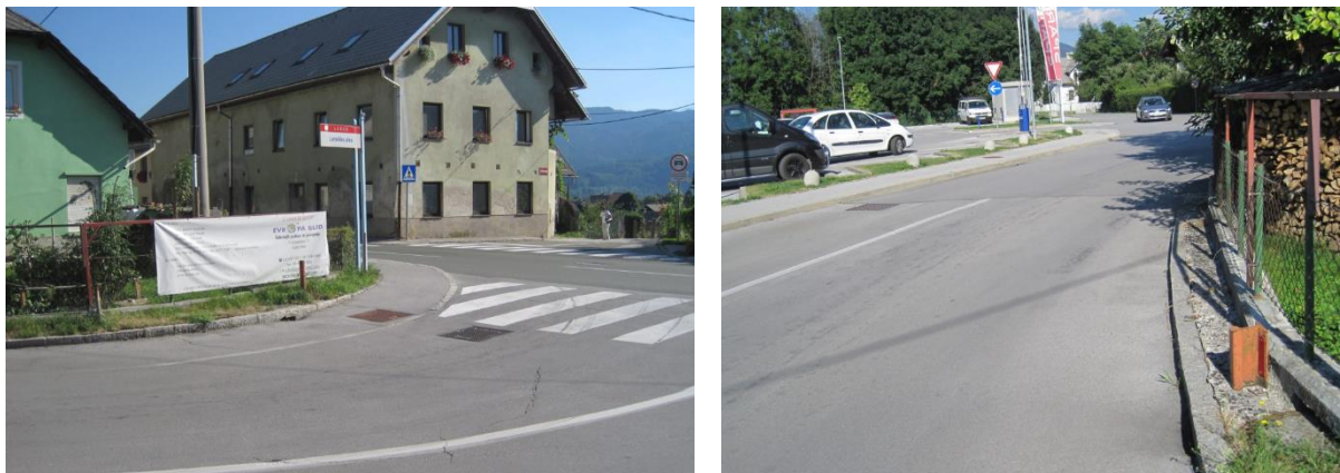
Slika 74: Nepravilen zaključek pločnika (oznaka številka 37), ki prehaja v pas za pešce (levo) in pogled s perspektive pešca, ki sledi poti pločnika in se znajde na vozišču (desno)
