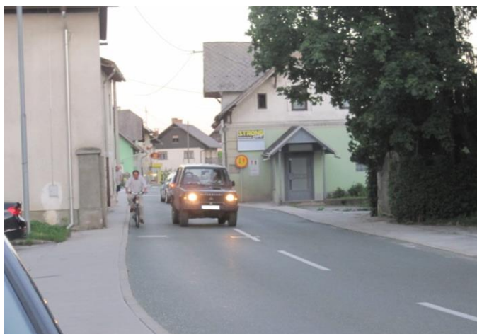
Slika 76: Zožitev pločnika zaradi stavbe (oznaka številka 37)
