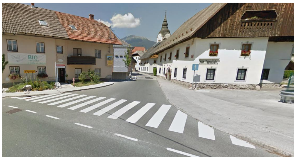
Slika 67: Vodenje pešcev po pločniku pripelje pešca do nepravilnega prečkanja v ulici (Google Street View, 2016)
