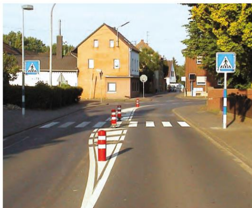
Slika 8: Prehod za pešce z izvedenim ukrepom umirjanja prometa (Schulwegsicherung. Planerheft, 2010: str. 15)
