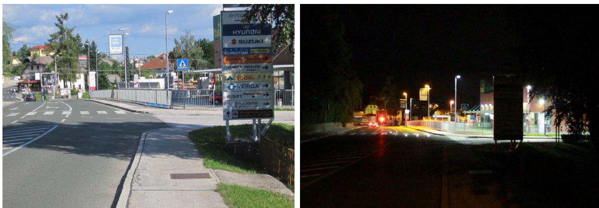
Slika 68: Ovirana preglednost prehoda za pešce (oznaka številka 23) zaradi reklamnih napisov podnevi (levo) in vidljivost prehoda za pešce ponoči (desno)
