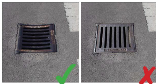
Slika 35: Pravilno (levo) in nepravilno (desno) orientiran odtočni jašek (Navodila za projektiranje kolesarskih površin, 2012: str. 51)
