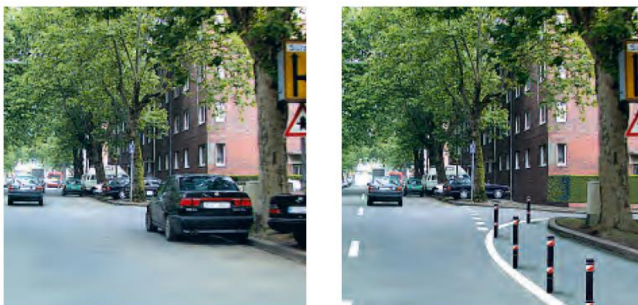
Slika 7: Preglednost pred (levo) in po sprejetju ustreznih omejitev parkiranja (desno) (Schulwegsicherung. Planerheft, 2010: str. 9)
