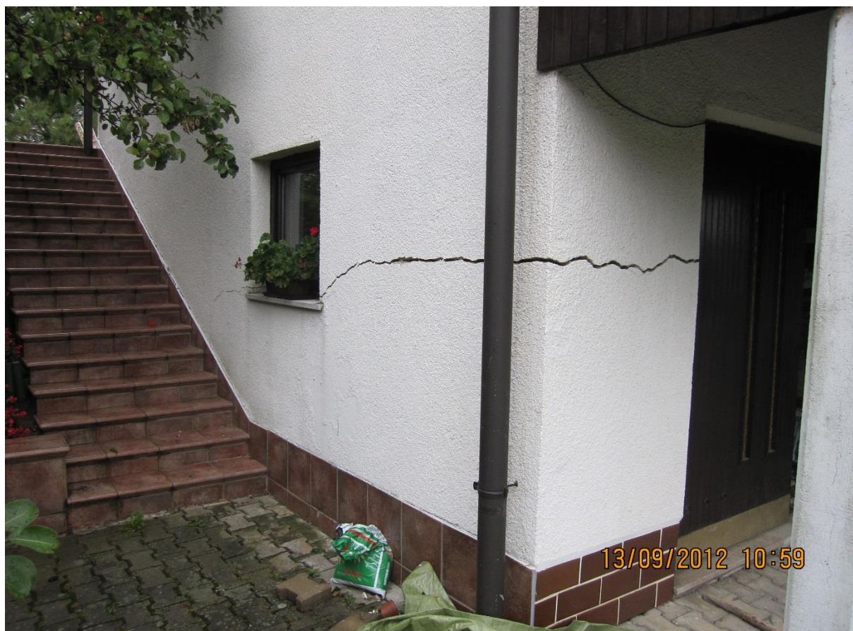
Slika 18: Vidne razpoke na hiši so posledica klimatskih sprememb (Petkovšek, 2016)
