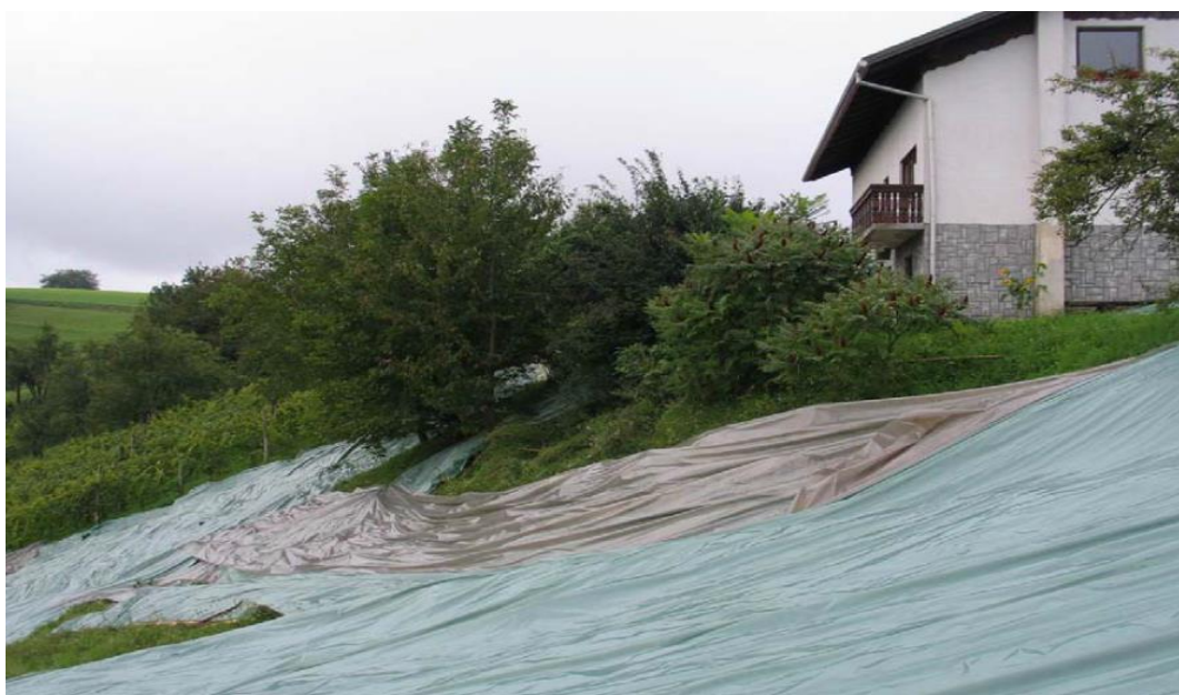
Slika 9: Neustrezno odvajanje meteornih vod (Petkovšek, 2016)
