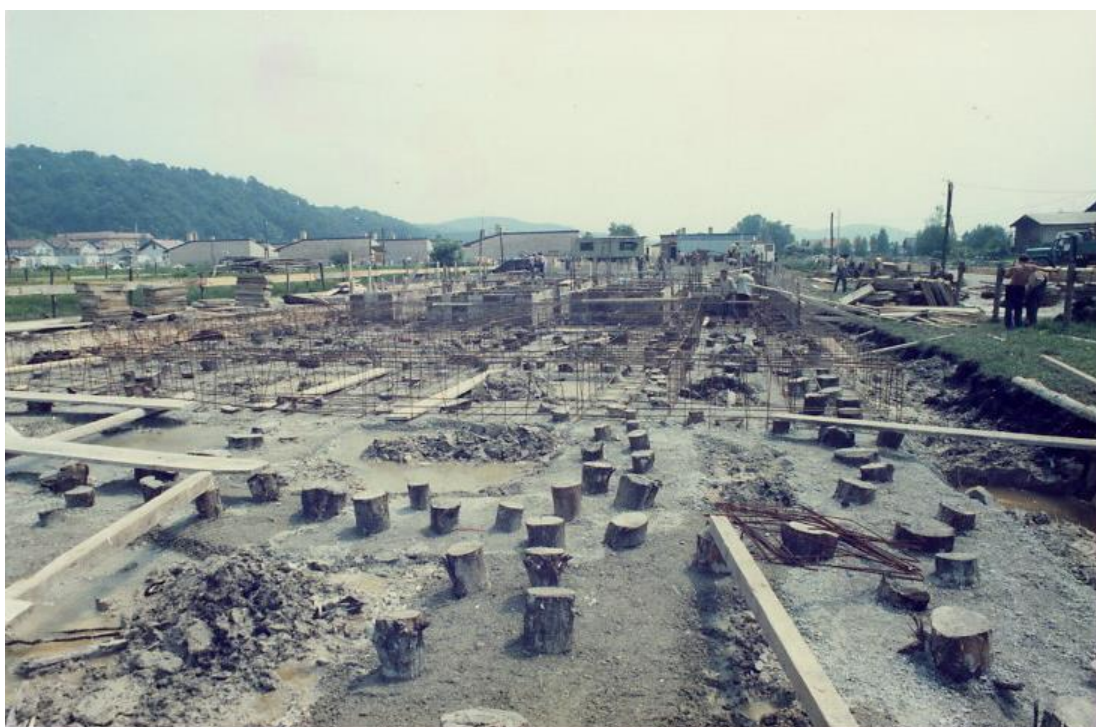
Slika 21: Izvedba globokega temeljenja z lesenimi piloti (Petkovšek, 2016)
