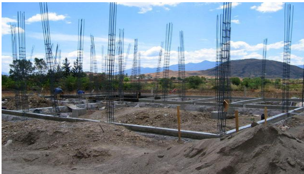
Slika 24: Izvedba pasovnih temeljev (Vrste temeljev, 2016)
