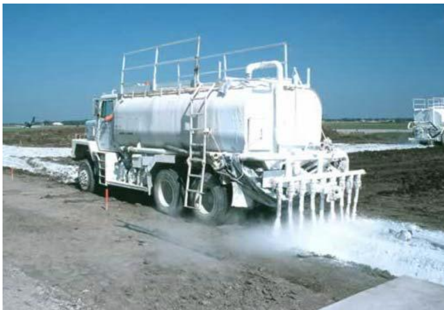
Slika 5: Izboljšanje temeljnih tal z apnom (LIME, 2004)
