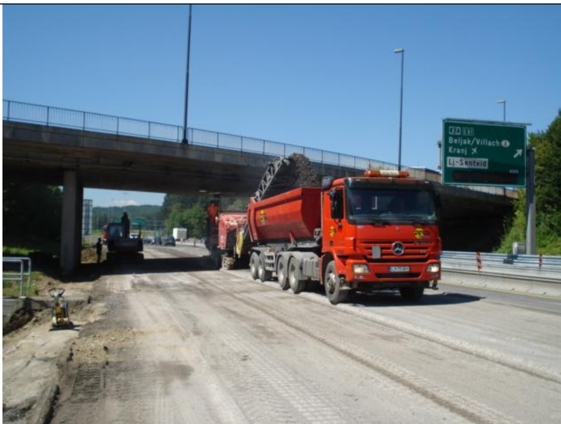
Slika 6 : Rezkanje obstoječih asfaltnih plasti (STRABAG, 2012)
