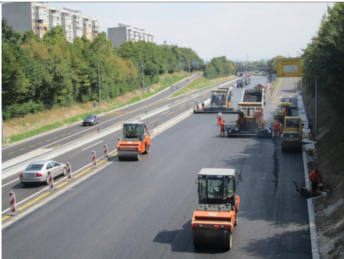
Slika 9 : Vgradnja obrabnega asfalta na trasi hitre ceste s tremi finišerji (STRABAG, 2012)
