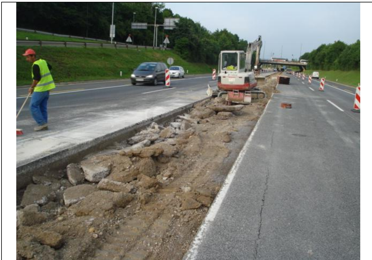
Slika 5 : Rušenje obstoječe cementne stabilizacije z bagrom (STRABAG, 2012)
