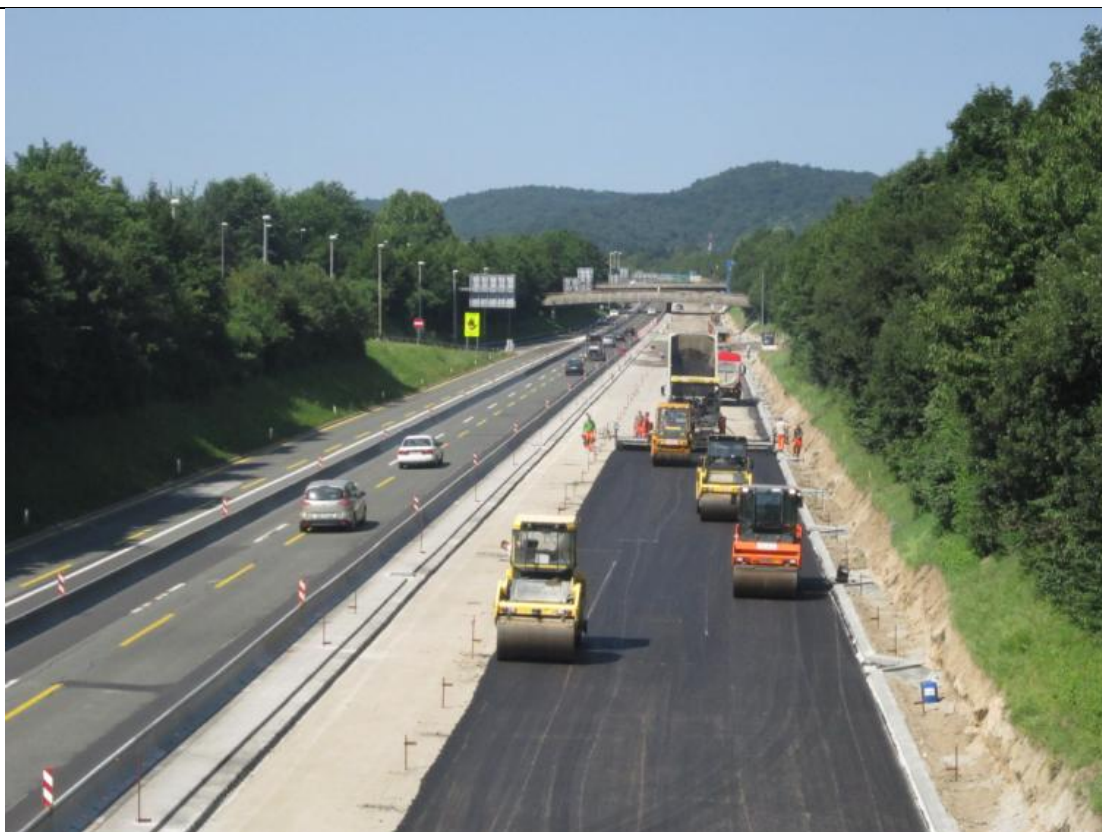
Slika 8 : Vgradnja nosilne plasti asfalta na trasi hitre ceste (STRABAG, 2012)
