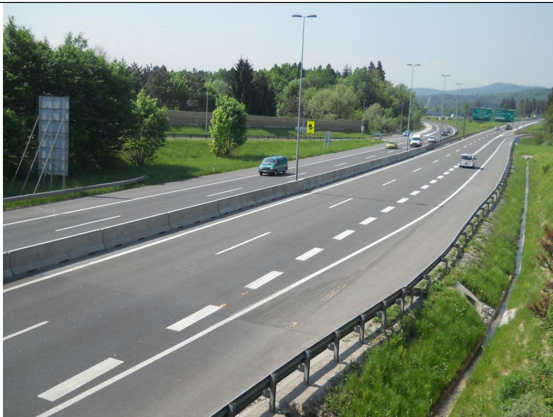
Slika 11 : Pogled na izvedena dela rekonstrukcije dela odseka HC (STRABAG, 2013)
