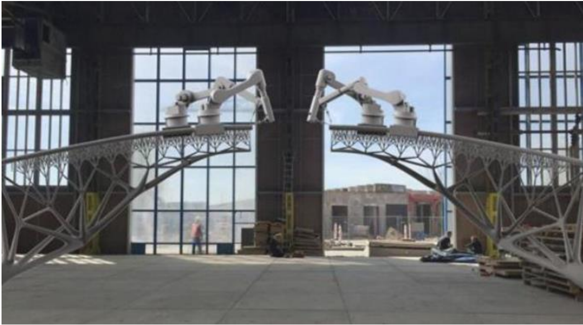
Slika 49: Robota ločeno tiskata vsak svojo polovico [19].
