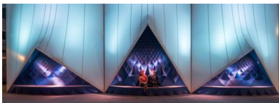
Slika 41: Spodnji del fasade, natisnjen iz bio plastike z metodo FDM [27]
