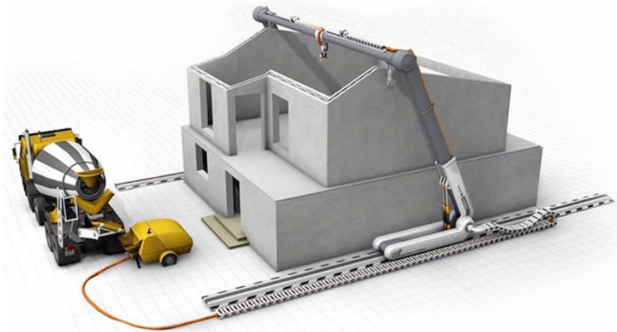
Slika 26: Prikaz 3D-tiska z metodo Contour Crafting [28]
