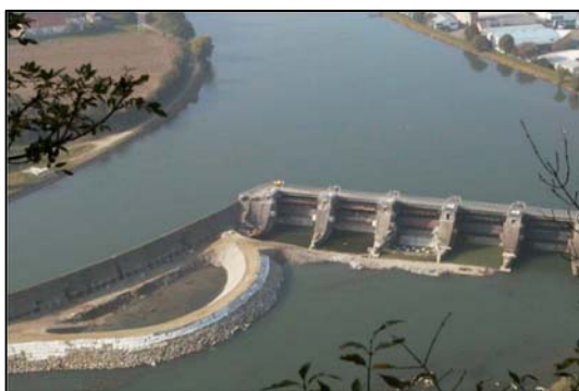
Slika 2: Jez Melje pred izgradnjo prelivne stene ( http://maribor24.si/lokalno )
