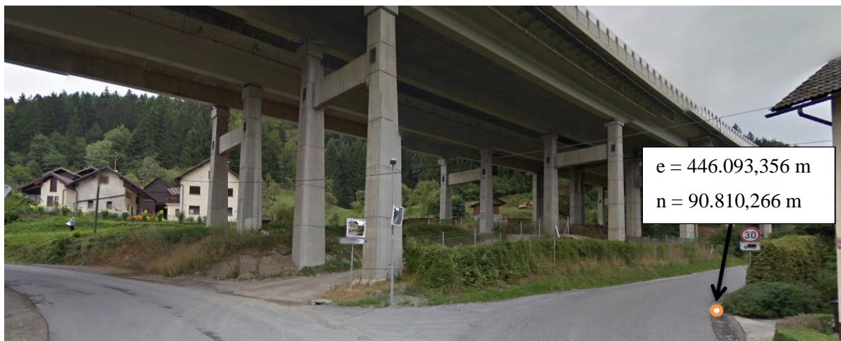
Slika 6: Viadukt Verd, pogled s strani (vir: Googlovi zemljevidi, 2016)
