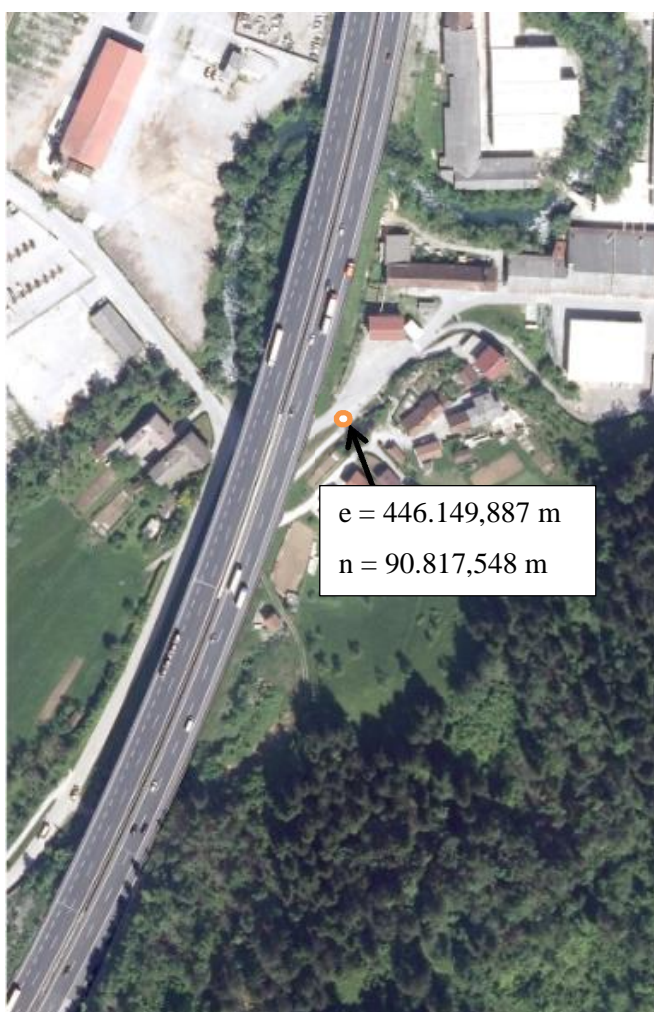
Slika 5: Viadukt Verd (vir: GURS, 2015)
