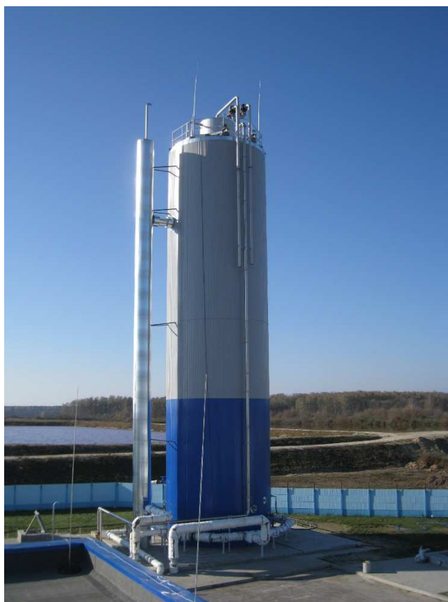
Slika 21: Anaerobni R2S reaktor ČN Skidel (lasten vir)
