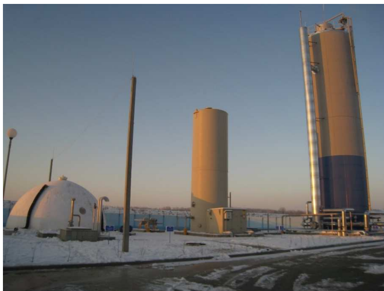
Slika 26: Plinohram, desulfurizator, R2S reaktor (od leve proti desni) (lasten vir)
