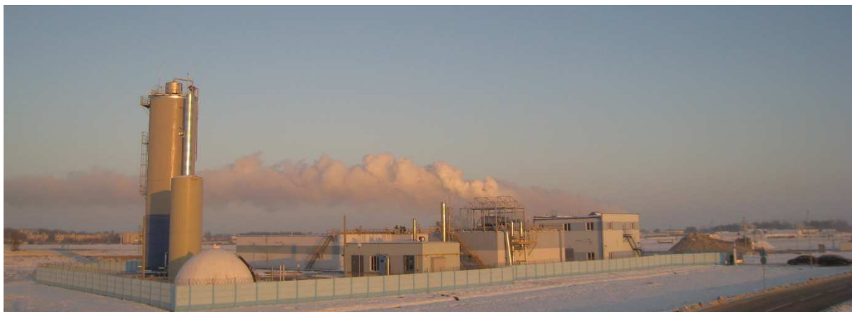
Slika 19: Industrijska čistilna naprava sladkorne tovarne Skidel (lasten vir)
