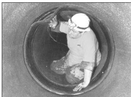
Slika 29: Levo čiščenje spoja in desno lubriciran spoj in nameščanje tesnila (J. Fletcher Creamer & Son, Inc., 2016)
