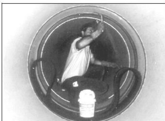
Slika 29: Levo čiščenje spoja in desno lubriciran spoj in nameščanje tesnila (J. Fletcher Creamer & Son, Inc., 2016)
