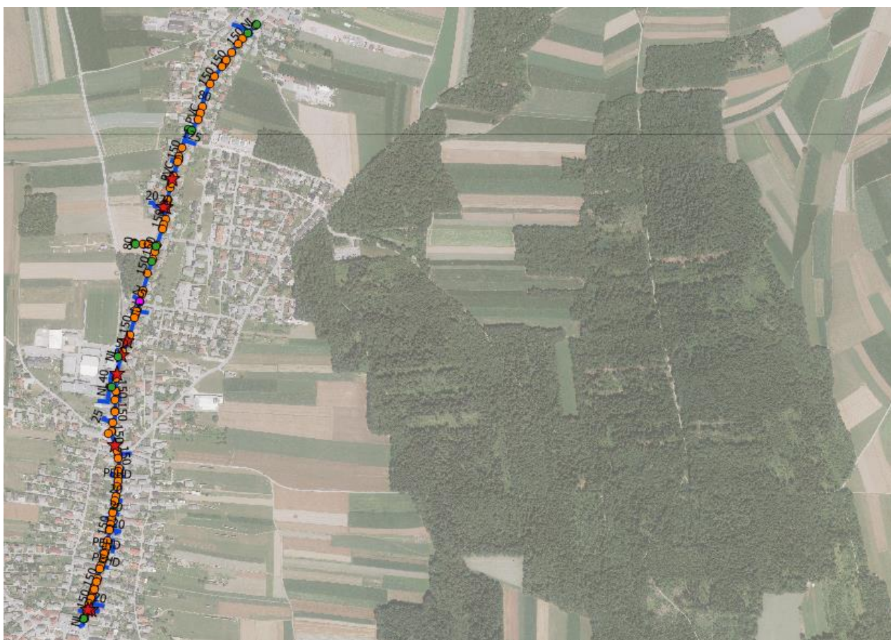
Slika 66: Vodovodni odsek pod Pipanovo cesto v Šenčurju (glej Prilogo C.2)
