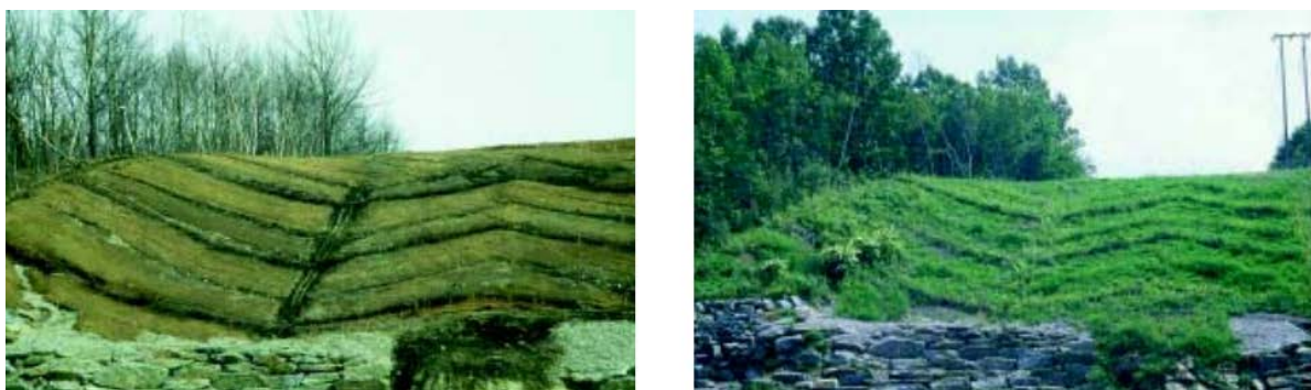
Slika 43: Žive fašine nameščene pod kotom (Lewis, 2000)
