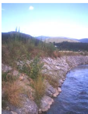
Slika 53: Obstoječi kamnomet med naseljema Šmartno in Slovenj Gradcem
