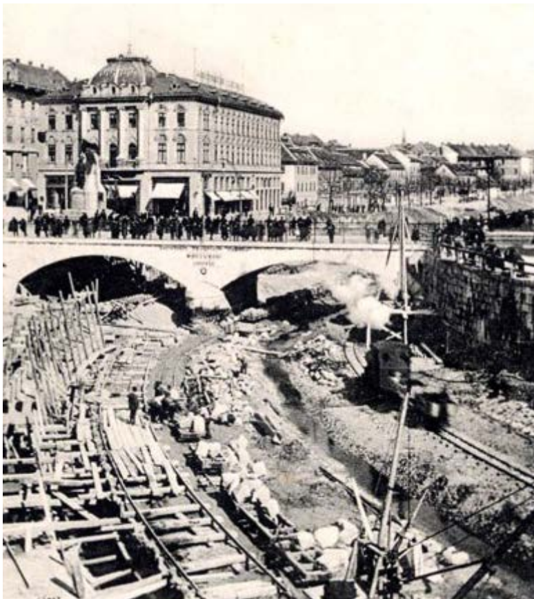
Slika 1: Regulacija Ljubljanice leta 1913. Naravno korito je bilo zabetonirano, bregovi utrjeni in reka je dobila povsem drugačen značaj (Gazvoda, 2005).
