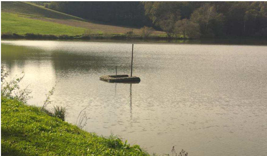
Slika 40: Talni izpust, Zadrževalnik Savci (foto: Hočurščak, 2014)
