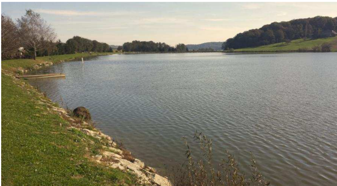
Slika 38: Kamnito zavarovanje brežine nasipa, Zadrževalnik Savci (foto: Hočurščak, 2014)
