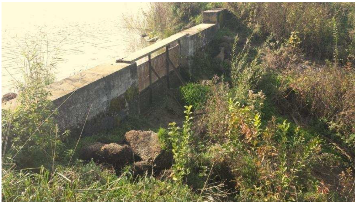
Slika 39: Drča in podslapje prelivnega objekta, Zadrževalnik Savci (foto: Hočurščak, 2014)
