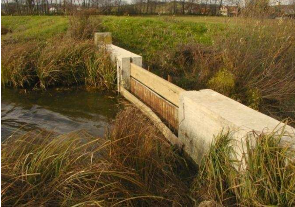
Slika 37: Nadvišanje preлива, Zadrževalnik Savci (foto: Hočurščak, 2004)
