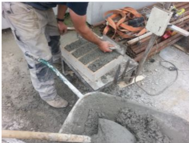
Slika 30: Betoniranje ležečih prizem
