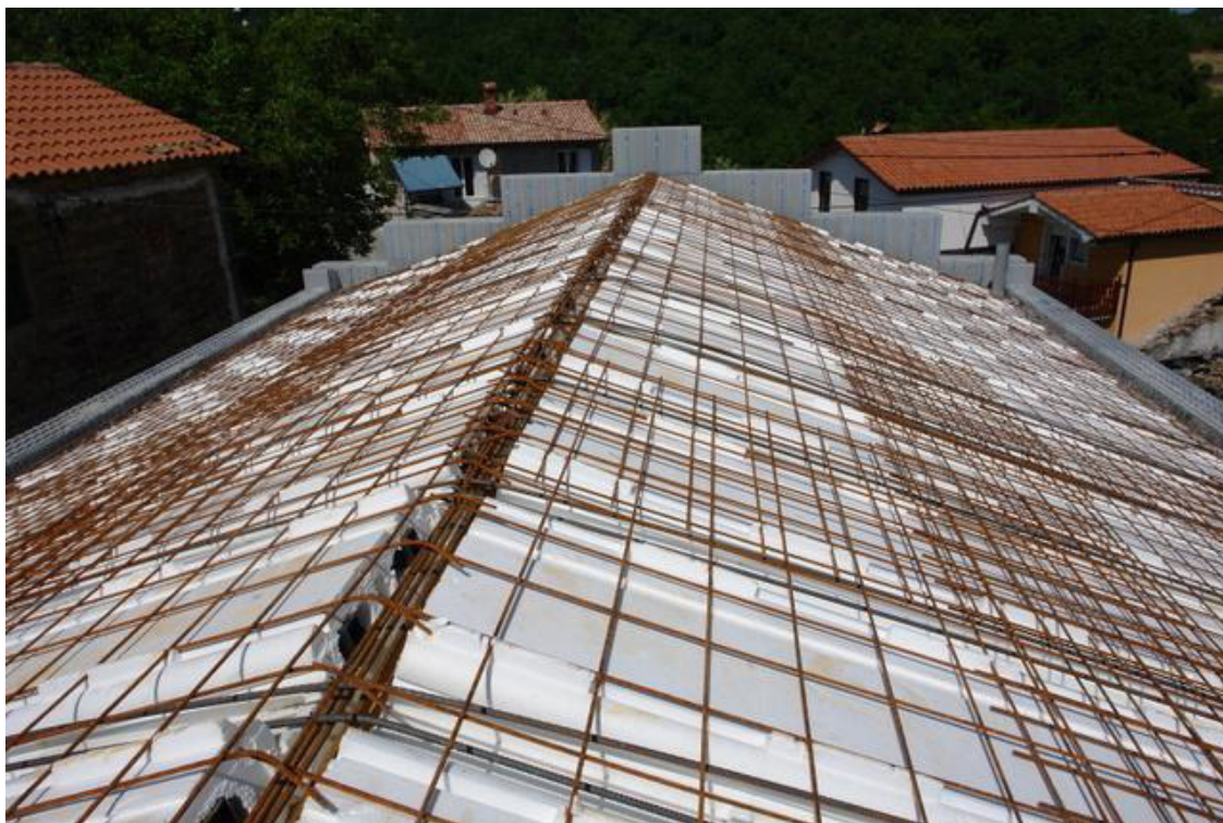
Slika 10: Armatura AB strehe [25]
