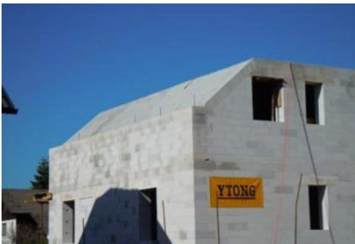
Slika 11: Primer strehe z YTONG stropom [26]
