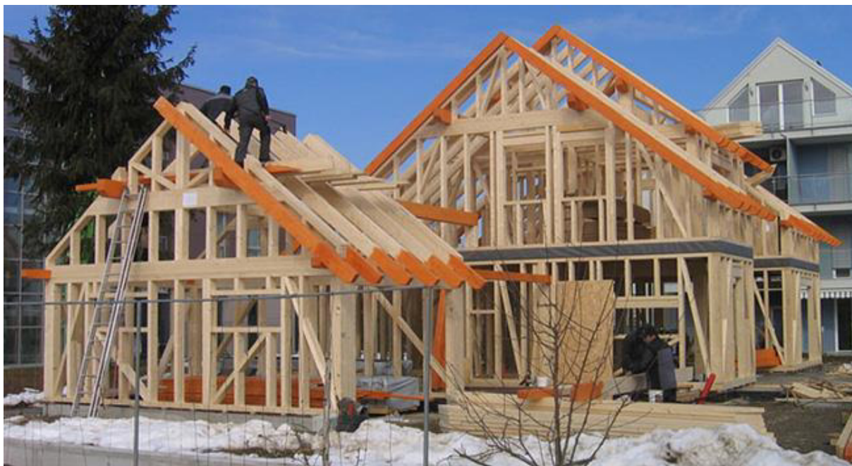
Slika 13: Endo skeletna konstrukcija (montažne hiše) [29]
