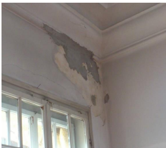
Slika 21: Kitanje s cementnim ometom v telovadnici v prvem nadstropju (321)
