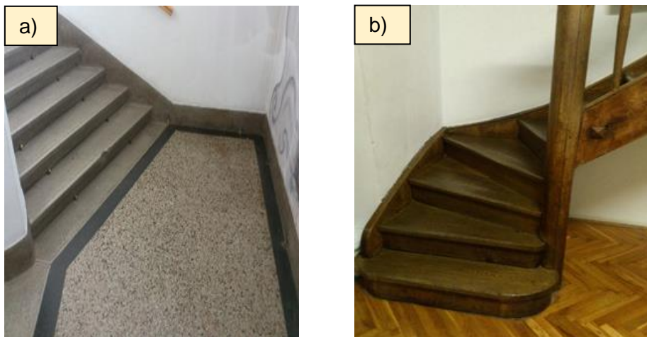
Slika 20: Betonsko stopnišče in teraco podest a) in lesen stopnice b)
