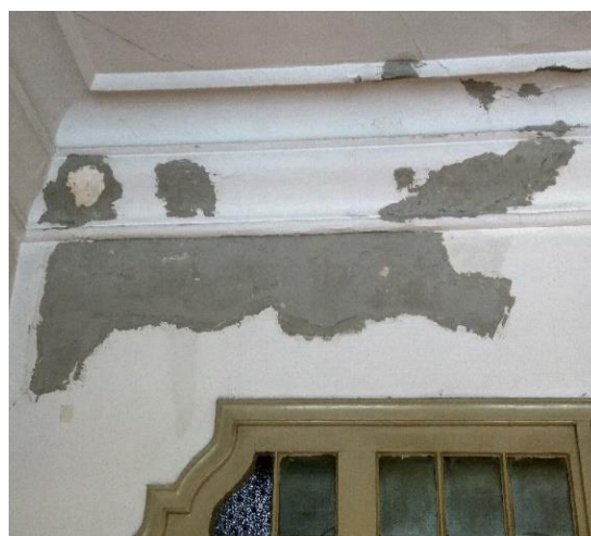
Slika 21: Kitanje s cementnim ometom v telovadnici v prvem nadstropju (321)
