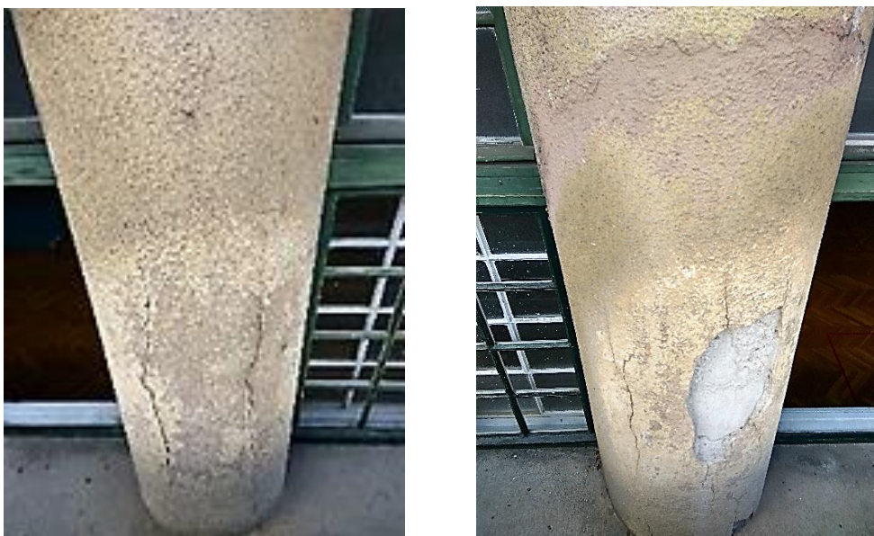
Slika 8: Razpoke na kletnih stebrih - vzhod
