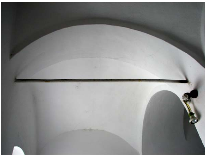
Slika 7: Sidranje zunanjega zidu na notranjo nosilno konstrukcijo na nivoju prvega nadstropja
