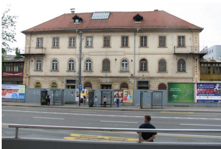
Slika 3: Severna fasada objekta
