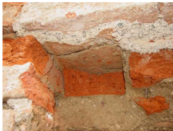
Slika 28: Bela – malta za refugiranje, rjava – originalna malta, pregledno mesto Z7
