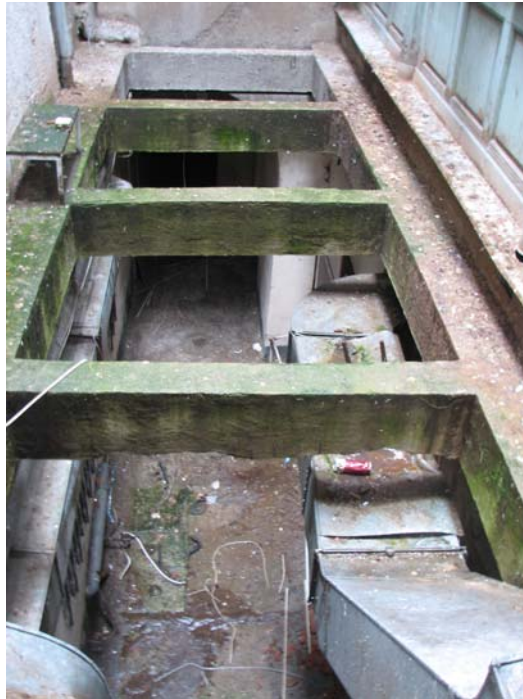
Slika 18. Armirano betonska razpiralna konstrukcija v sredinskem severnem delu objekta
