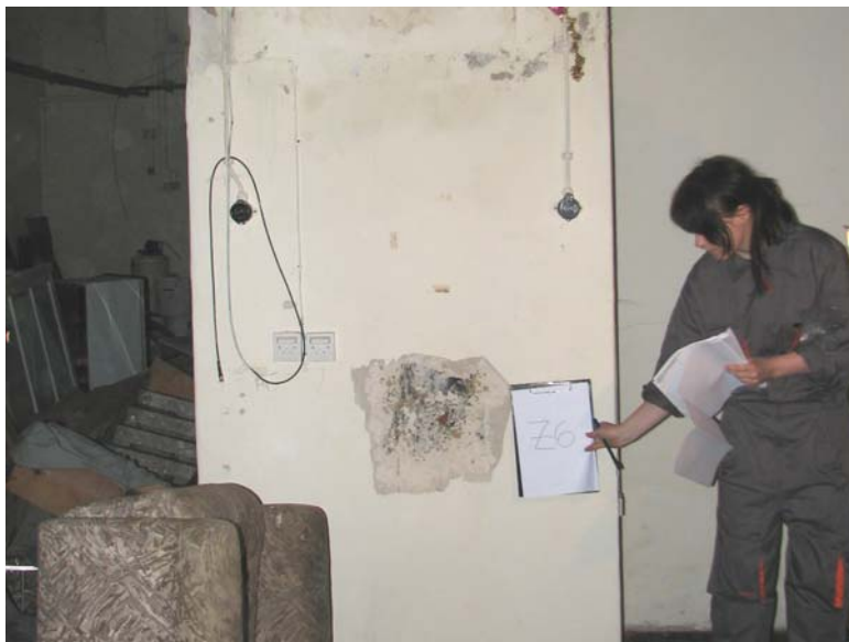
Slika 23: Odvzem opečnega zdroba, pregledno mesto Z6
