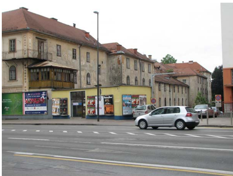
Slika 4: Zahodna fasada objekta
