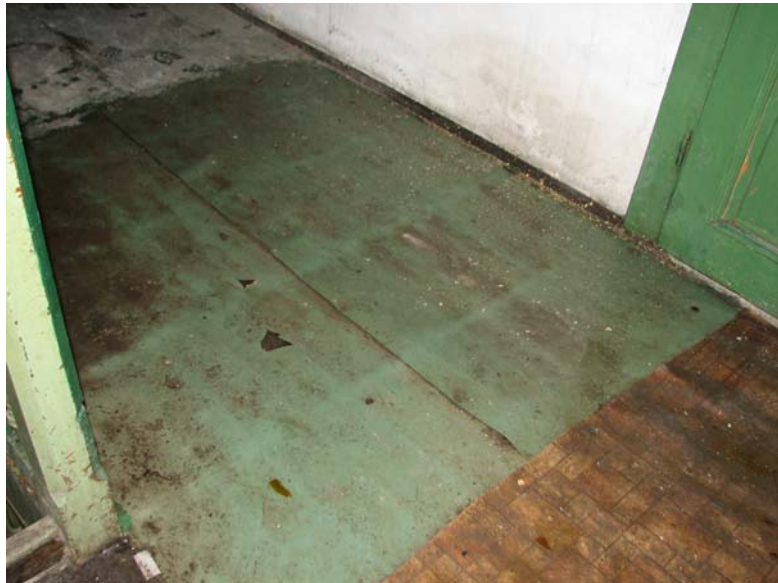
Slika 14: Zamakanje strehe v 3. nadstropju južnega dela objekta
