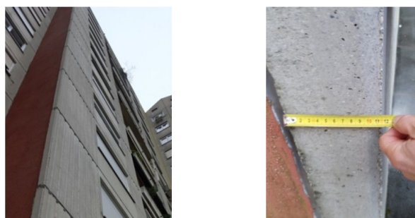
Slika 11 (levo): AB prefabrikati – vzhodna in zahodna fasada [38]
