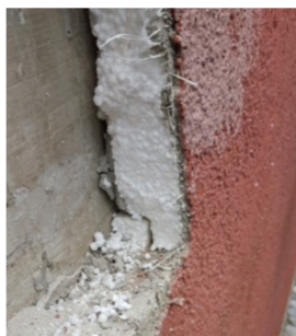
Slika 10: Sondiranje obstoječe kontaktne fasade – ZS 1, severna in južna fasada [37]
