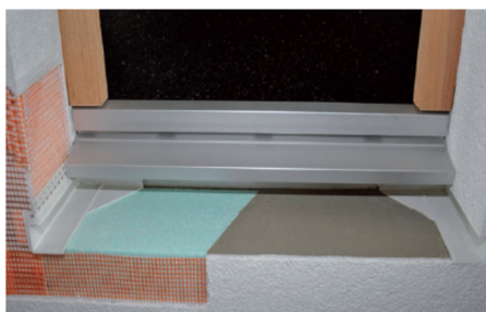
Slika 2: Vgradnja okenskih tesnilnih elementov [15]
