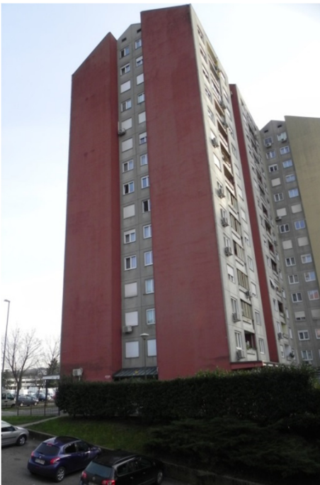
Slika 7 (levo): VSO Gradnikove brigade 33, severna fasada s kontaktnim fasadnim sistemom [34]
