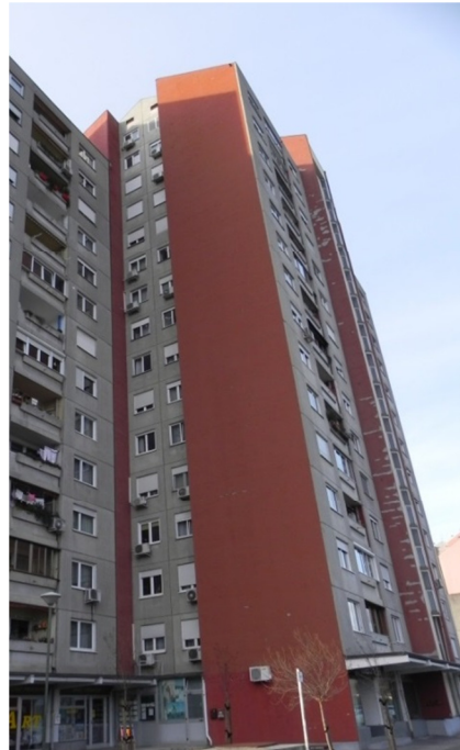
Slika 5 (levo): VSO Gradnikove brigade 33, vzodna fasada s stopniščnim jedrom in montažno fasado [32]
