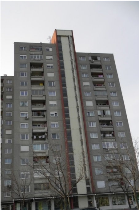
Slika 5 (levo): VSO Gradnikove brigade 33, vzodna fasada s stopniščnim jedrom in montažno fasado [32]
