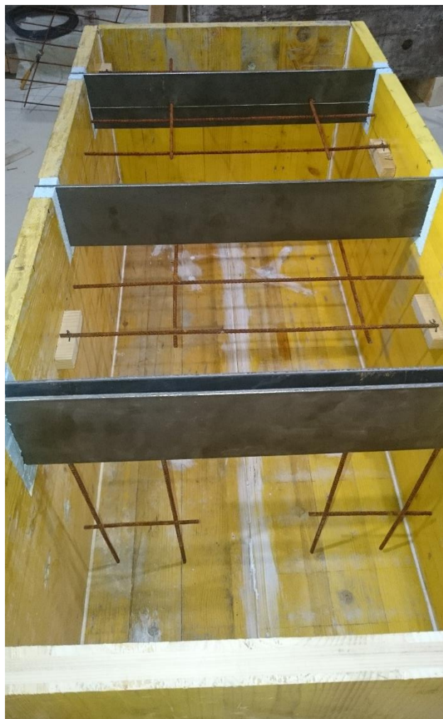
Slika 28: Pripravljen opaž za vzorec 2
