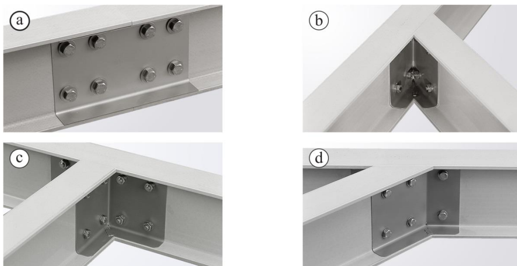
Slika 5.2: Prikaz različnih vrst mehanskih (vijačenih) spojev: a-spoj pod kotom 0^\circ , b-spoj pod kotom 35^\circ , c-spoj pod kotom 90^\circ , d-spoj pod kotom 135^\circ [9].
