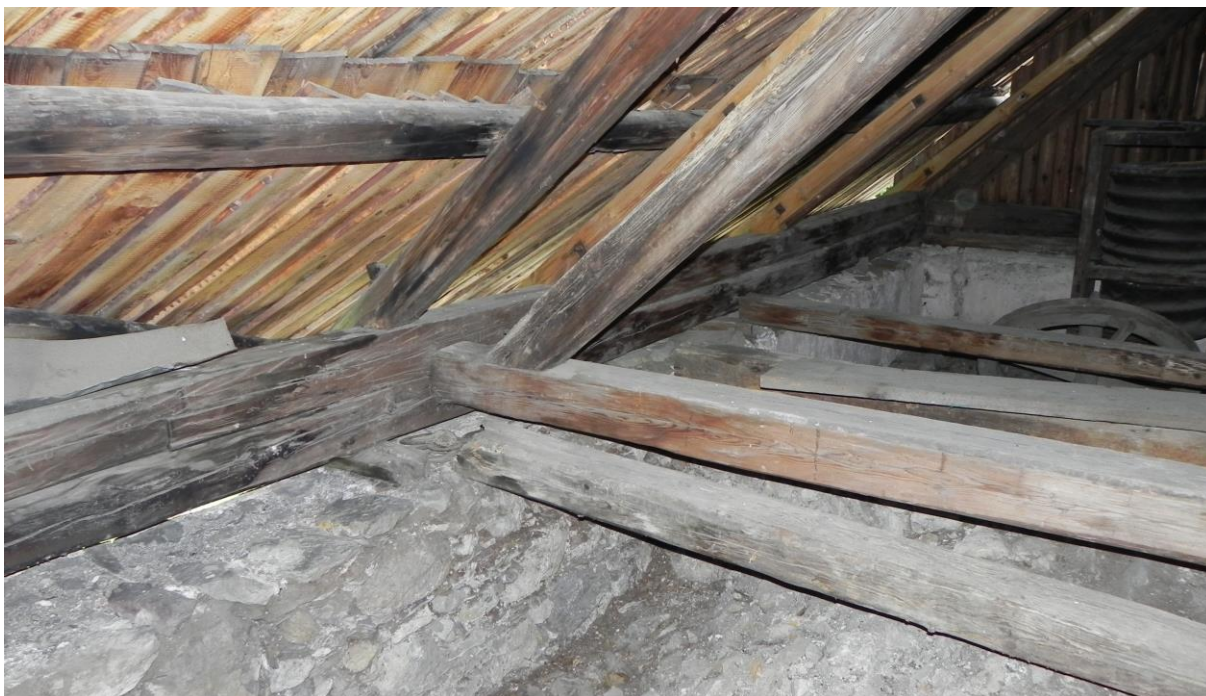
Slika 13: Povezava med okvirjem in kapnima legama, ki nalegata na zunanje zidovje, kritina iz dveh slojev macesnovih skodel s 30 cm prekrivanjem.
