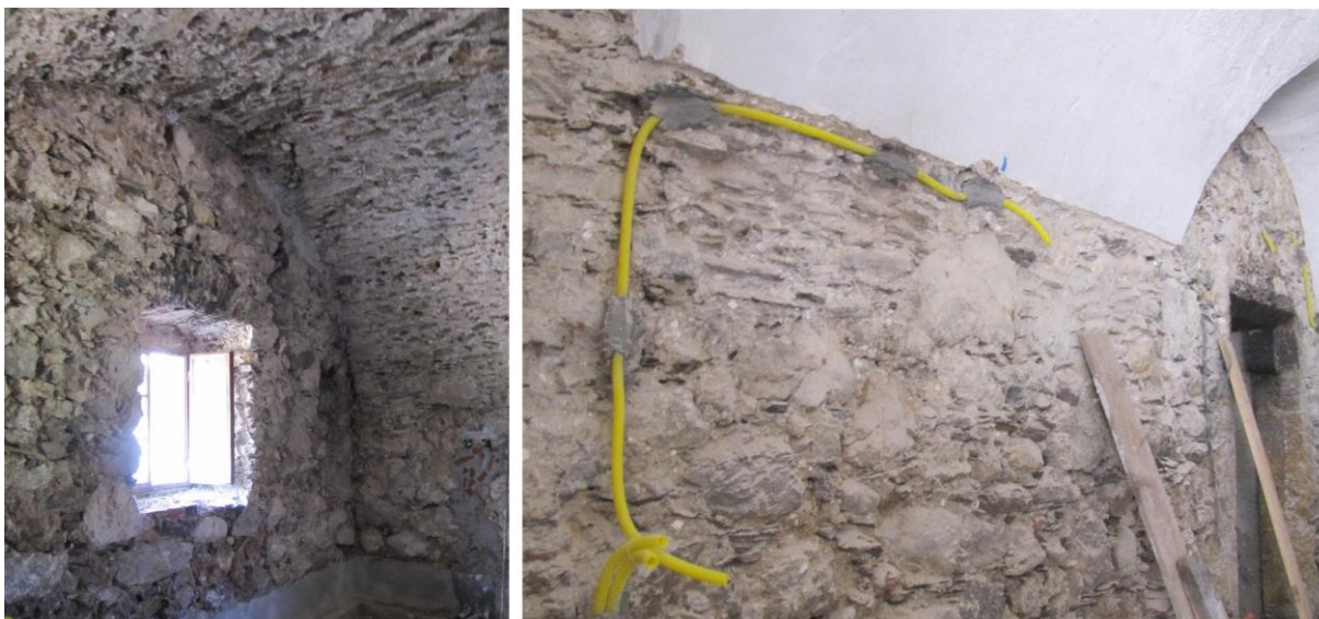
Slika 8: Kompaktno kamnito zidovje brez ometa v sobi na severni strani (levo) in v glavni veži (desno).
