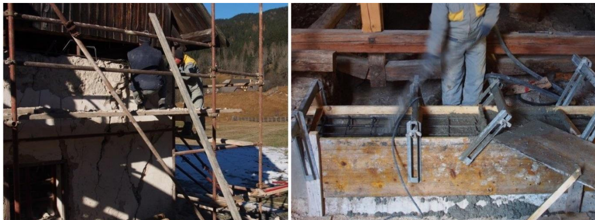
Slika 103: Razbijanje zgornjega dela zidovja s še vidnimi nesanimiranimi konstrukcijskimi razpokami severnega zidovja (levo) in izdelava AB venca za kasnejše naleganje ostrešja (desno).
