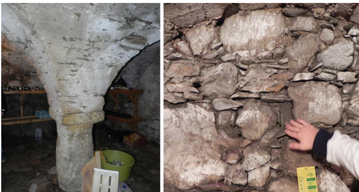
Slika 9: Vliti oboki in monilitni steber v kleti (levo) in kompaktno kamnito zidovje v kleti (desno).
