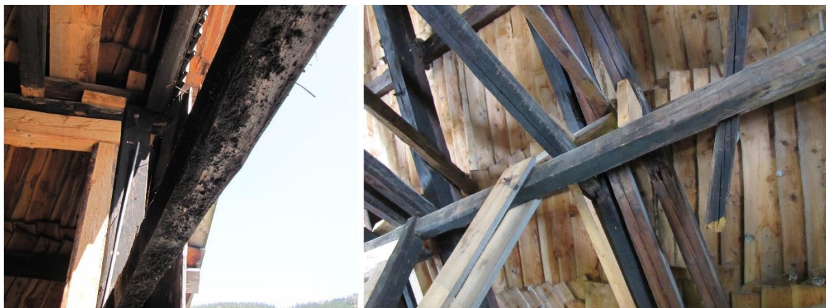
Slika 16: Sajasta lega (levo) in razlika med starimi temnejšimi sajastimi elementi in svetlejšimi elementi (desno).
