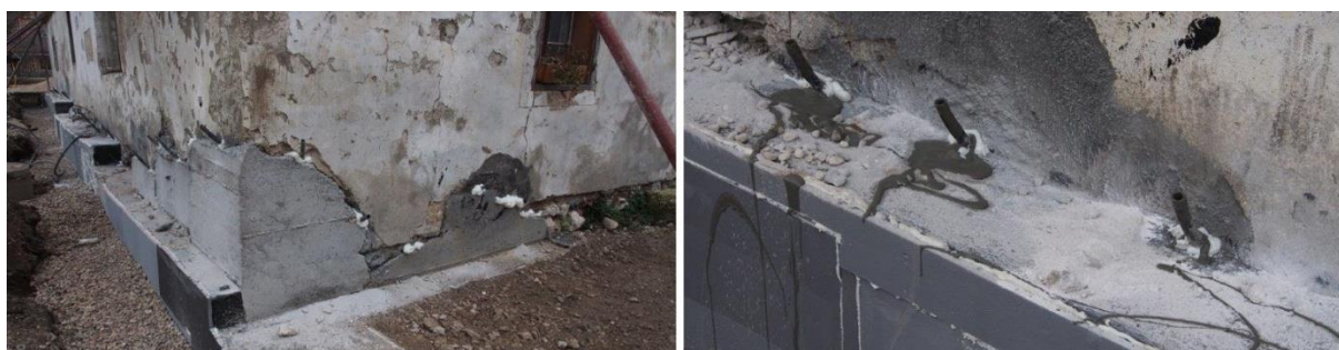
Slika 102: Injiciranje stika med temelji in obstoječim zidovjem.
