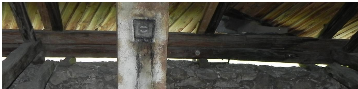
Slika 98: Severna kapna lega, podprta s kosi tramov po celotni dolžini.
