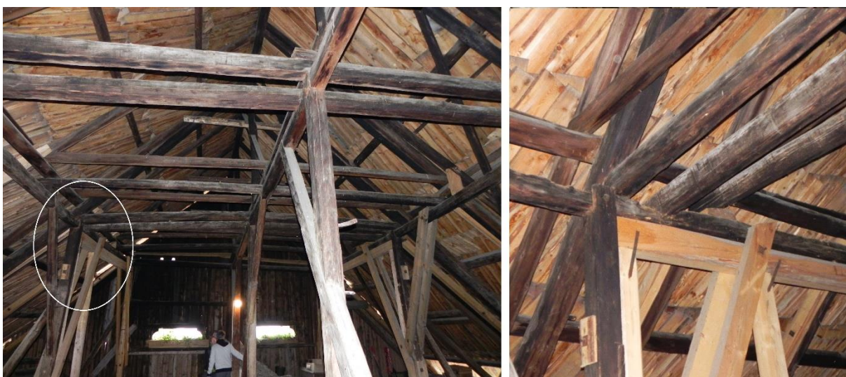
Slika 14: Nosilna konstrukcija ostrešja z vidnimi dodanimi novejšimi elementi (večinoma smrekovina).
