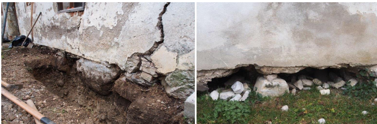
Slika 26: Severni (levo) in južni del zidovja (desno) z naleganjem na skale in temeljnimi tlemi iz prodnate zemljine.
