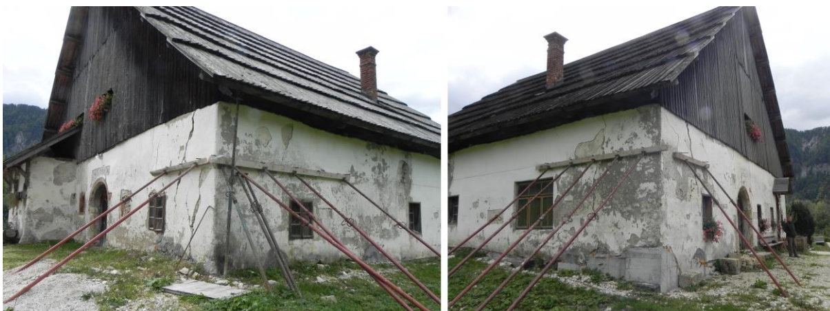
Slika 25 Podprta severovzhodni (levo) in severozahodni vogal (desno).
