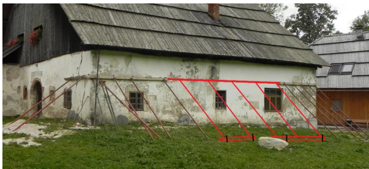
Slika 99: Predlog podpiranja severnega zidovja.
