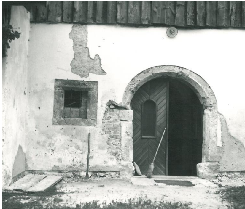
Slika 6: Vzhodna stran hiše, vhod s kamnitim portalom in okenskim okvirjem (Fister, P., 1969).
