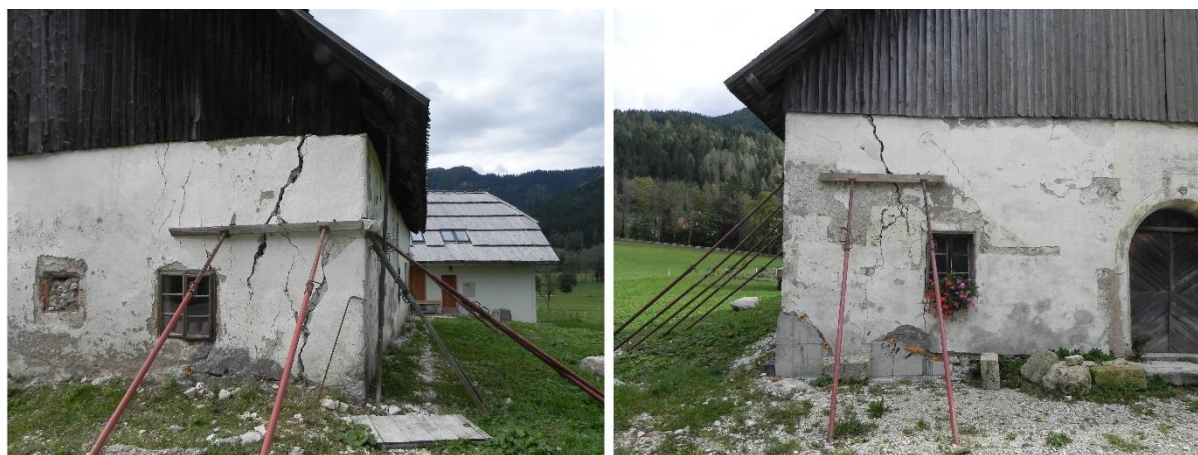
Slika 24: Podprta severovzhodni vogal z 8 cm široko razpoko (levo) in severozahodni vogal s 4 cm široko razpoko (desno).
