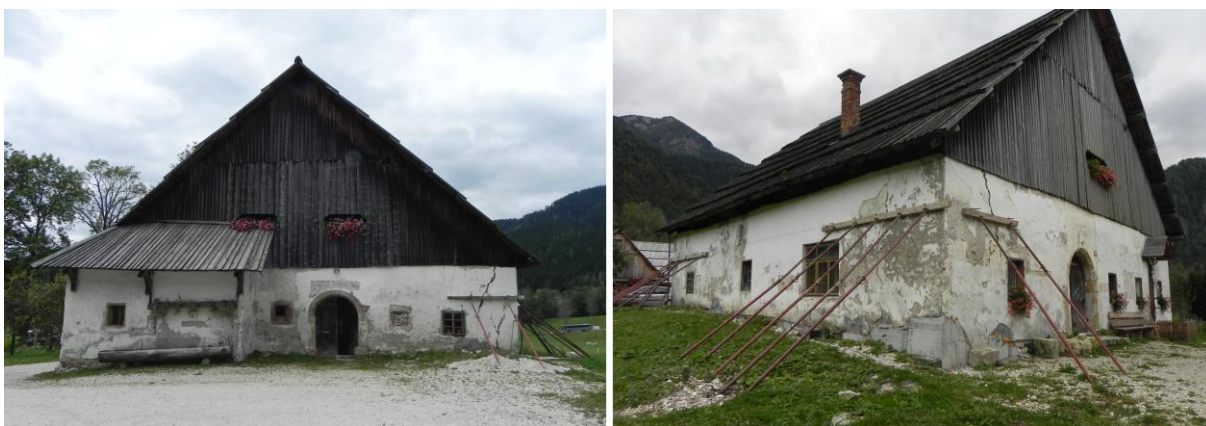
Slika 2: Šenkova domačija na Zgornjem Jezerskem z začasnimi horizontalnimi podporami poškodovanega severnega zidu.
