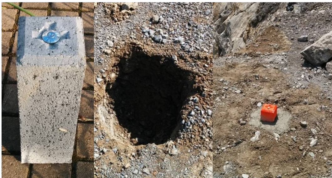
Slika 21: Stabilizacija novih točk izmeritvene mreže
