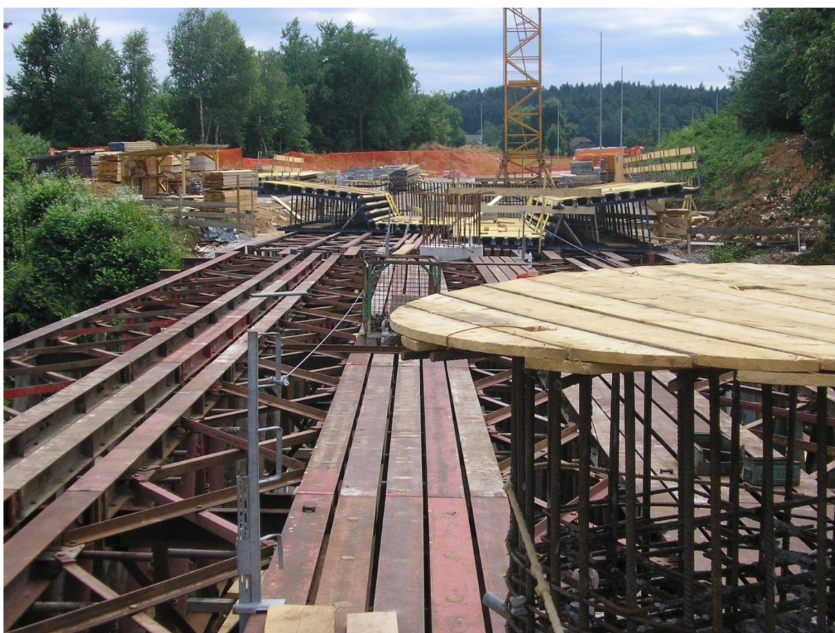
Slika 32: Prikaz postavitve opažne konstrukcije na podporno konstrukcijo (lasten vir)
