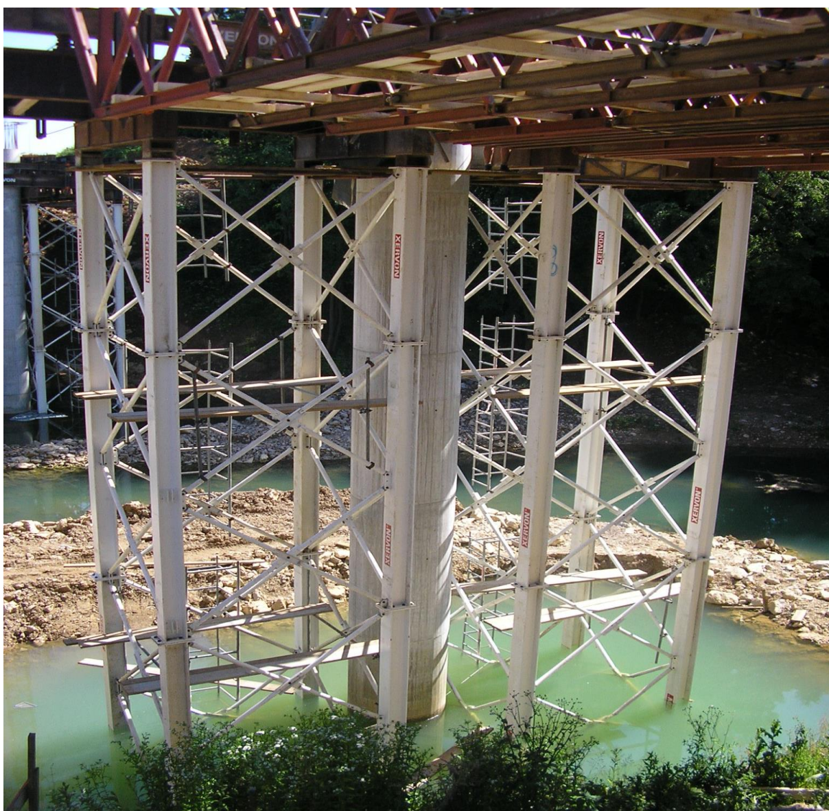
Slika 27: Prikaz sestave stolpov v podpori P1 (lasten vir)
