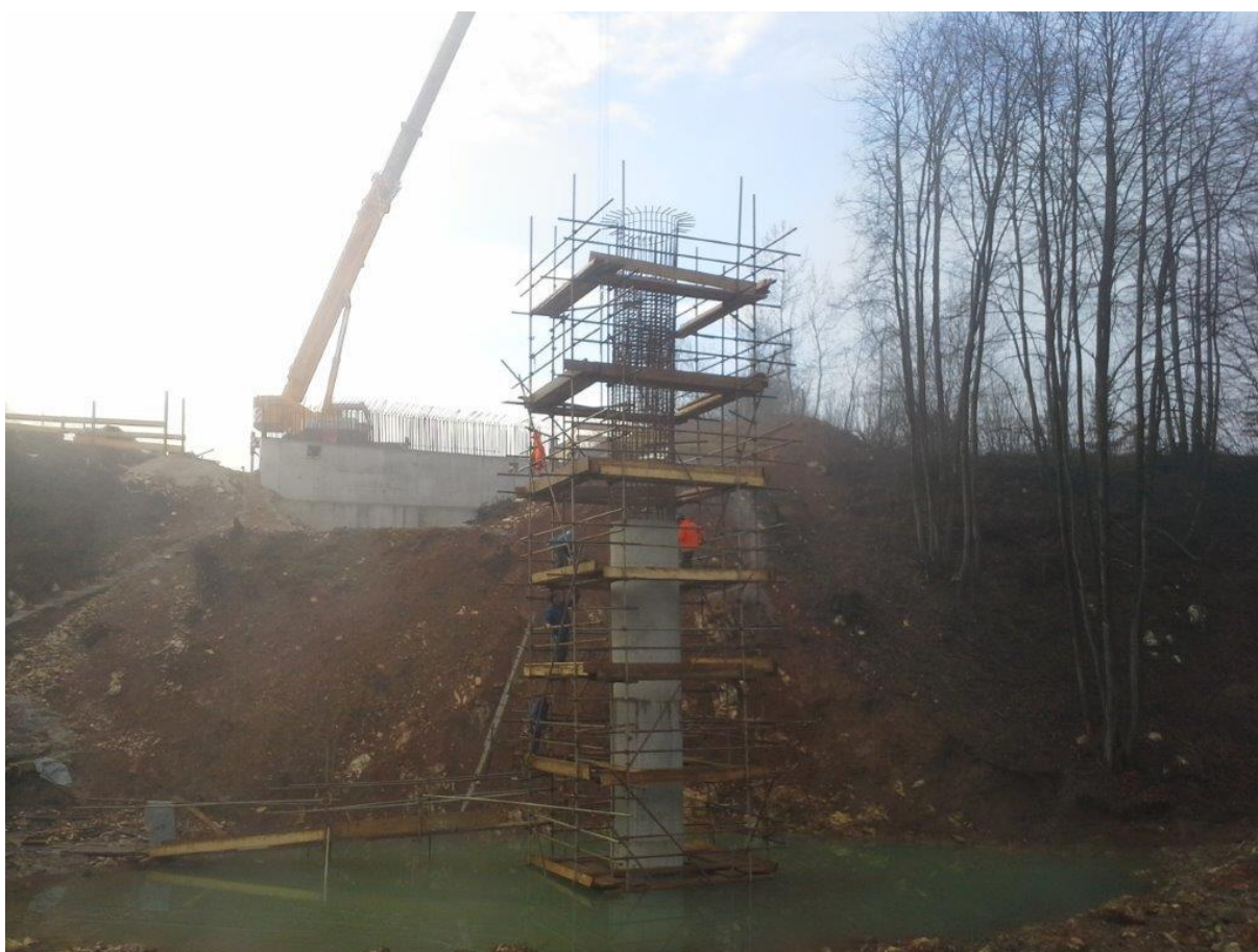
Slika 23: Prikaz izvedbe stebra v podpori P2 (lasten vir)
