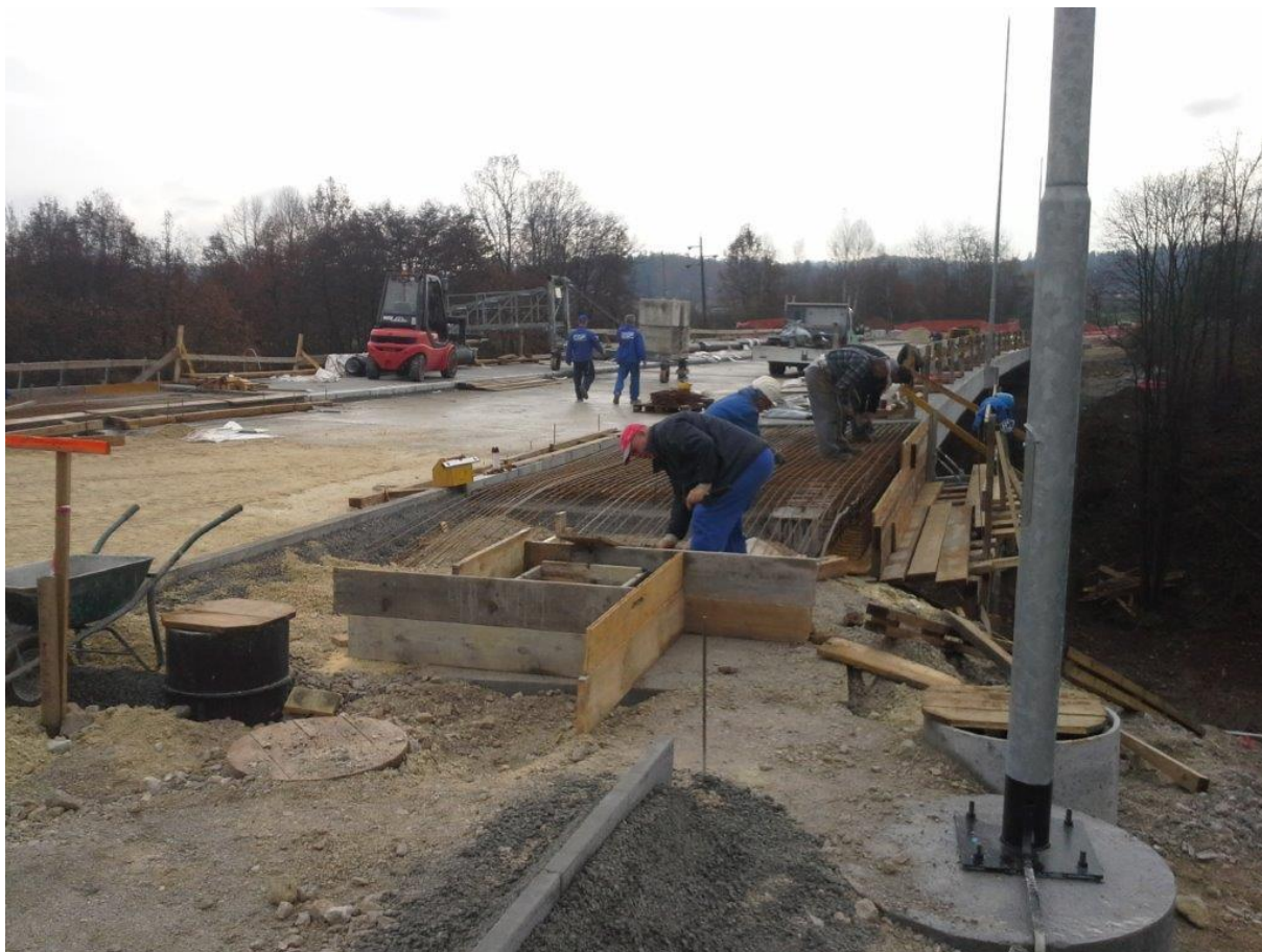
Slika 42: Prikaz izdelave zadnje faze – izdelave robnih vencev na mostu (lasten vir)
