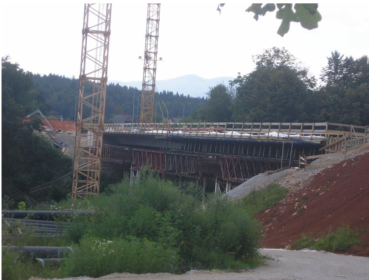
Slika 37: Prikaz demontaže opazne konstrukcije mostu (lasten vir)
