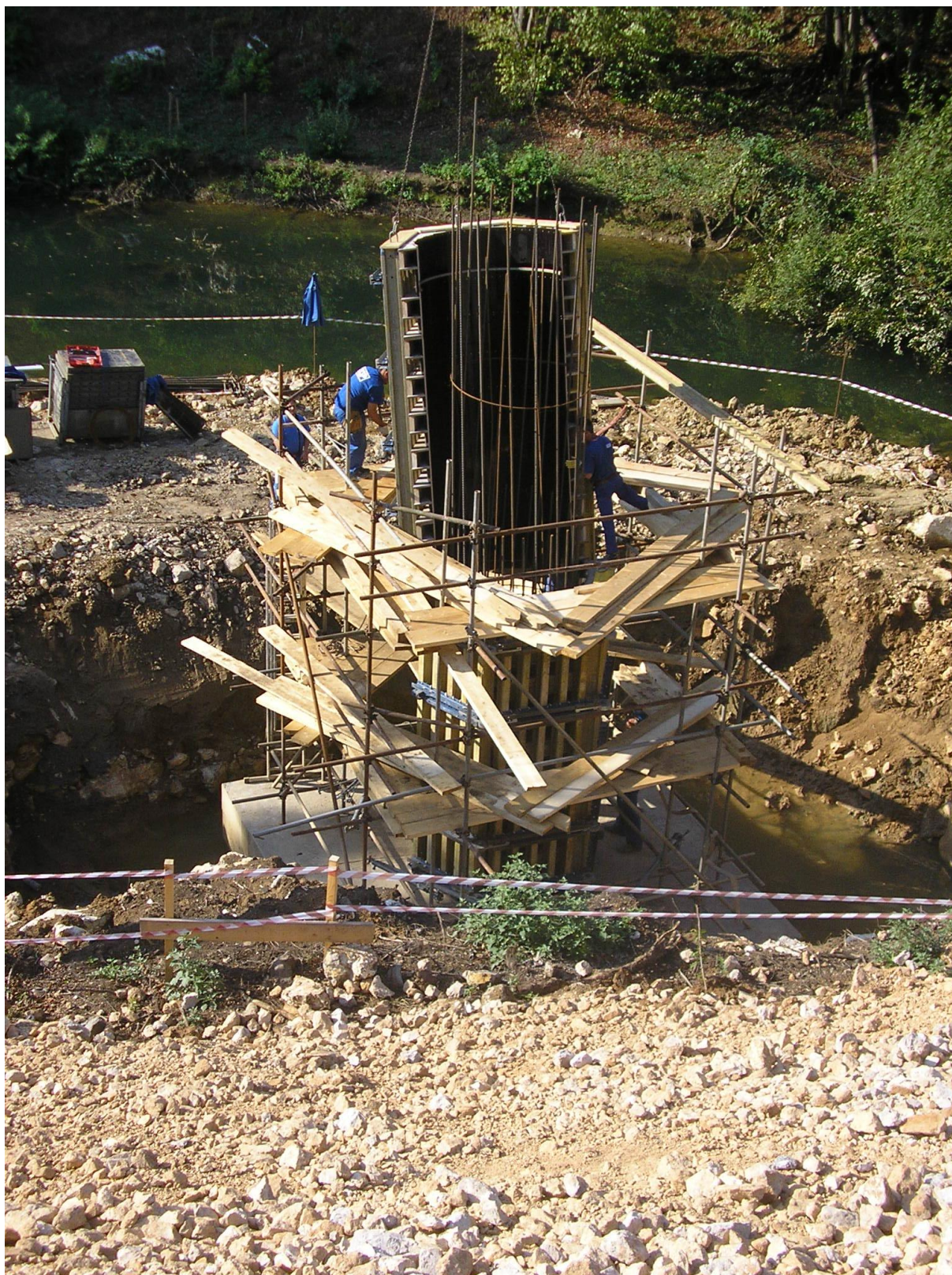
Slika 24: Prikaz izvedbe stebra v podpori P1 (lasten vir)
