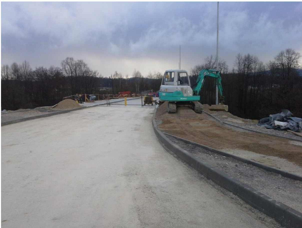
Slika 41: Prikaz izdelave kamnitega nasipa do mostu (lasten vir)
