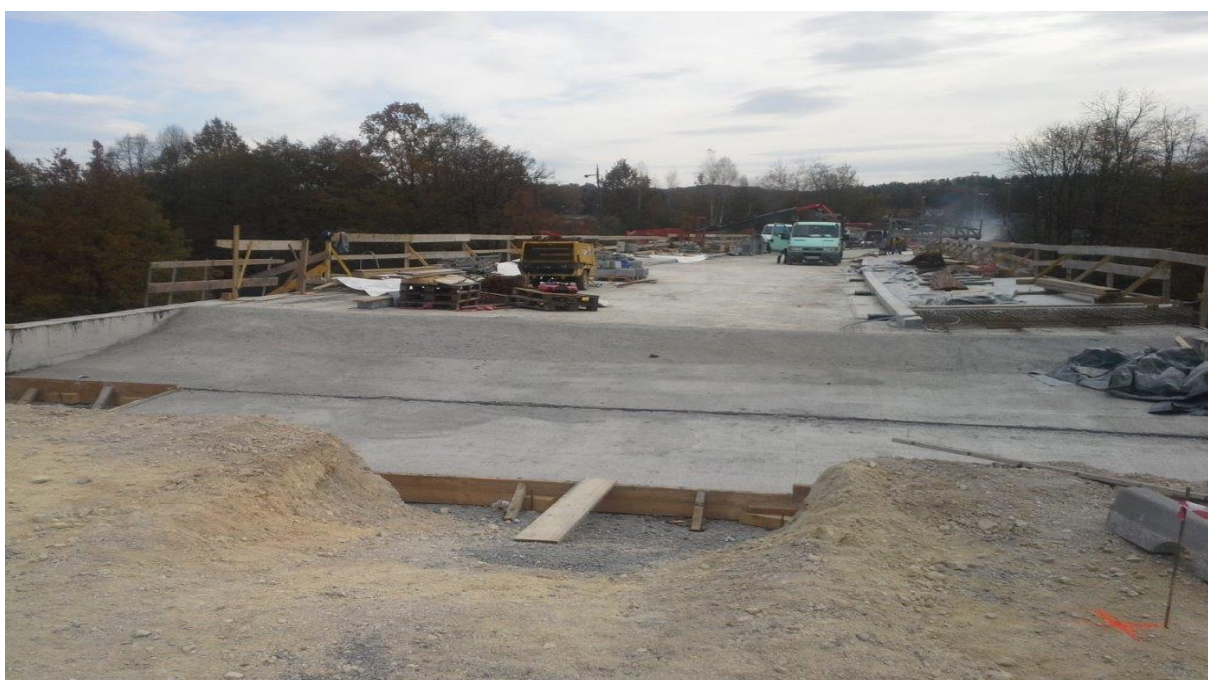
Slika 40: Prikaz izdelave prehodne plošče mostu (lasten vir)
