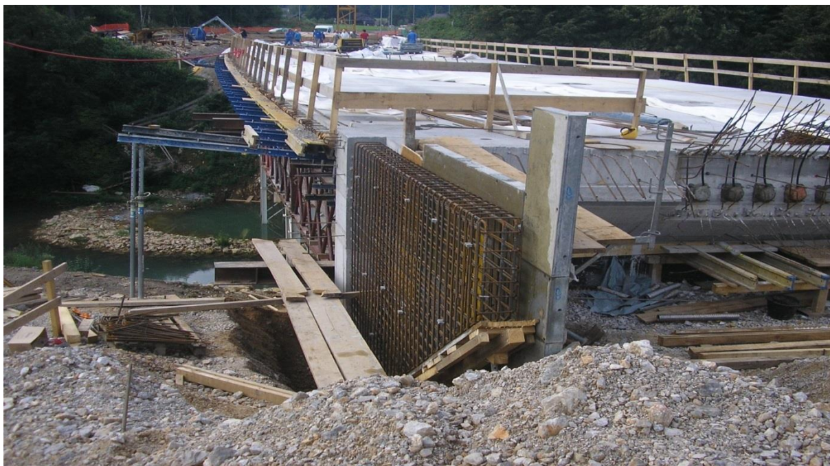
Slika 39: Prikaz izdelave krilnega zidu mostu (lasten vir)
