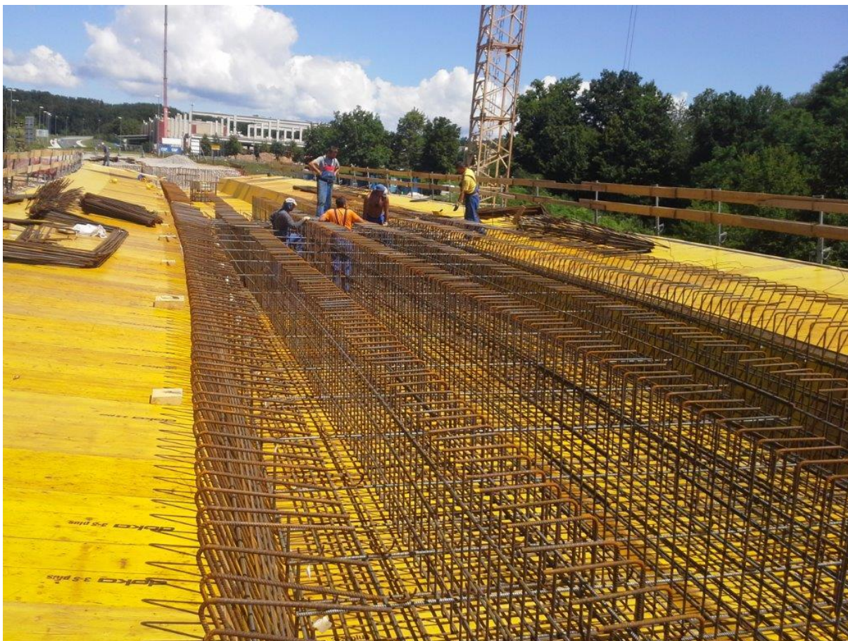
Slika 33: Prikaz polaganja in vezanje armature na mostu (lasten vir)
