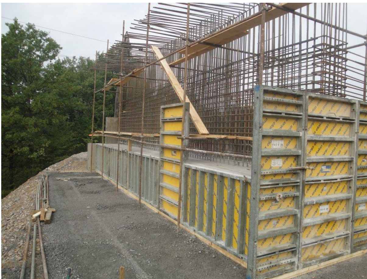
Slika 22: Prikaz izvedbe temeljne blazine v osi P0. (lasten vir)
