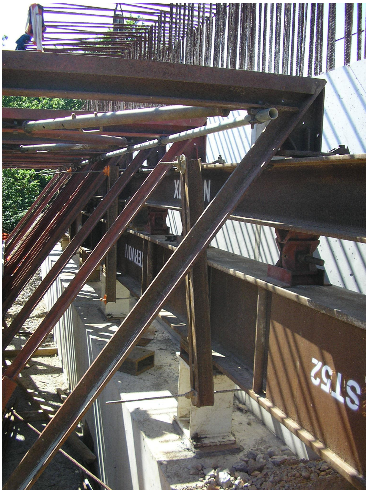
Slika 26: Prikaz naleganja podporne konstrukcije v podpori P0 (lasten vir)
