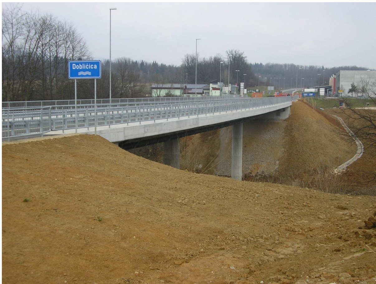
Slika 45: Prikaz zaključna dela na mostu (lasten vir)
