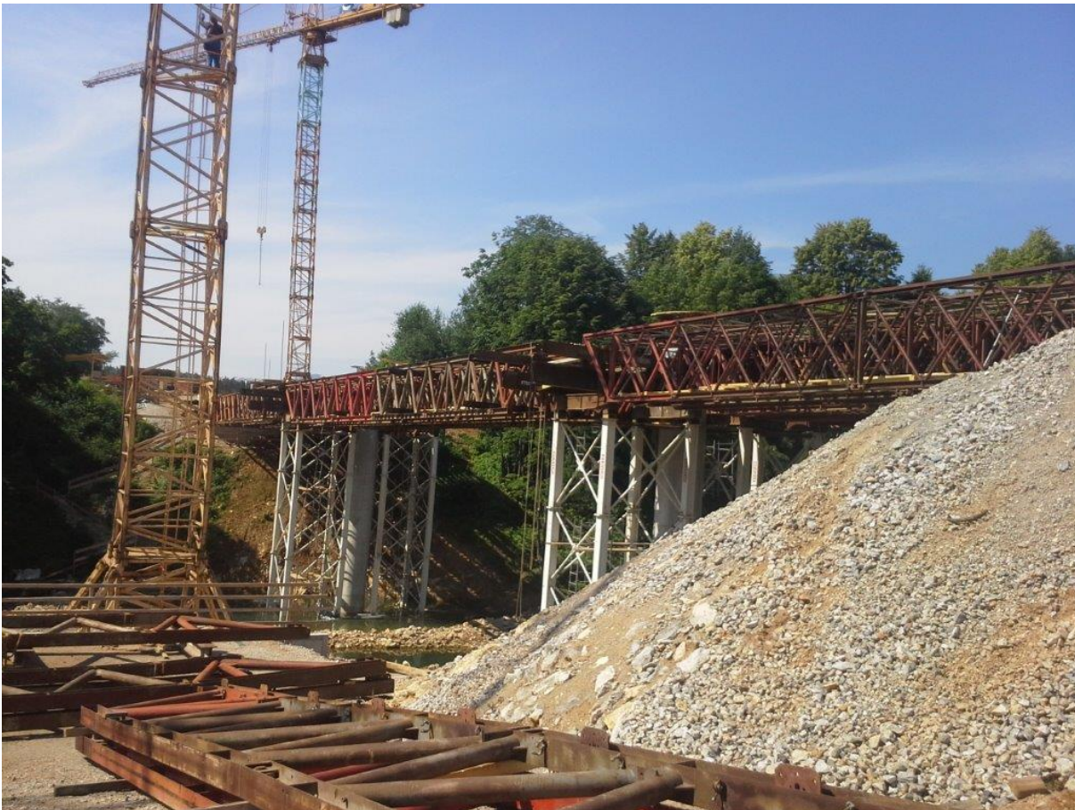
Slika 9: Prikaz podporne konstrukcije (lasten vir)
