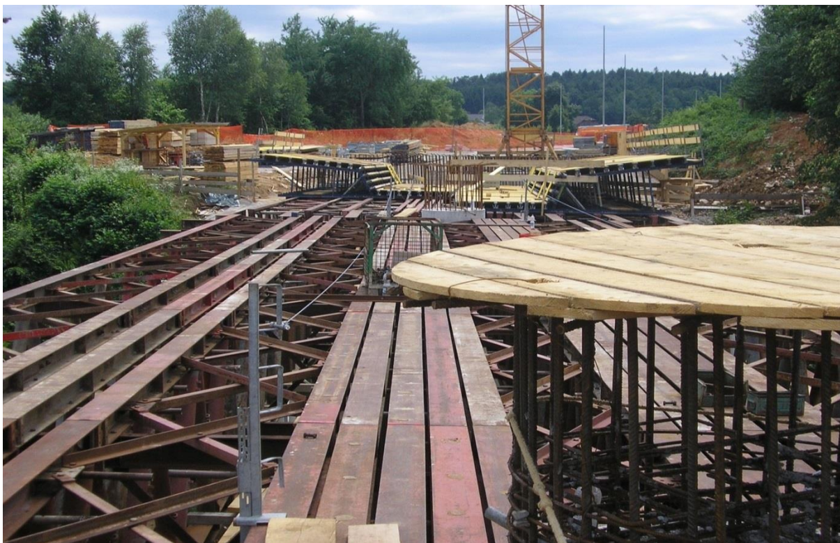
Slika 11: Prikaz podporne in opažne konstrukcije (lasten vir)
