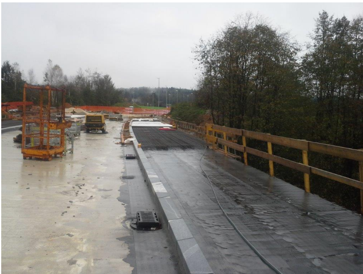
Slika 38: Prikaz izdelave robnega venca mostu (lasten vir)
