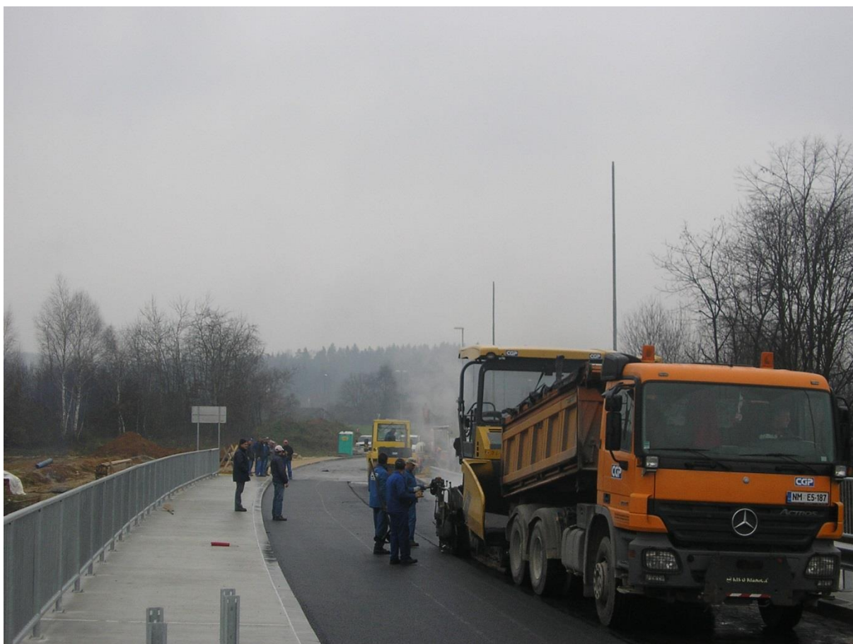
Slika 44: Prikaz asfaltiranje mostu (lasten vir)
