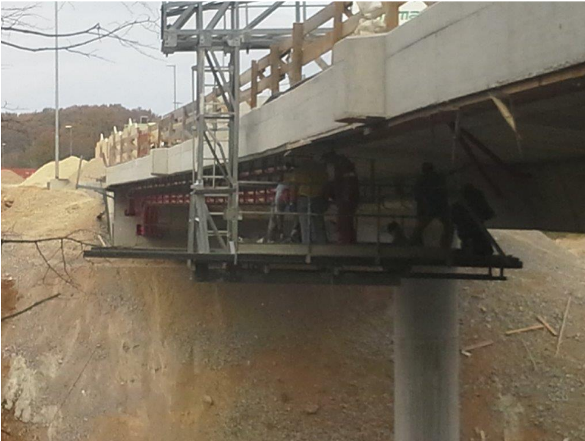
Slika 43: Prikaz montaže instalacij pod robnim vencem na mostu (lasten vir)
