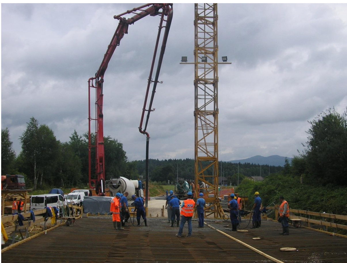
Slika 36: Betoniranje prekladne konstrukcije mostu (lasten vir)
