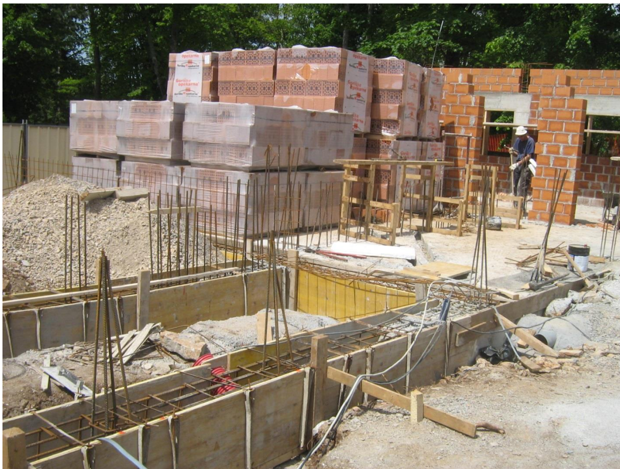
Slika 11: Zidanje sten in izvedba temeljev
