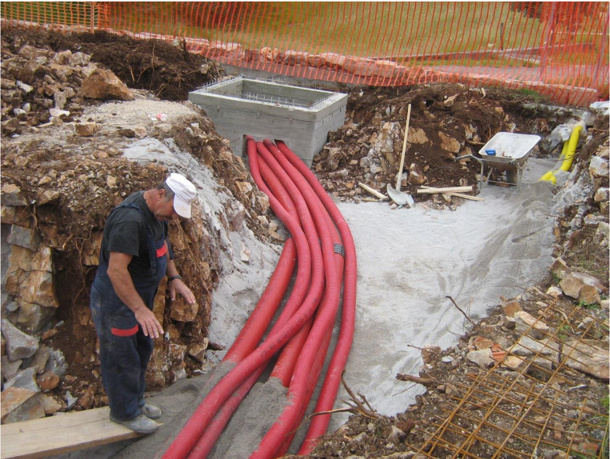
Slika 24: Izdelava kanalske instalacije
