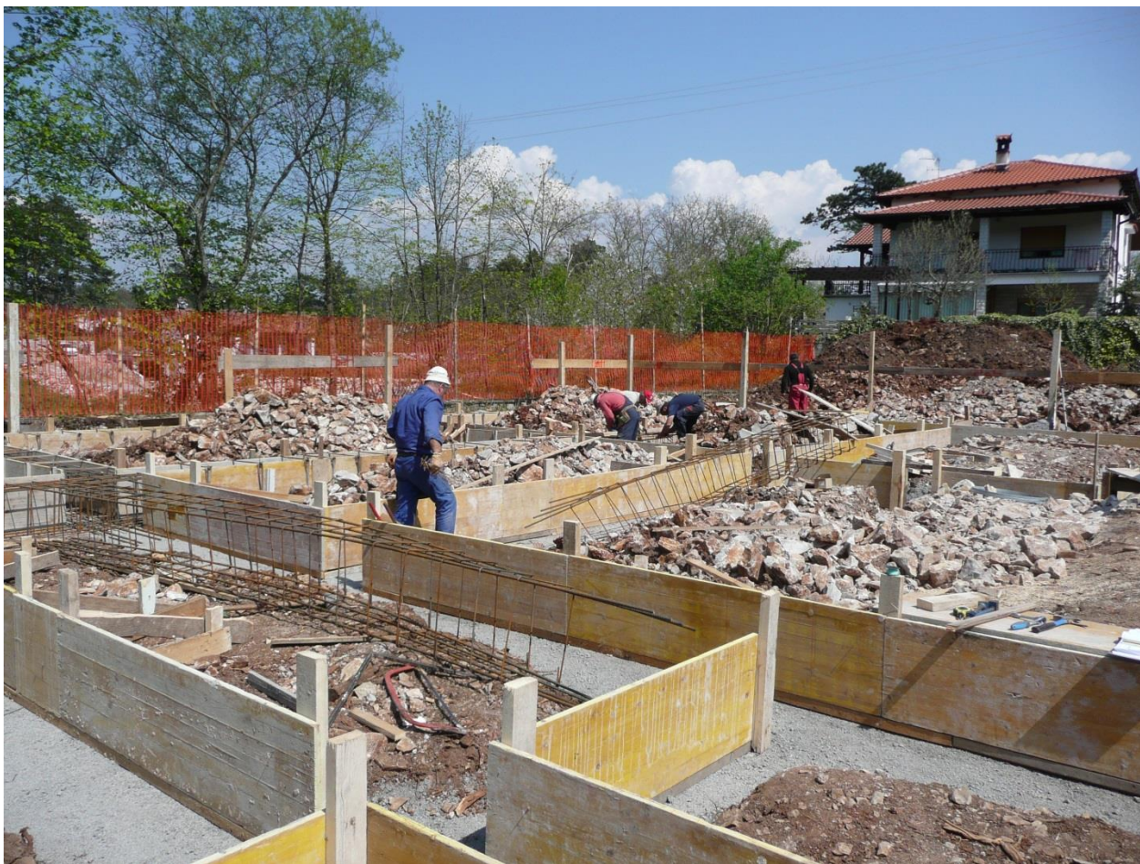
Slika 10: Izvedba temeljev
