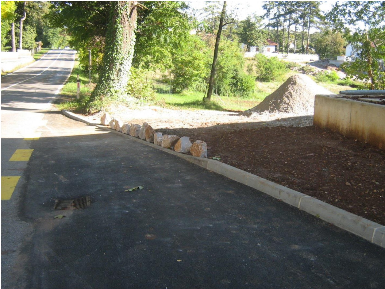
Slika 23: Izdelava priključka do kmetijskih zemljišč
