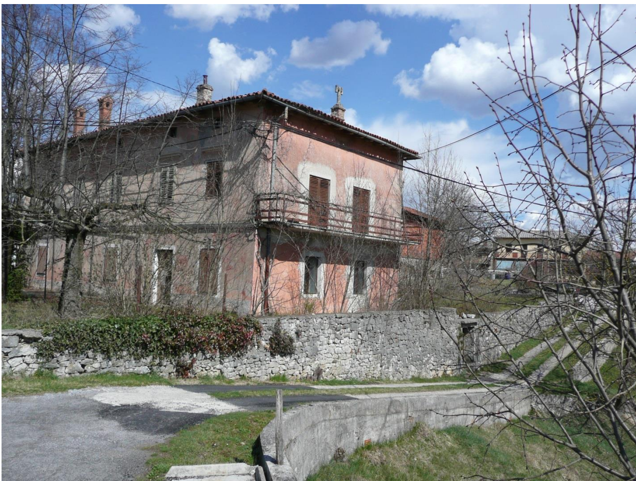
Slika 5: Objekt in kamniti zid, ki sta predvidena za rušenje
