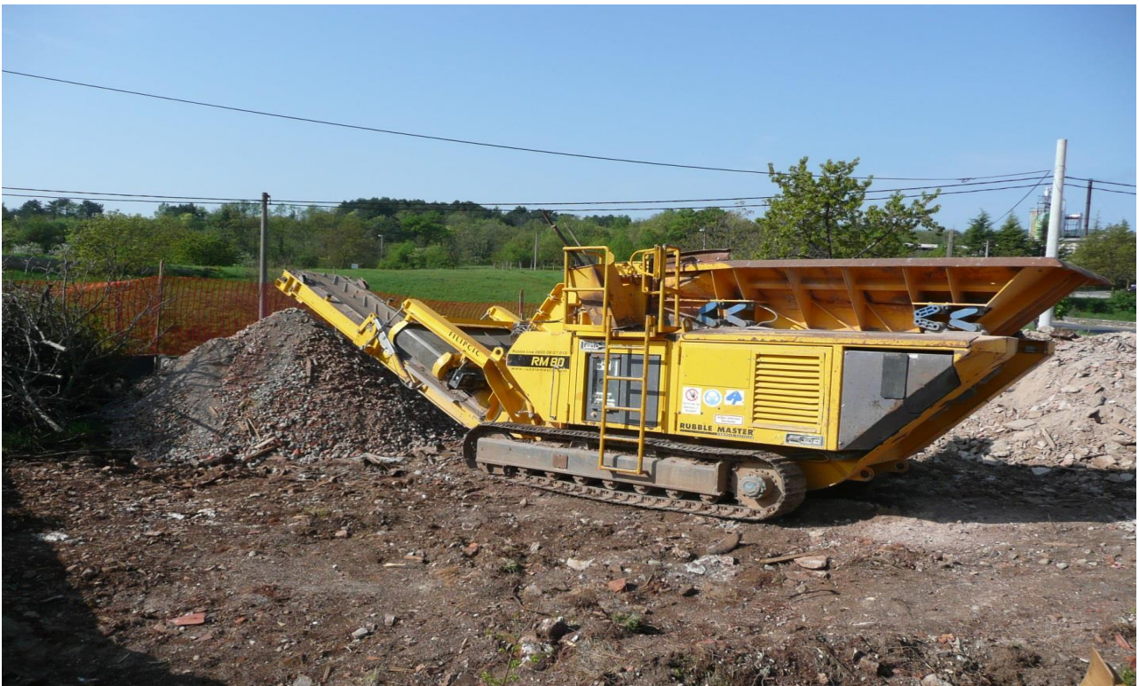
Slika 8: Mletje ruševin na gradbišču
