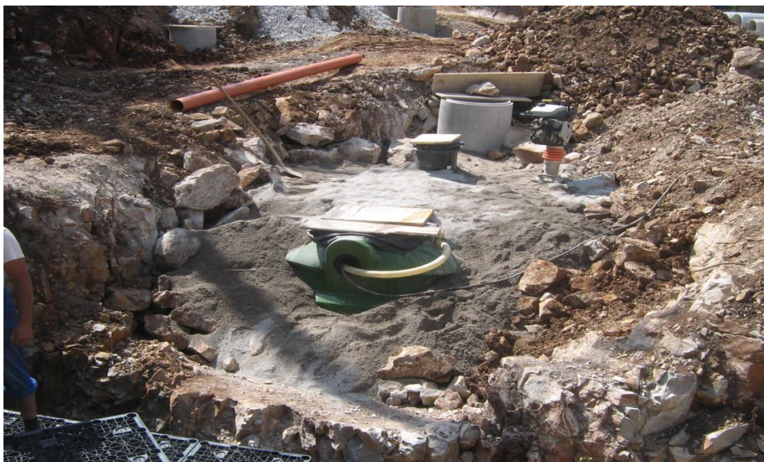
Slika 15: Čistilna naprava in lovilec olj
