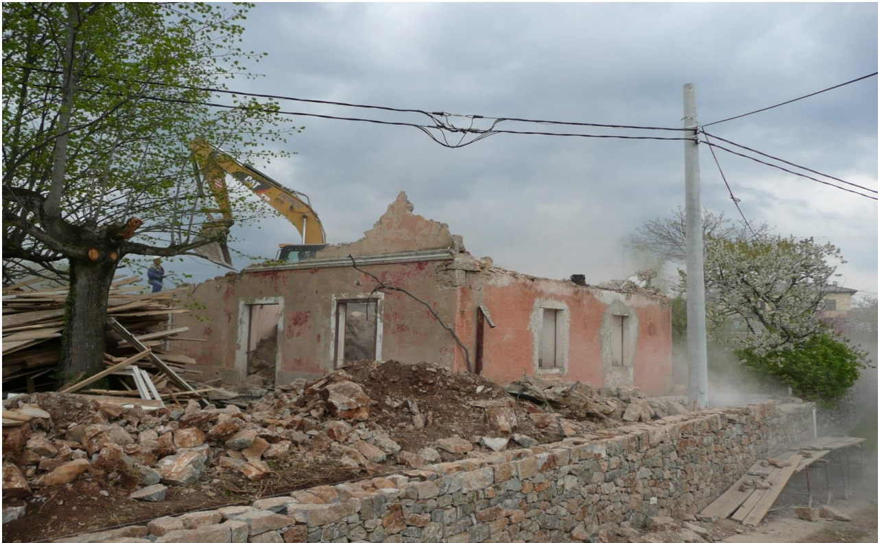
Slika 7: Rušenje zahodna stran
