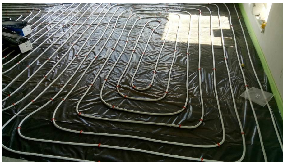
Slika 31: PE folija in PVC cevi talnega gretja
