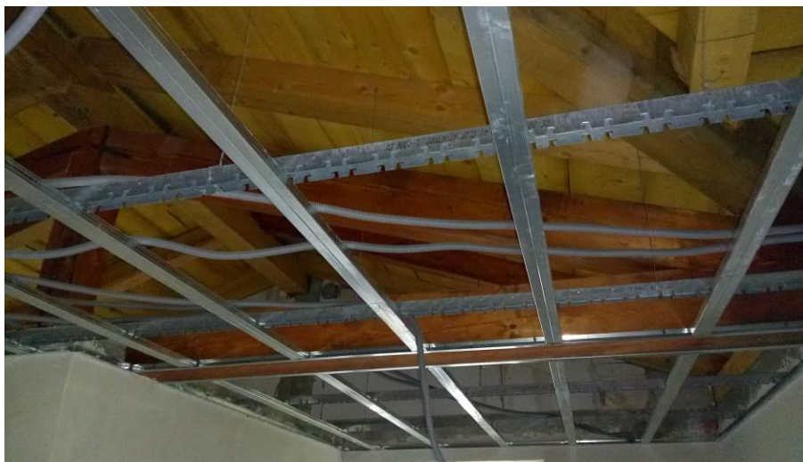
Slika 25: Podkonstrukcija gips visečega stropa
