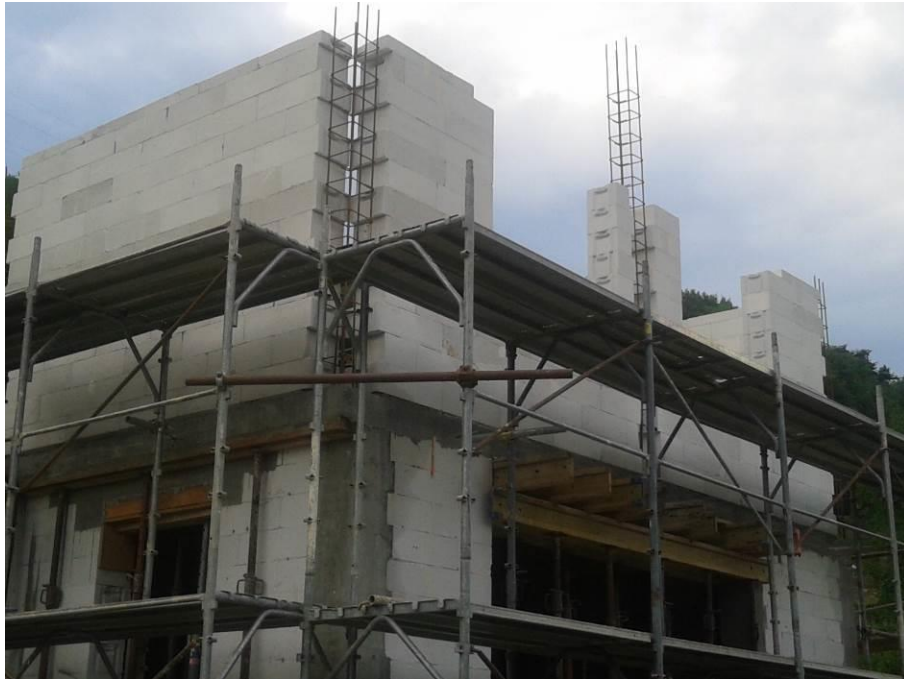
Slika 18: Armatura vertikalnih vezi v nadstropju
