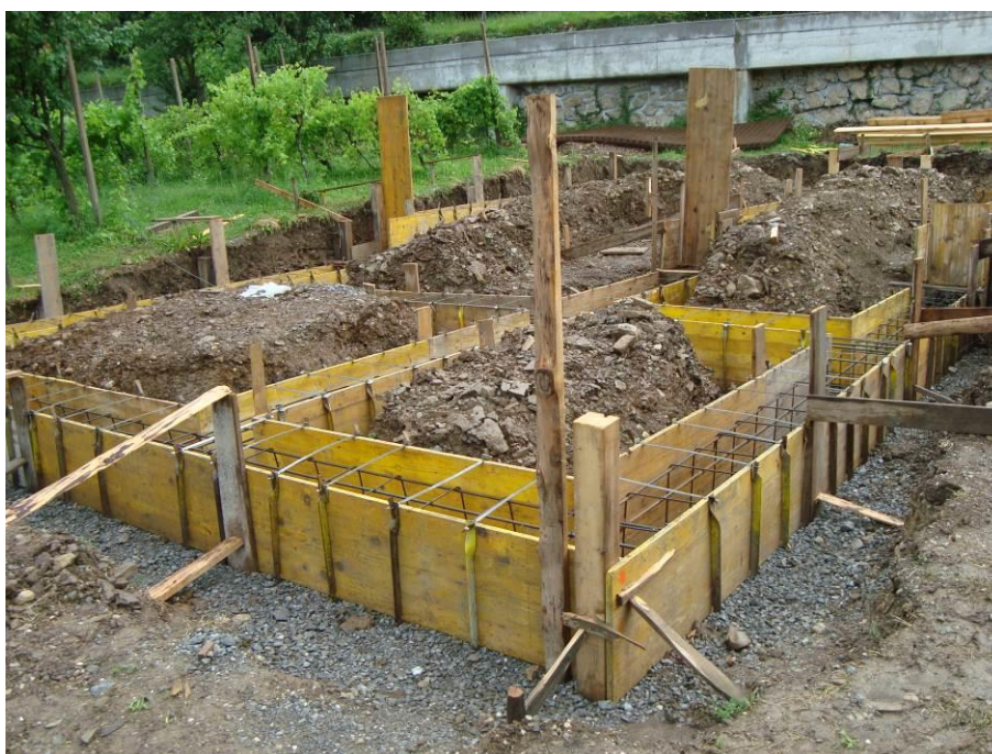
Slika 7: Opaž in armatura pasovnih temeljev
