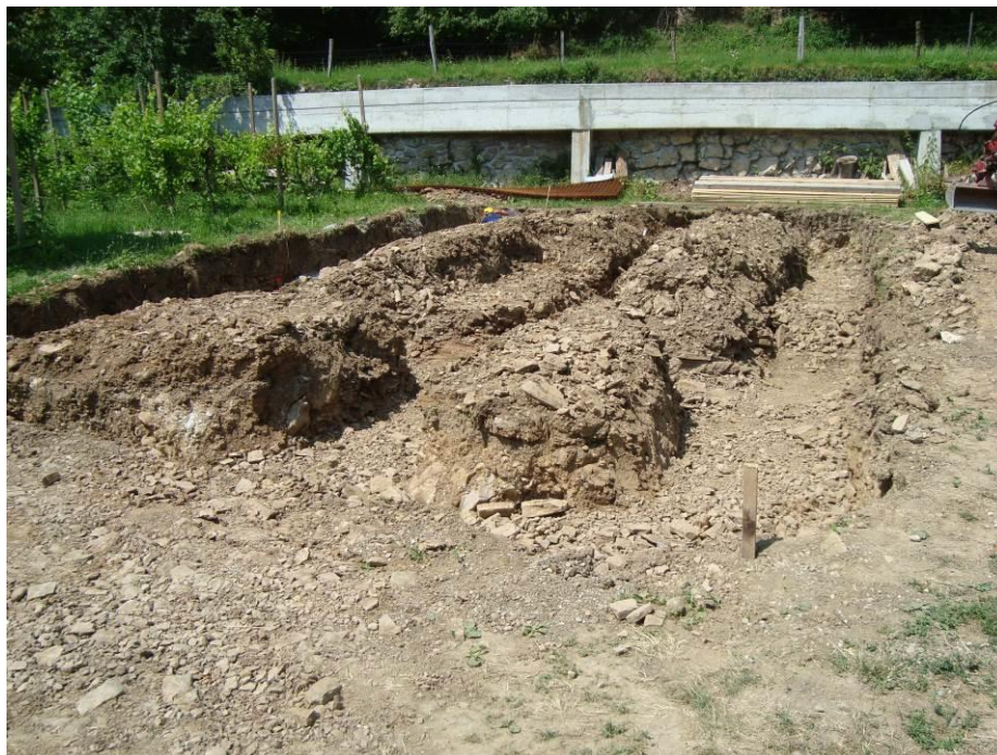
Slika 4: Izkop jarkov za pasovne temelje
