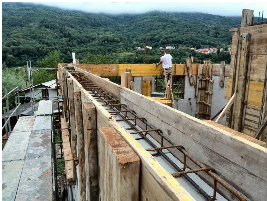
Slika 20: Armatura horizontalnih vezi in preklad v nadstropju
