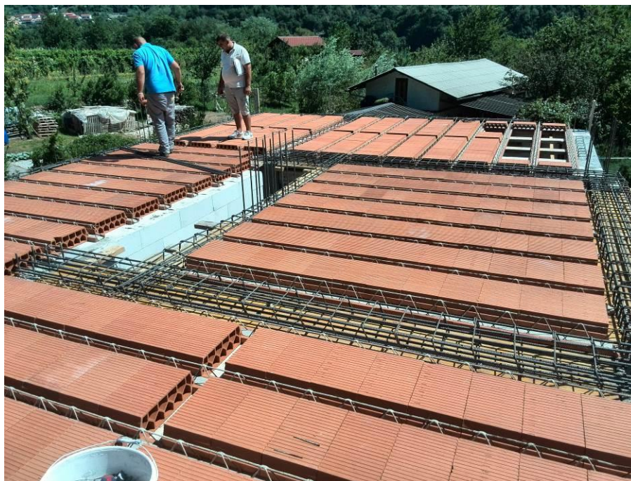
Slika 11: Travetna plošča nad pritličjem
