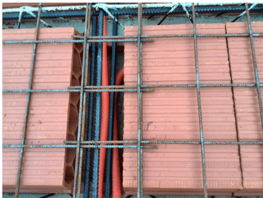
Slika 13: Cevi za električno instalacijo
