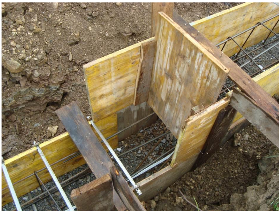
Slika 6: Izdelava kaskade pasovnega temelja
