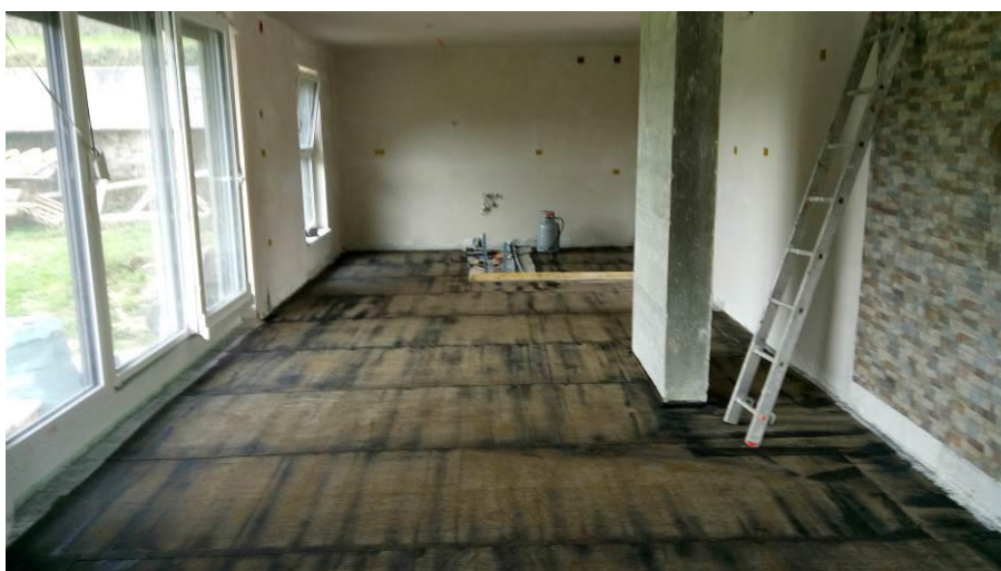
Slika 29: Horizontalna hidroizolacija talne plošče v pritličju
