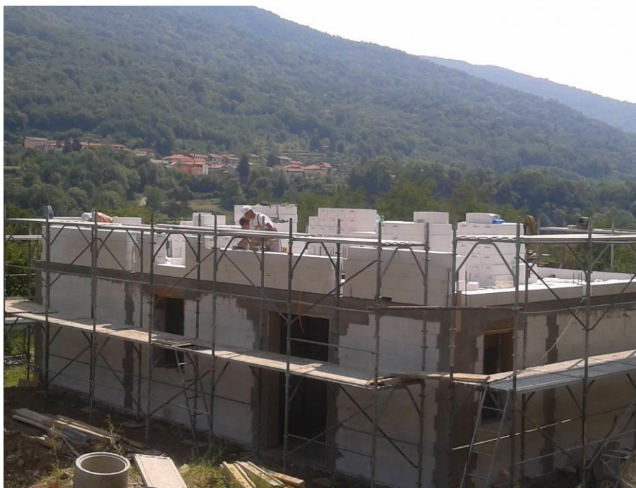
Slika 17: Nosilne stene nadstropja iz porobetona
