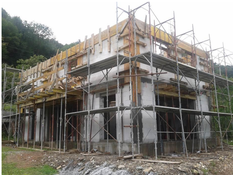
Slika 19: Opaž vertikalnih in horizontalnih vezi v nadstropju
