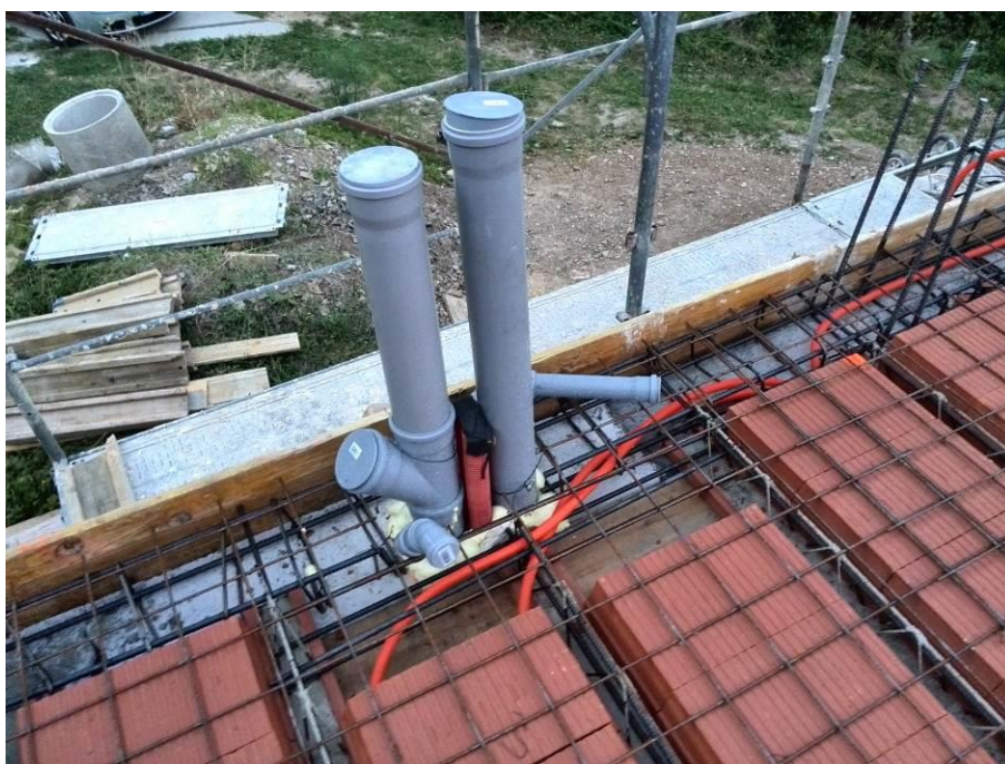
Slika 14: Vertikalne PVC cevi za fekalno kanalizacijo in odzračevanje
