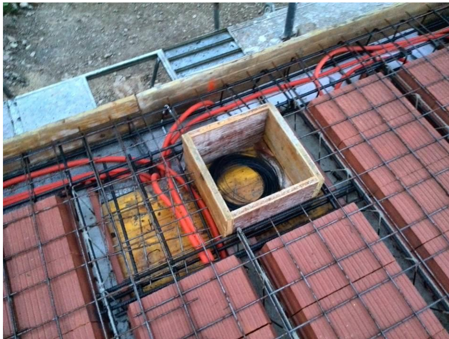
Slika 15: Opaž za vertikalni prehod instalacije skozi ploščo
