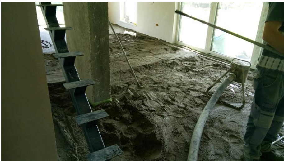
Slika 32: Izdelava estriha
