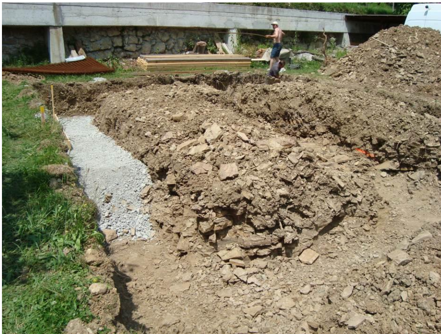
Slika 5: Izravnava dna izkopa za izdelavo opaža temeljev
