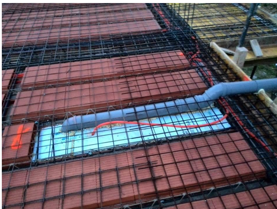
Slika 16: PVC cevi za odzračevanje kuhinjske nape
