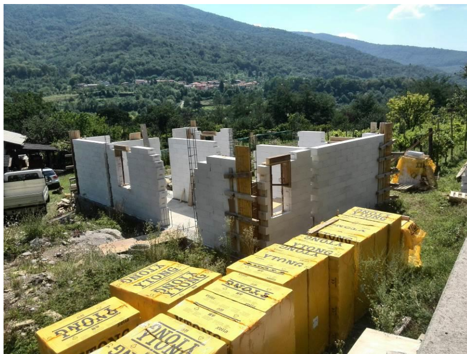
Slika 10: Nosilne stene pritličja iz porobetona
