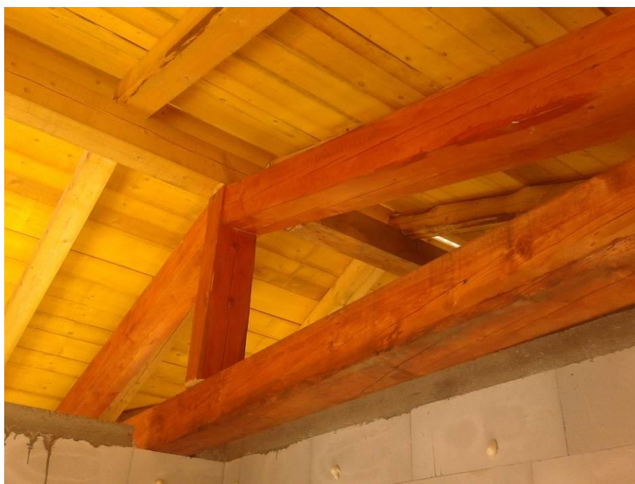
Slika 22: Zaščiten »kosmati« opaž ostrejša proti škodljivcem in pobarvano trikotno vešalo
