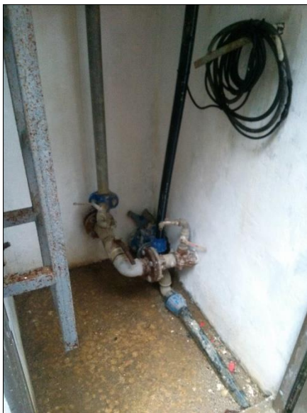
Slika 72: Dovodna cev (levo) in iztočna (desno) pred vodno celico
