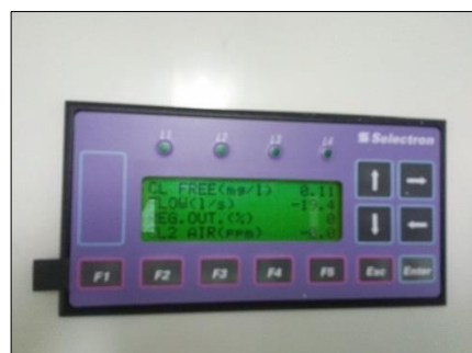
Slika 57: Digitalni način dodajanja klora
