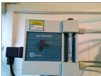
Slika 56: Kloriranje na "stari" način - z merilno cevko in kroglico
