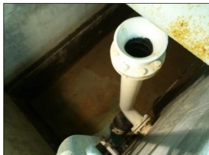
Slika 77: Košara za odvzem vode in prelivni profil cevi
