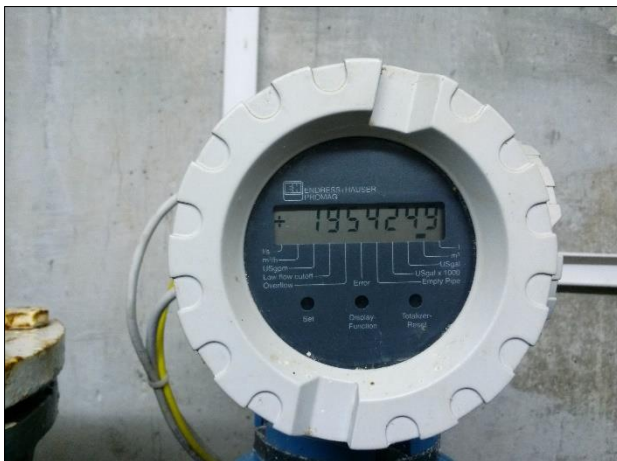
Slika 52: Merilnik pretoka - skupni pretok iz vrtine
