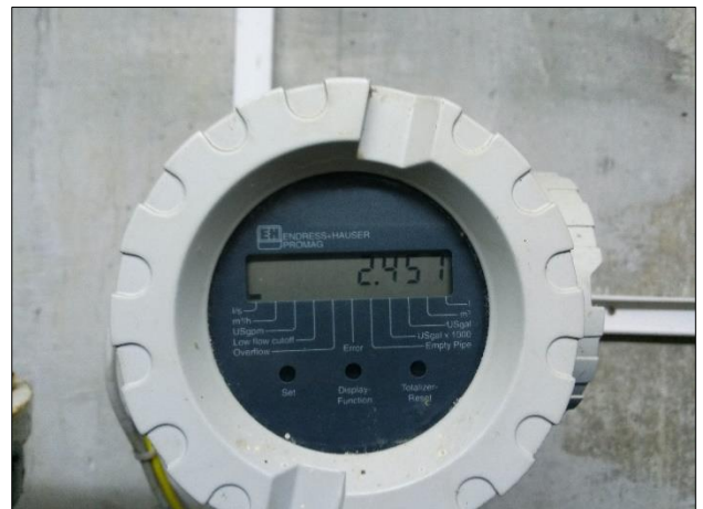
Slika 51: Merilnik pretoka - trenutni pretok (l/s)
