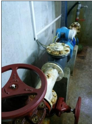
Slika 50: Cev iz vrtine z merilcem pretoka
