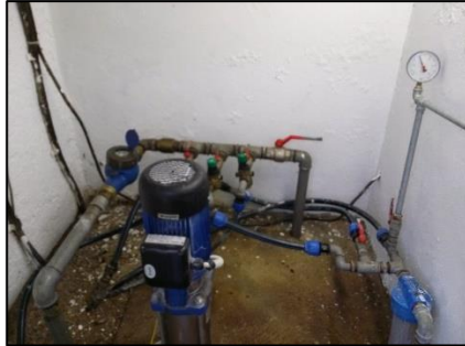
Slika 67: Prostor s črpalko, merilcem tlaka in merilcem pretoka
