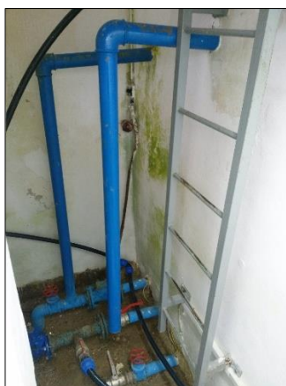
Slika 66: Dotočna in iztočna cev iz vodne celice
