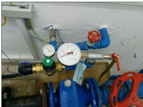
Slika 64: Merilnik tlaka v prečrpališču Avguštine
