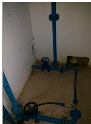
Slika 74: Vtočna in iztočna cev s talnim izpustom
