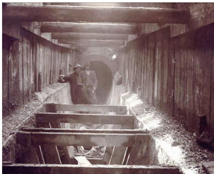
Slika 8: Gradnja kanalizacije po Šmartinski cesti leta 1929 (vir: JP VO-KA)
