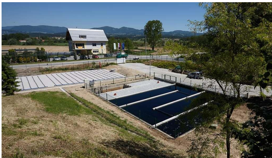
Slika 29: Rastlinska čistilna naprava Bukovžlak [45].
