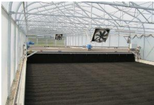
SLIKA 25: Primer manjšega šotora za solarno sušenje ( http://www.gtwe-nu.com/water-treatment/waste-water-treatment/huber-waste-water-technology-costa-rica/ )
