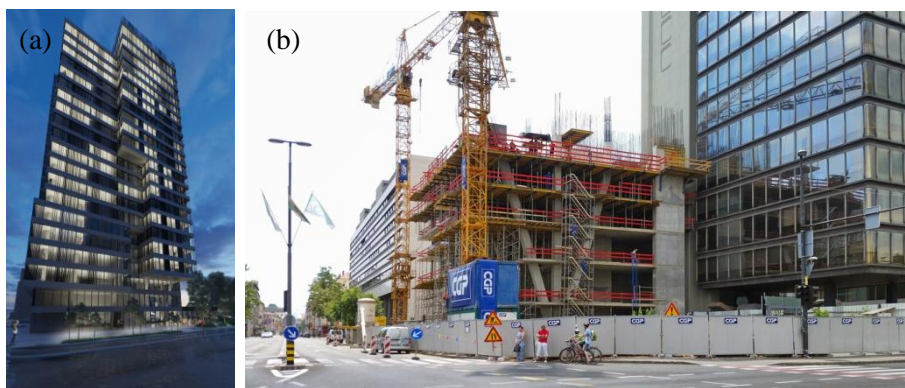
Slika 8: (a) Steklена fasada in (b) gradbišče dne 30.7.2016 (SkyscraperCity, 2016)
