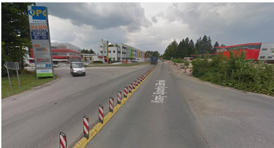
Slika 57: Pogled na križišče pred preureditvijo, smer Kranj [31]
