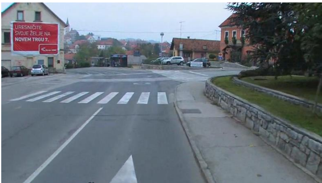
Slika 85: Pogled na križišče Kandijska cesta v nasprotni smeri stacionaže
