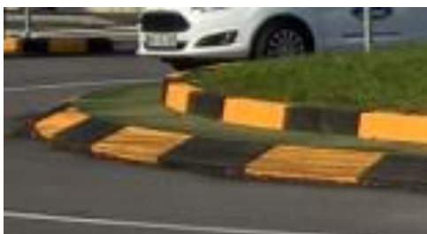
Slika 20: Montažni elementi krožnik križišč: reciklirana guma, montažni vodilni robnik in plastična varnostna ograja
