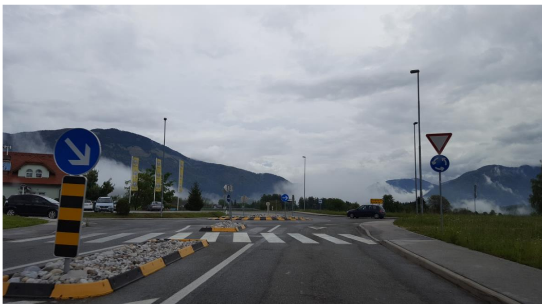
Slika 32: Izvedeno stanje, montažno krožno križišče znotraj obstoječih gabaritov križišča, pogled iz smeri avtoceste proti Radovljici
