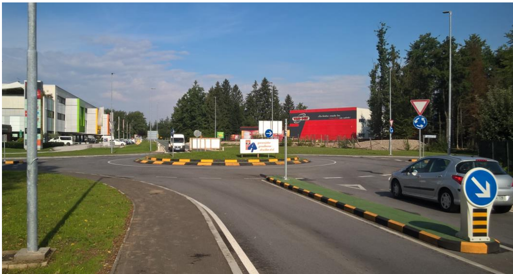
Slika 60: Pogled na zgrajeno križišče v smeri Kranja
