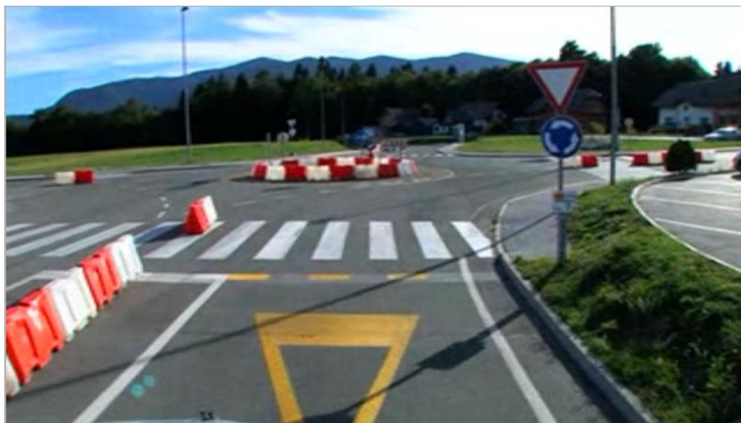
Slika 29: Izvedeno stanje – začasna oblika križišča (1. stopnja reševanja problematike), pogled na križišče iz smeri Radovljica
