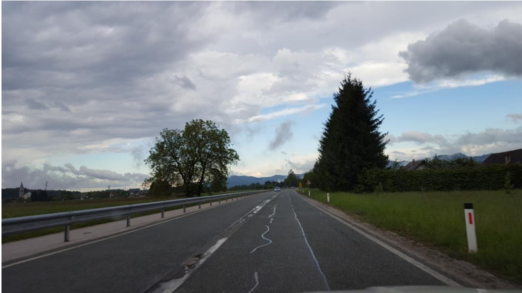
Slika 25: Potek ceste ca 350 m pred križiščem iz smeri Radovljice
