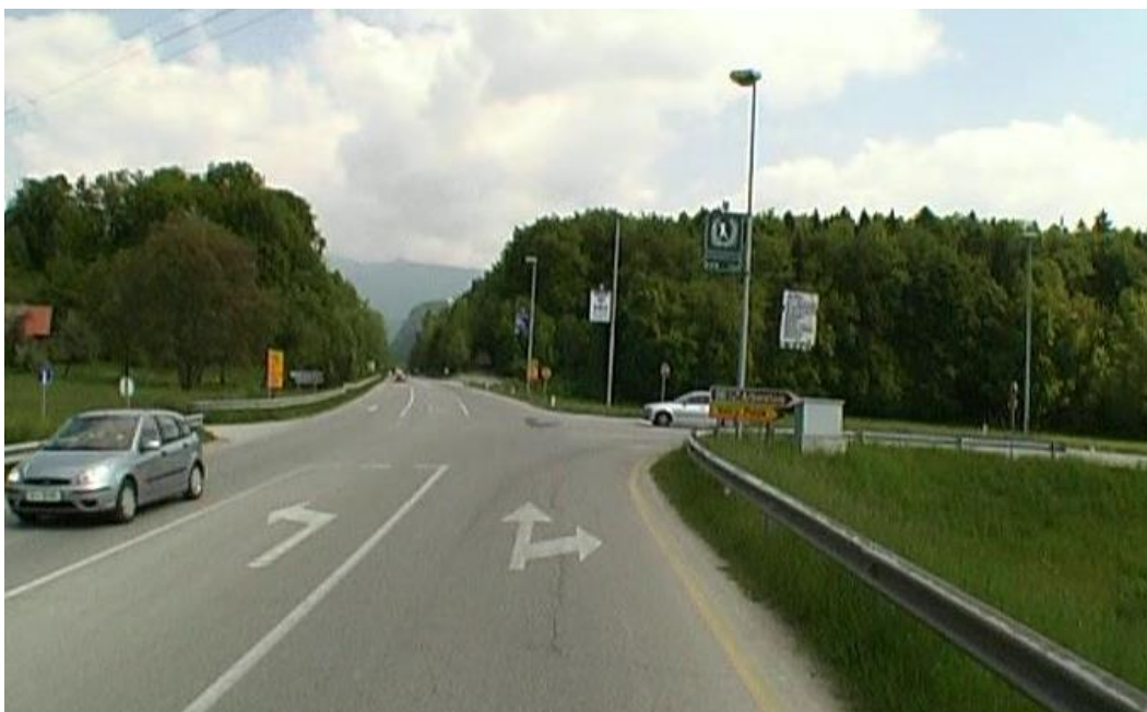
Slika 76: Pogled iz smeri Duplice proti Kamniku
