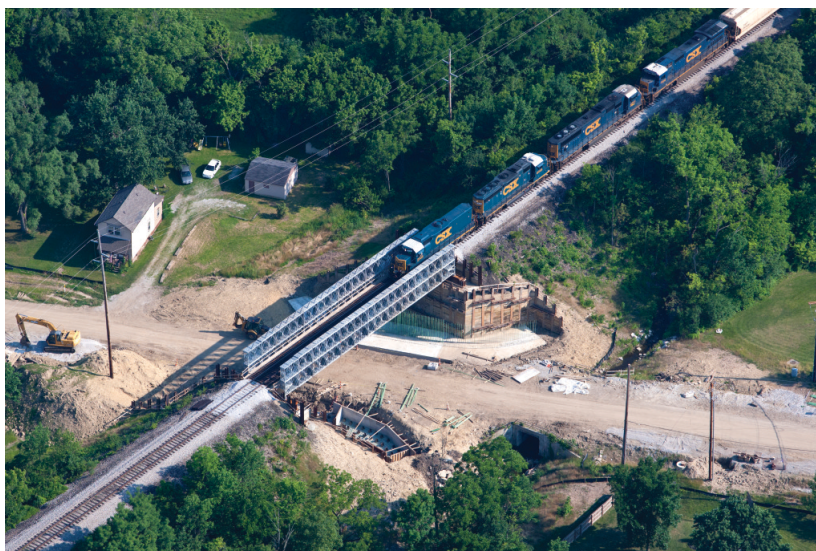
Slika 12: Primer obremenilnega preizkusa mostu (Acrow, 2016).
