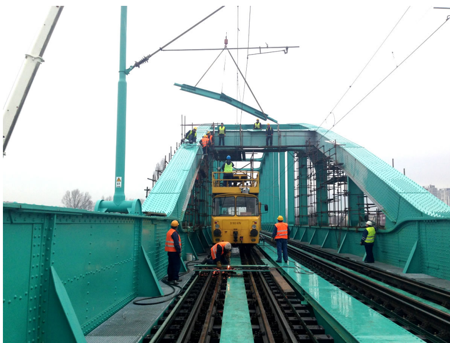
Slika 25: Primer obnove železniškega mostu (Most na Savi, 2016).
