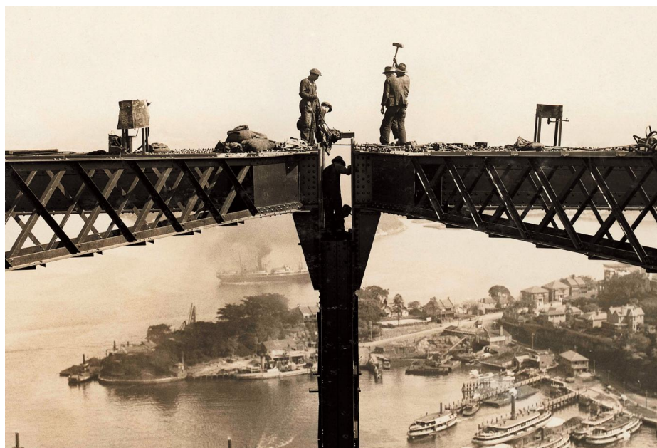
Slika 1: Gradnja mostu v Sydneyju leta 1925 (Sydney living museum, 2016).
