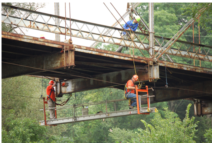
Slika 24: Pregled stanja jeklenega železniškega mostu (Harcon, 2016).
