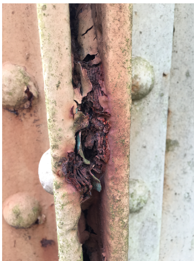
Slika 58: Korozija v stiku oz. razpoki skupaj s propadom kovic.
