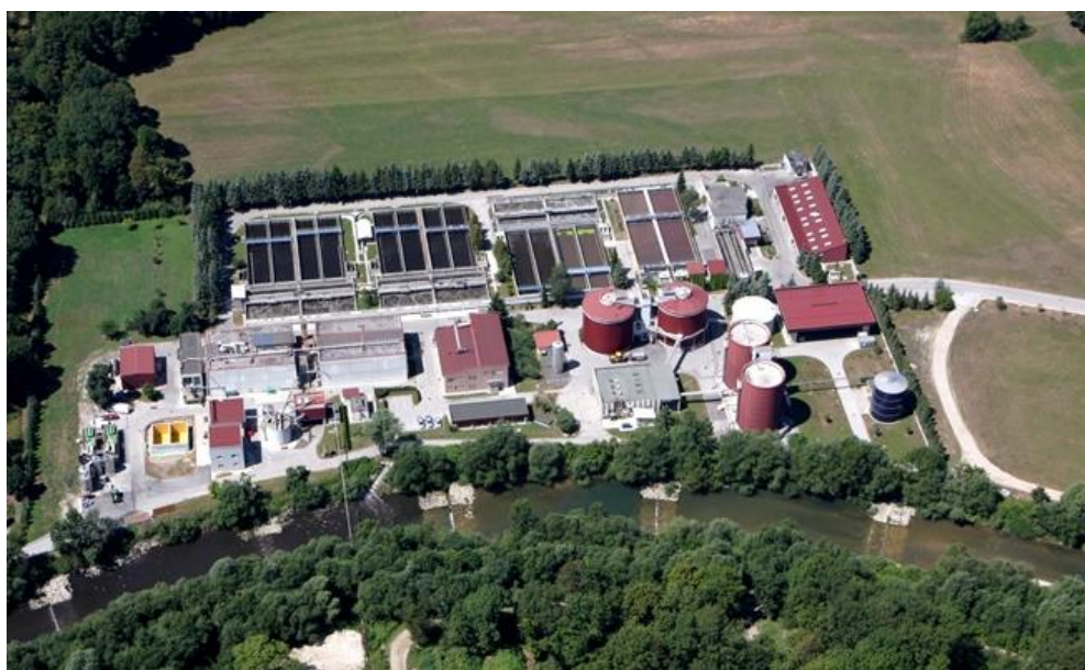
Slika 4: Pogled na CČN Domžale - Kamnik iz zraka
