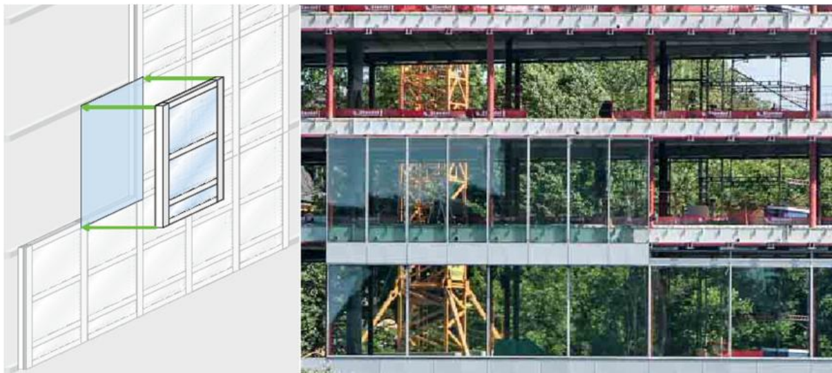
Slika 32: Montaža element fasade (Schüco Elementfassaden Prospekt, 2009: str. 7)
