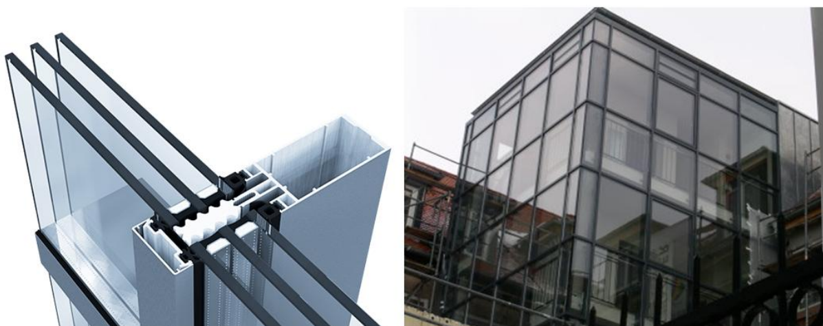
Slika 36: Klasična aluminijasta fasada s pokrivnim profilom ( http://www.akootherm.de/systeme/fassaden/at500cc/ in http://www.sartorius-metalltechnik.de/html/pr-fassade.html )
