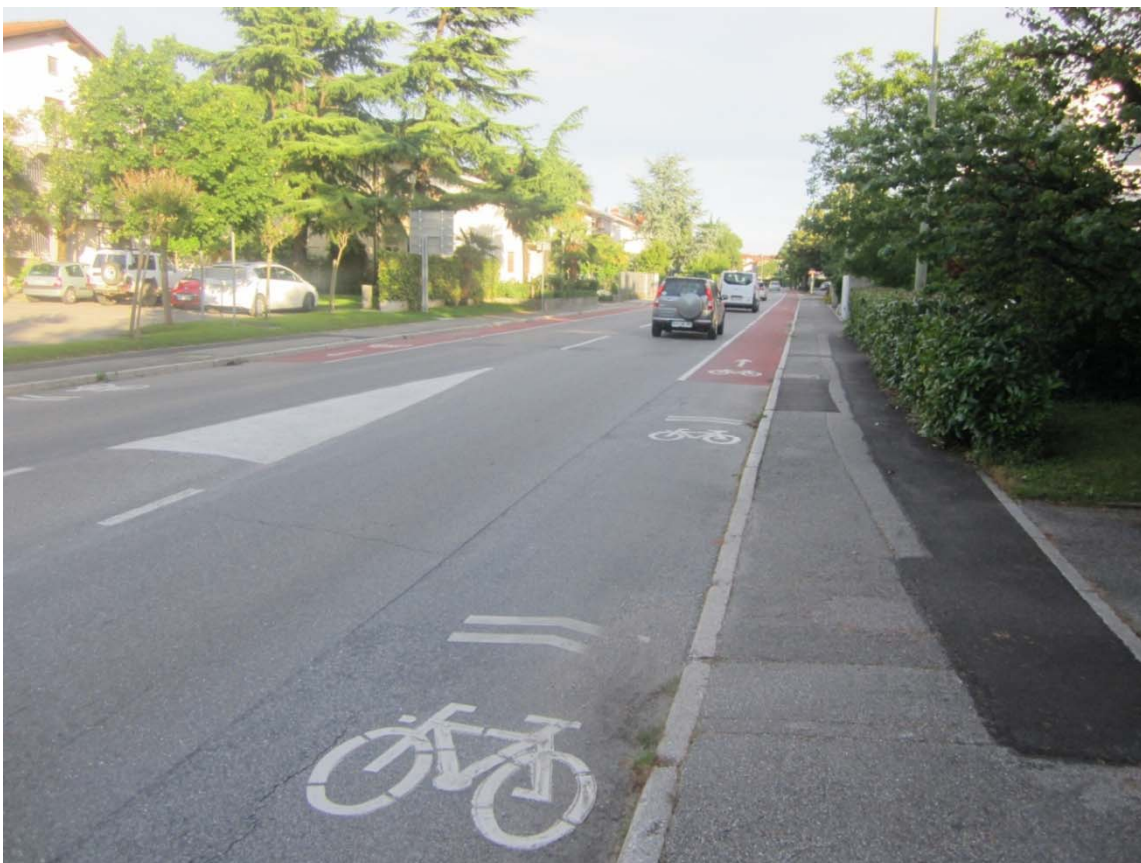
Slika 21: Primer prehoda iz mešane površine v kolesarski pas širine 1,5 m (Foto: Tavčar I.)
