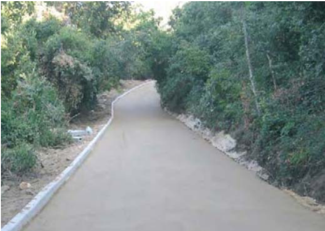
Slika 60: Stabilizirana tla na terenu (Azichem srl 2009: str. 1)
