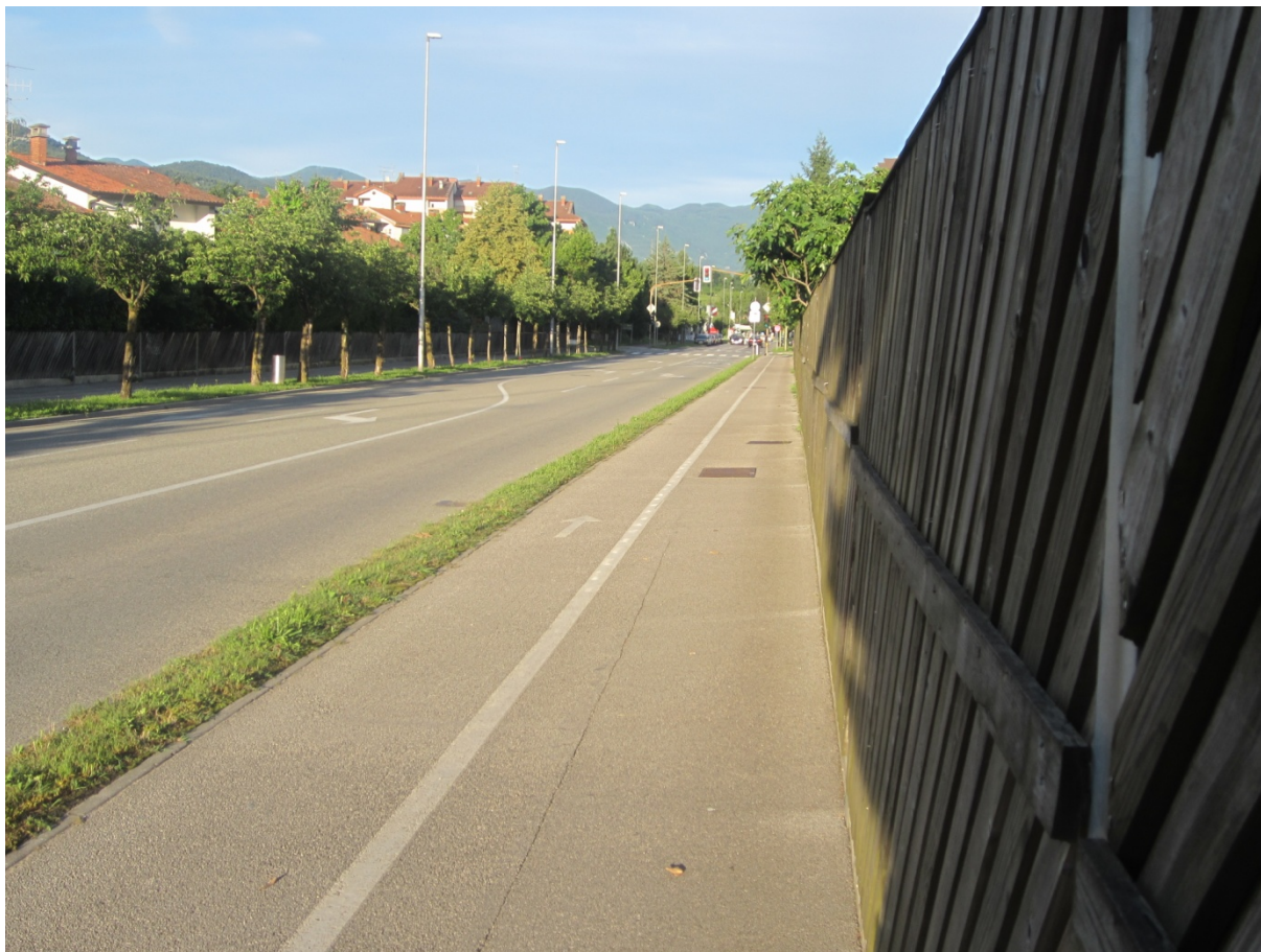
Slika 22: Primer ločene steze za kolesarje in pešce na pločniku (Foto: Tavčar I.)
