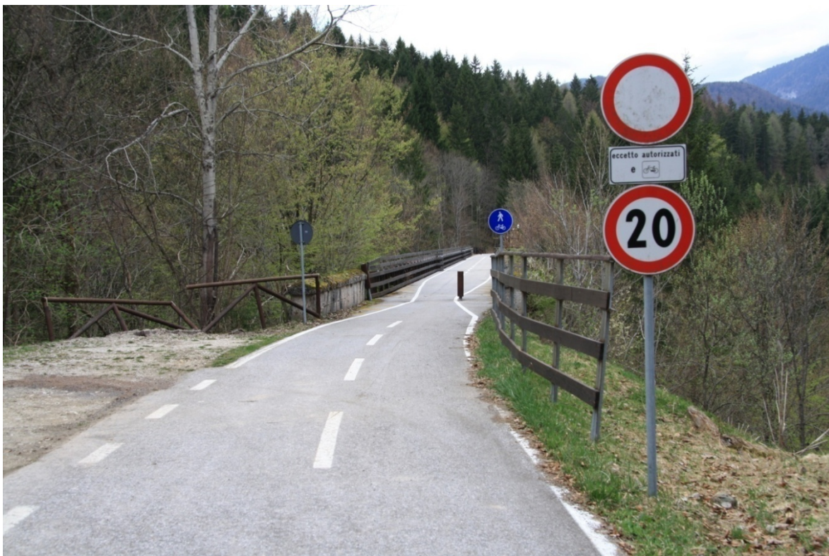
Slika 71: Zaključek odseka od glavne ceste do počitniškega objekta z nadaljevanjem poti za kolesarje in pešce (Foto: Tavčar I.)
