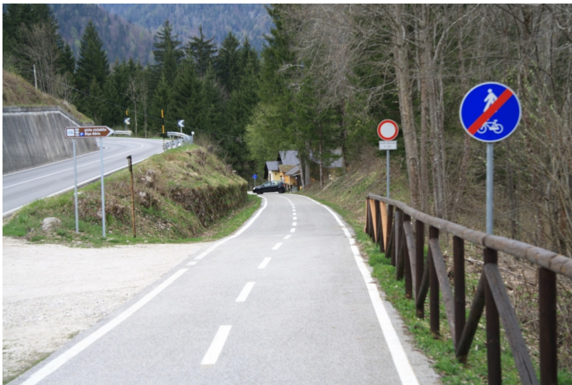
Slika 68: Dostop do stanovanjskih objektov s prometno signalizacijo (Foto: Tavčar I.)
