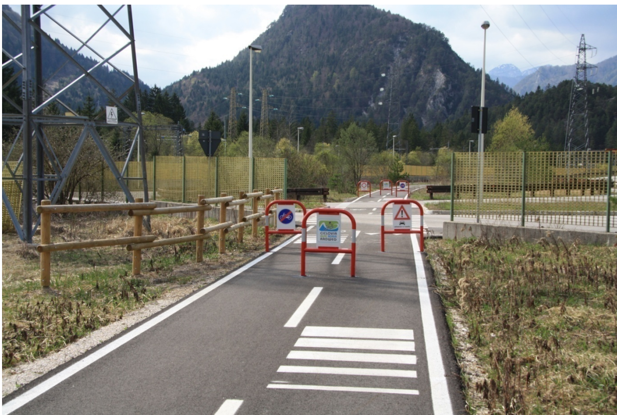
Slika 57: Republika Italija – križanje kolesarske poti in primestne ceste, kjer je kolesarjem odvzeta prednost s postavljenimi ovirami in horizontalno označbo optična zavora (Foto: Tavčar I.)
