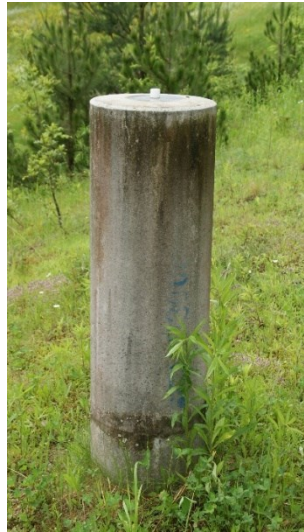
Slika 5: Stabilizacija opazovalnih stebrov (Kogoj et al., 2009; 14)
