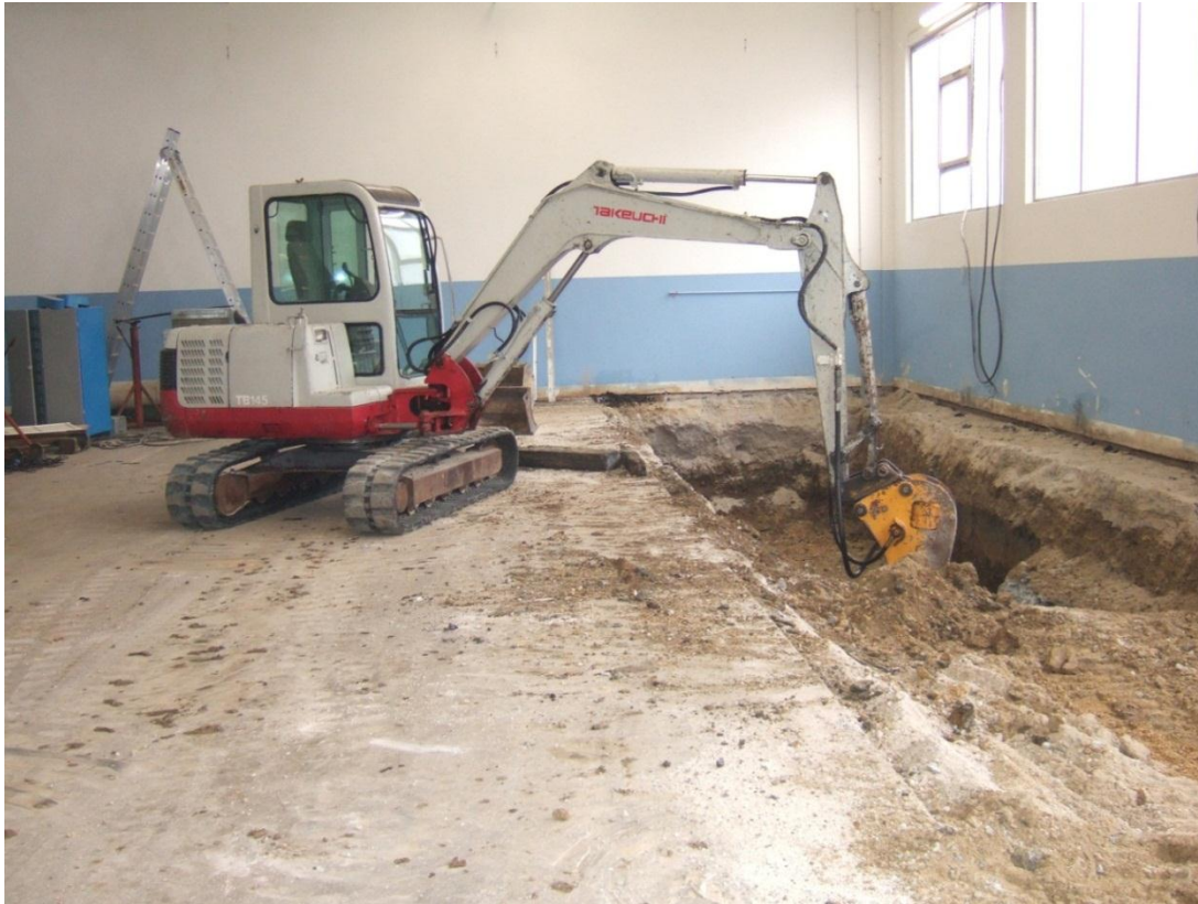
Slika 3: Izkop za servisni kanal
