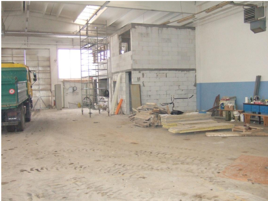
Slika 4: Izvedba pisarne v objektu
